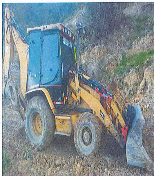
Retroexcavadora sobre llantas
