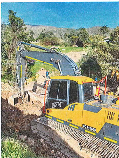
Retroexcavadora sobre oruga
