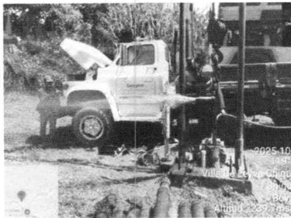
Figura 11 Aplicación de aire con compresor Pozo
