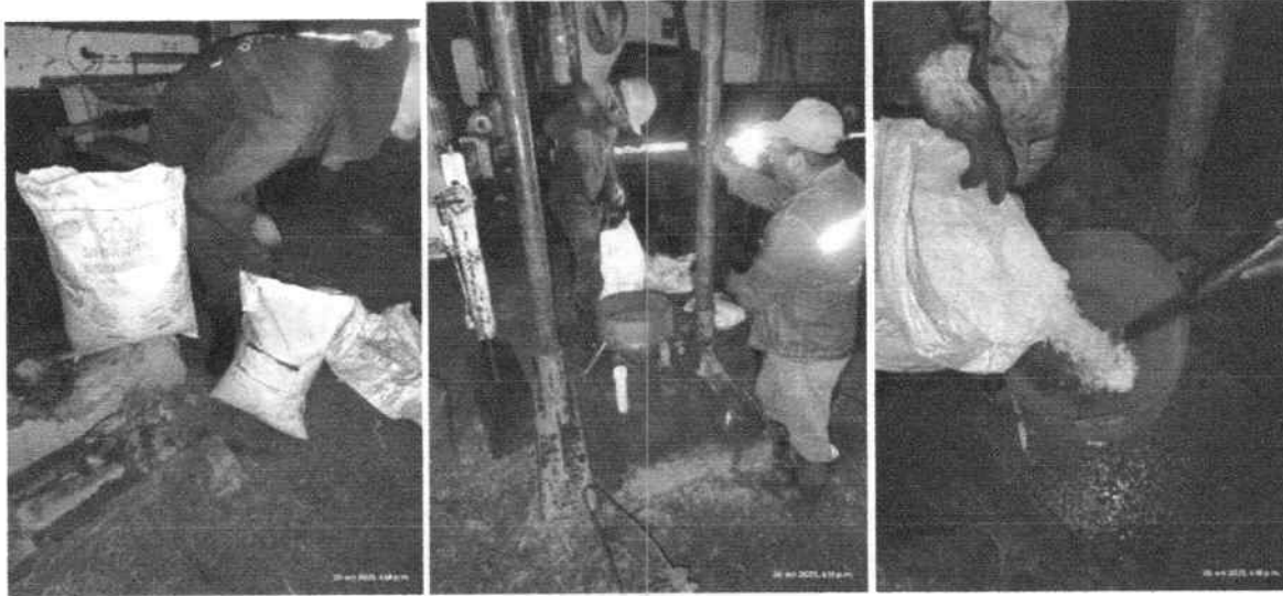
Figura 8 Adición de químicos
