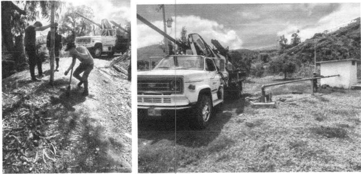
Figura 2. Acondicionamiento de vía y traslado de equipos.
