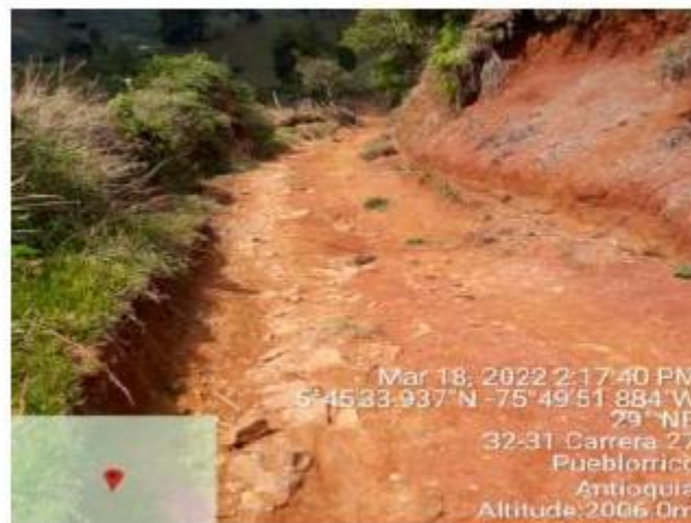
Ilustración 4. Estado inicial de la vía.
