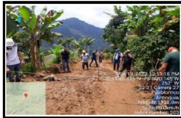
Ilustración 6. Estado de la vía.
