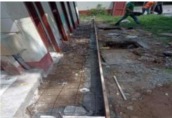
ANDEN Y PISOS EN CONCRETO DE 3000 PSI
