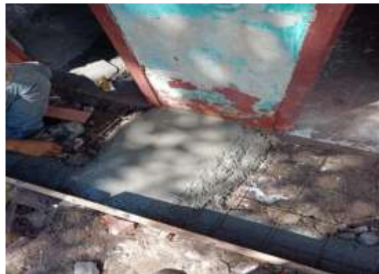
ANDEN Y PISOS EN CONCRETO DE 3000 PSI
