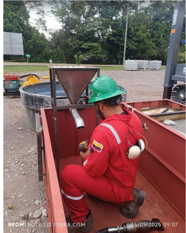
instalación de tanque de lodos en el terreno
