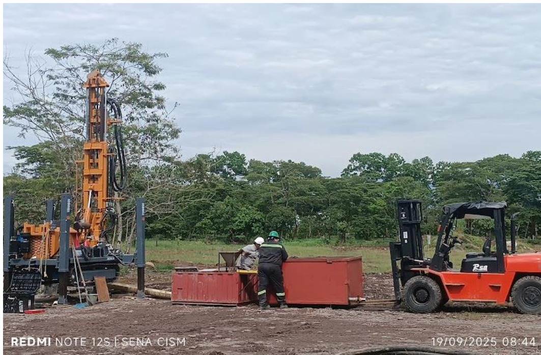
Instalación del sistema de perforación 2.0
