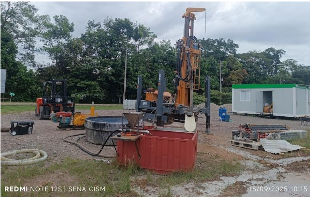
Sistema de perforación 1.0 instalado
