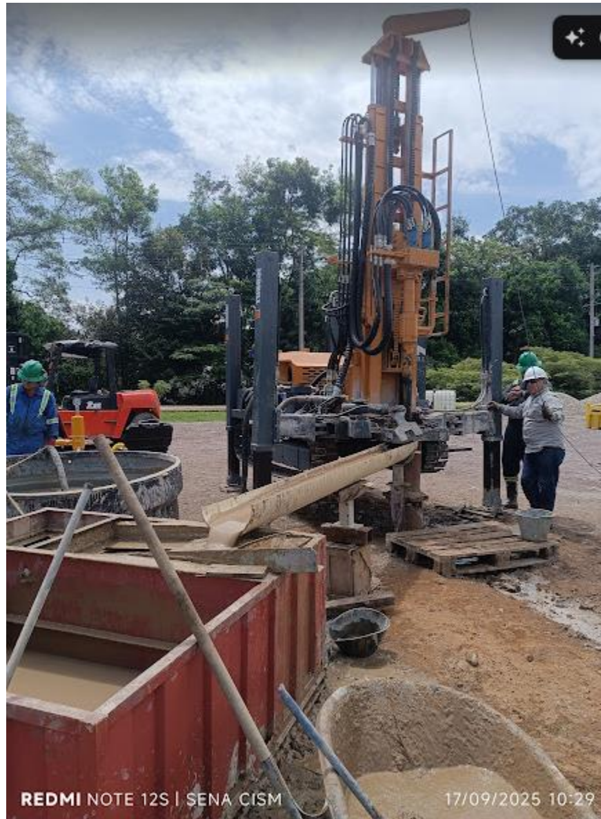
Re inicio de la perforación
