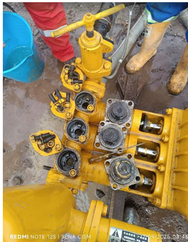
Mantenimiento a bomba de lodos
