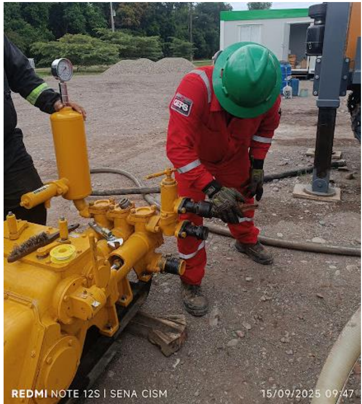
instalación de adaptador.
