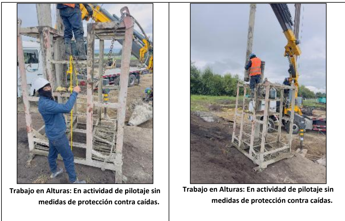
Figura 39 Trabajo en alturas.
