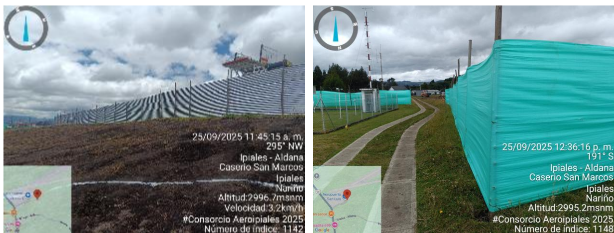
Figura 47 Cerramiento con Lona
