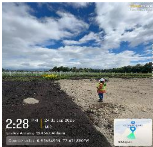
Figura 31 Verificación posibles afectaciones por actividades del proyecto
