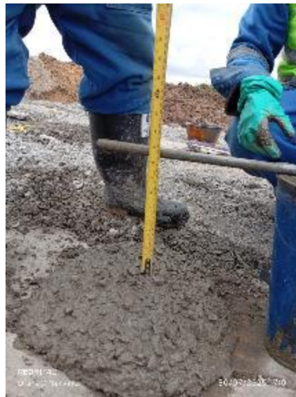
Figura 52 Prueba de asentamiento para el pilote No. 16, Torre de Control
