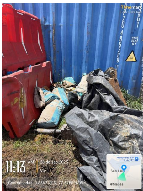
Figura 43 Inadecuado Manejo de Residuos Peligrosos
