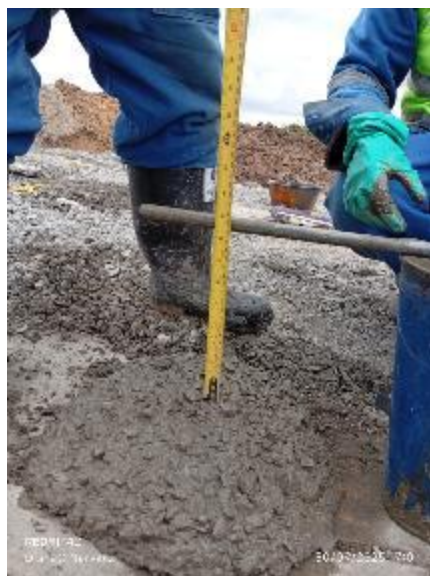
Figura 47 Prueba de asentamiento para el pilote No. 27, Torre de Control
