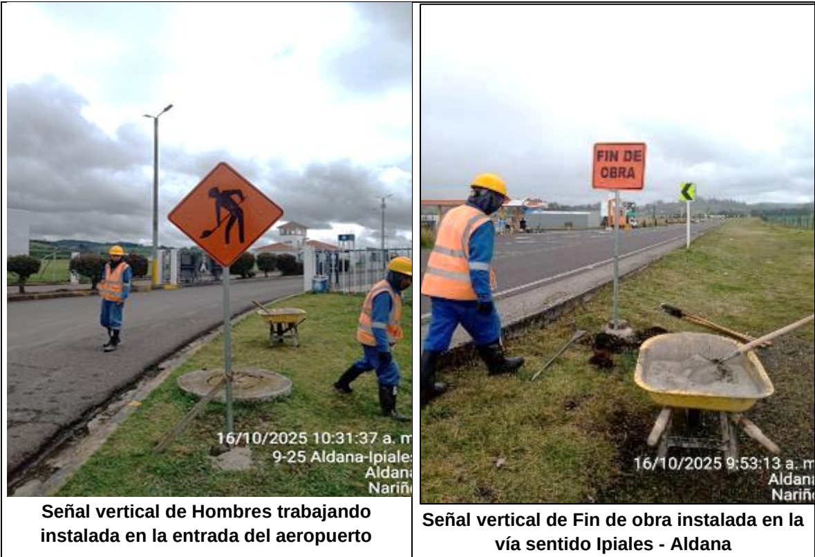
Figura 32 Instalación de señalización.
