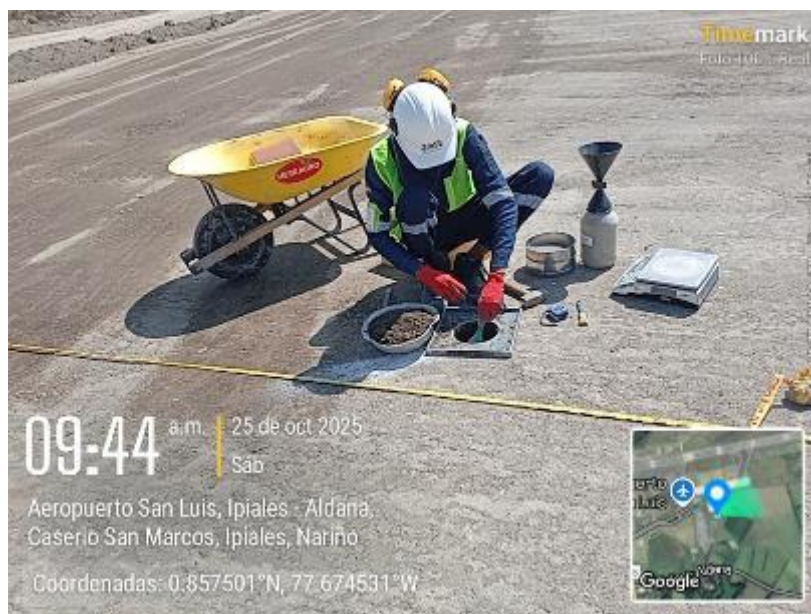
Figura 48 Ejecución ensayo de Cono de Arena in situ para determinar densidades
