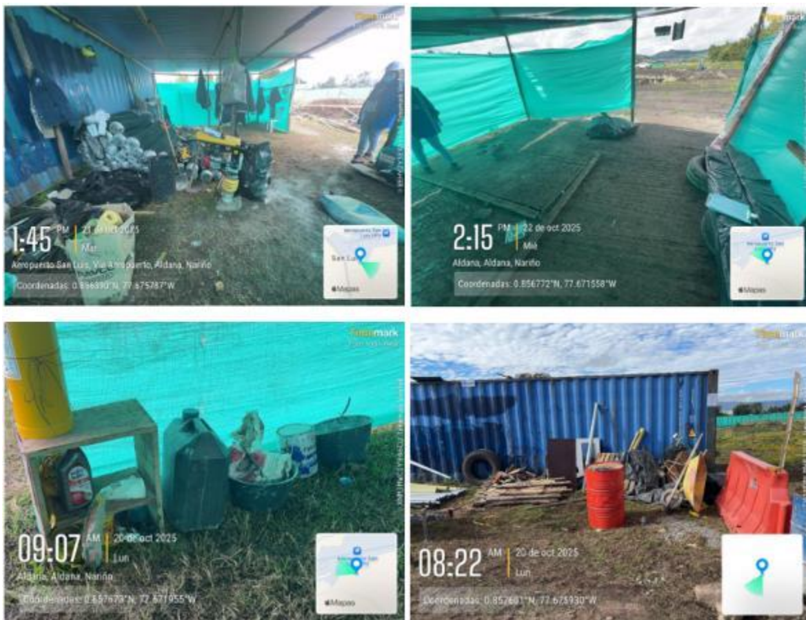
Figura 45 Campamentos y Bodega
