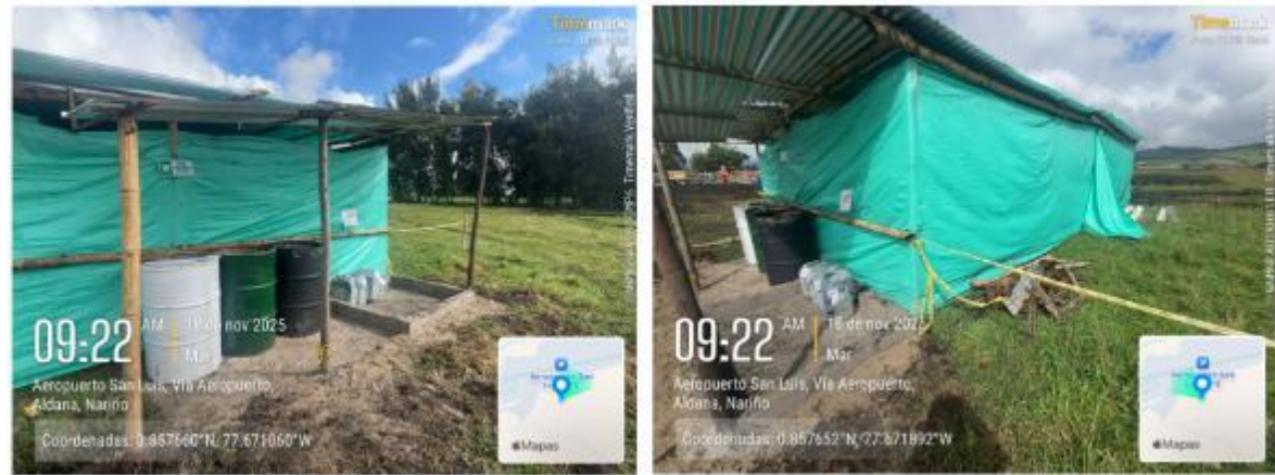
Figura 38 Inadecuado almacenamiento de sustancias químicas
