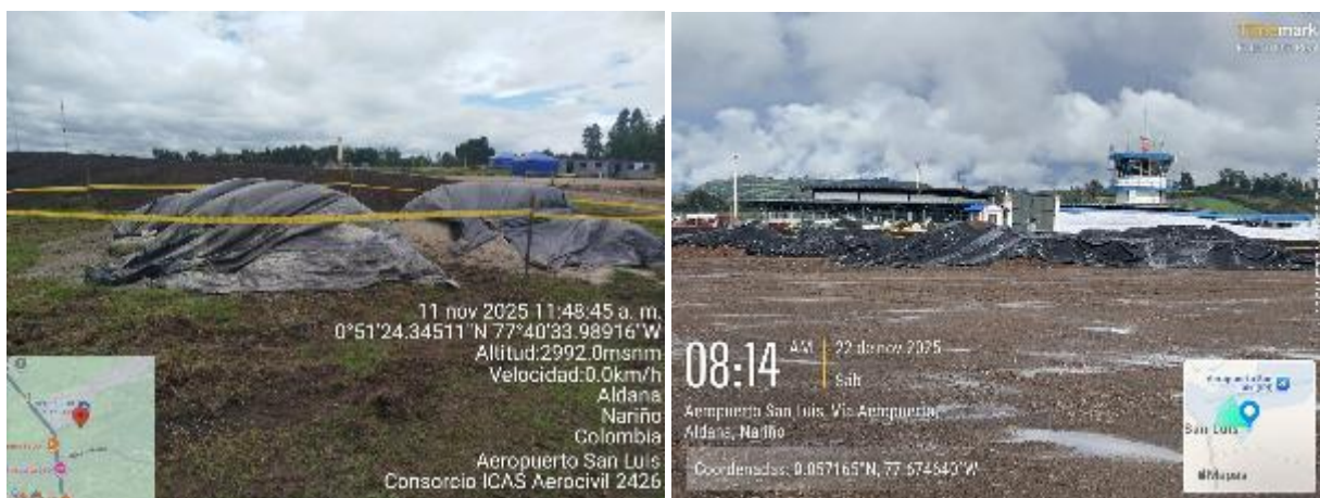
Figura 35 Almacenamiento de material
