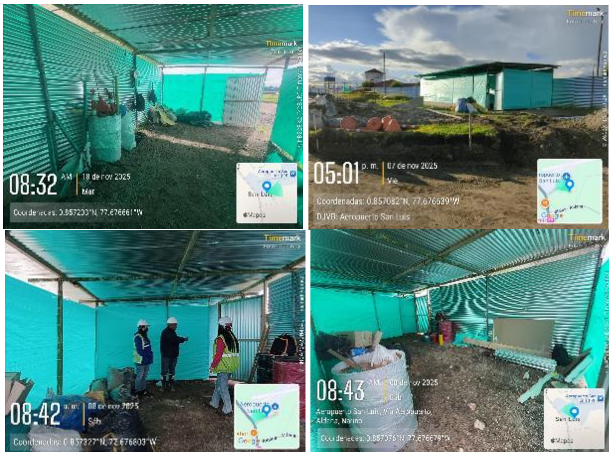
Figura 29 Almacenamiento Temporal de Residuos.
