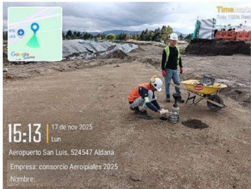
Figura 40 Ejecución ensayo de Cono de Arena in situ para determinar densidades
