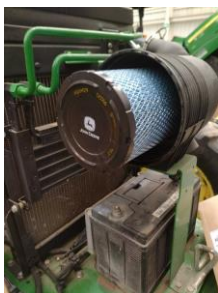
Observación:instalación filtro de aire primario
