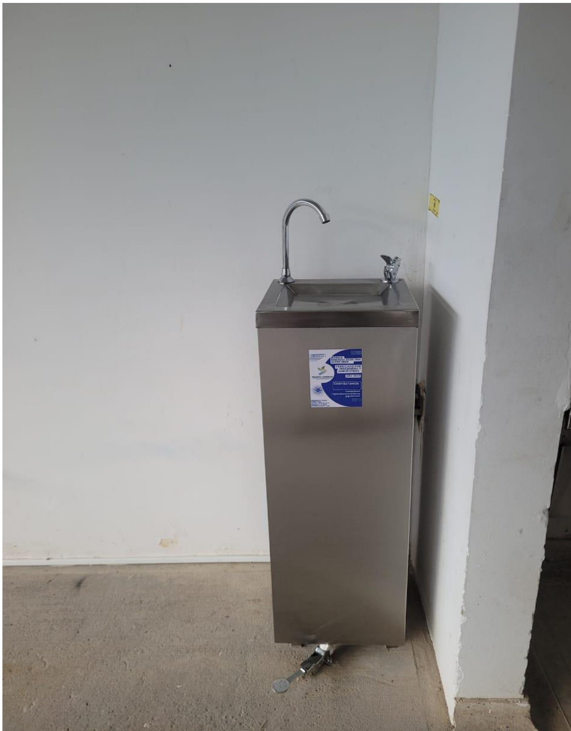
Bebedero Segundo piso
