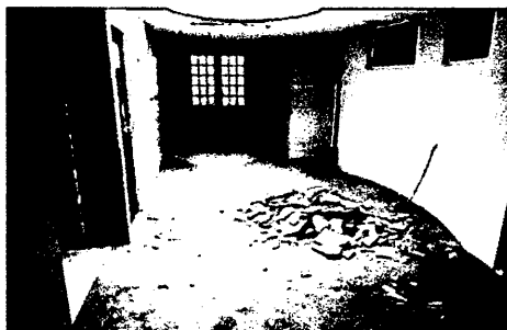
Demolicion de acabado de piso.
