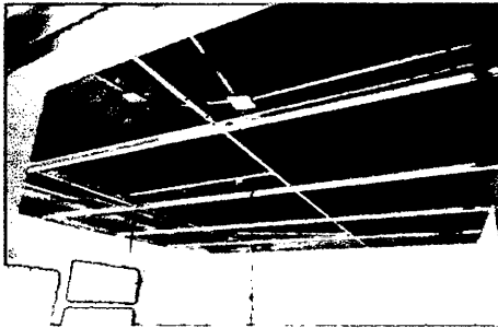
Instalación de cielo raso en PVC.
