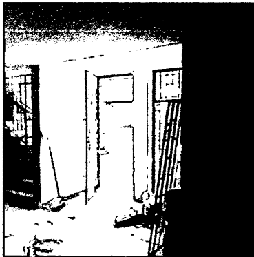
Desmonte de puerta y marco metalico.
