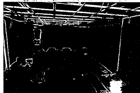
Instalación de cielo raso en PVC.
