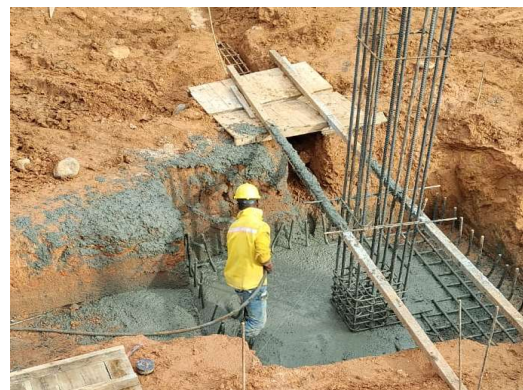
Imagen. 10 Construcción de zapatas
