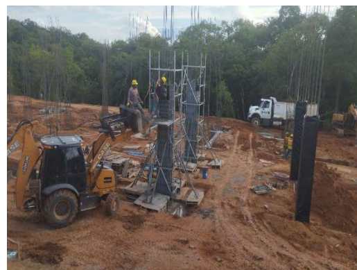
Imagen. 14 Construcción de columnas
