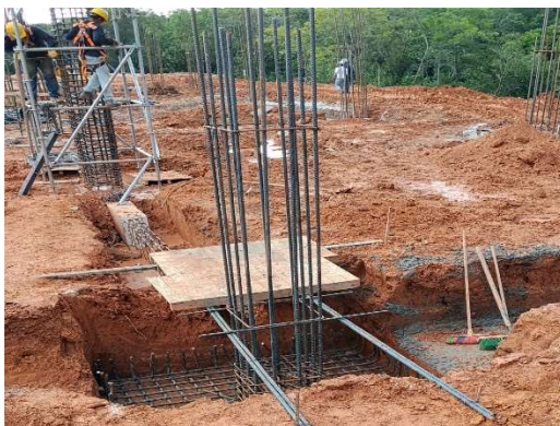
Imagen. 9 Instalación de acero
