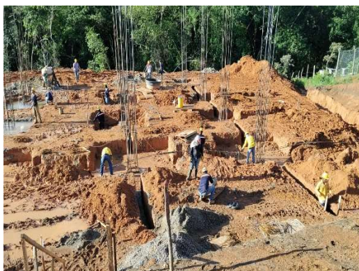
Imagen. 13 Cimentación y estructura
