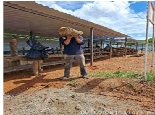
Imagen. 28 Aseo de obra
