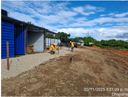
Imagen. 25 Construcción de zona peatonal
