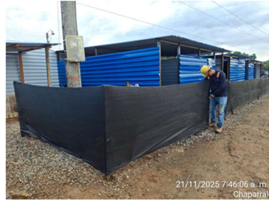
Imagen. 26 Instalación de polisombra
