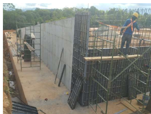
Imagen. 18 Construcción de muro
