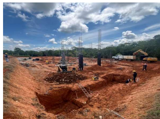
Imagen. 12 Construcción de cimentación
