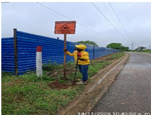
Imagen. 23 Instalación de señales en obra
