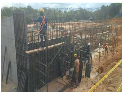
Imagen. 17 Instalación de acero en muro
