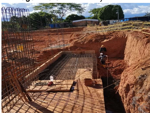
Imagen. 15 Muro de contención
