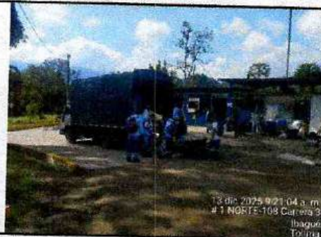
TURBOCAMIÓN TMZ 690 - RECOGIENDO PERSONAL Y MATERIALES - PLANTA IBAL BARRIO LA POLA
