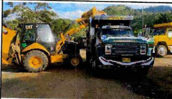
RETROEXCAVADORA CAT 420E Y VOLQUETA AKI 237 - CARGANDO MATERIAL PLANTA IBAL BARRIO LA POLA
