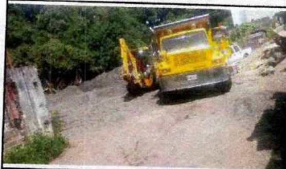
VOLQUETA BUM 756 Y RETROEXCAVADORA JOHN DEERE 310G - BARRIO EL ARADO
