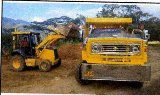
RETROEXCAVADORA JOHN DEERE Y VOLQUETA OVD 527 CARGANDO MATERIAL - PLANTA IBAL BARRIO LA POLA
