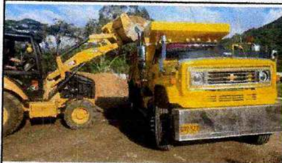
RETROEXCAVADORA CAT 420E Y VOLQUETA OVD 527 - CARGANDO MATERIAL PLANTA IBAL BARRIO LA POLA
