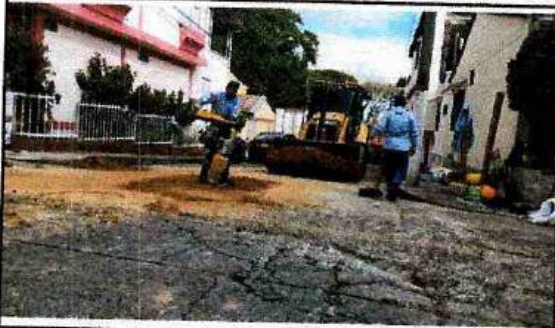
RETROEXCAVADORA CAT 416 Y SALTARIN - TAPANDO EN BARRIO PRIMAVERA ENTRE RÍOS
