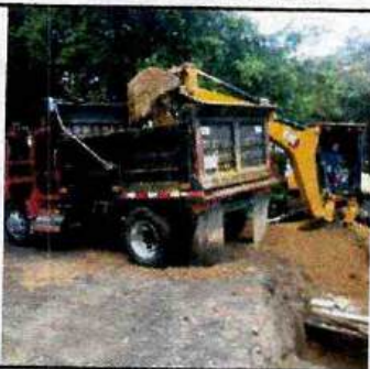
RETROEXCAVADORA CAT 416 Y VOLQUETA UNB 055 CARGANDO MATERIAL EN LA 5A
