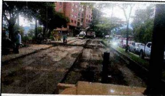
RETROEXCAVADORA CAT 416 - CALLE 57 CON 5A
