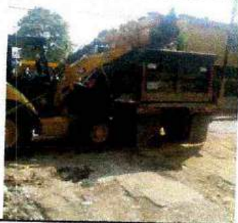
RETROEXCAVADORA CAT 420E Y VOLQUETA UNB 055 - CARGANDO MATERIAL BARRIO EL LIMONAR
