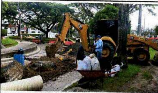
RETROEXCAVADORA CAT 416 - CALLE 44
