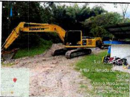
RETROEXCAVADORA DE ORUGAS KOMATSU PC200 - BOCATOMA COMBEIMA
