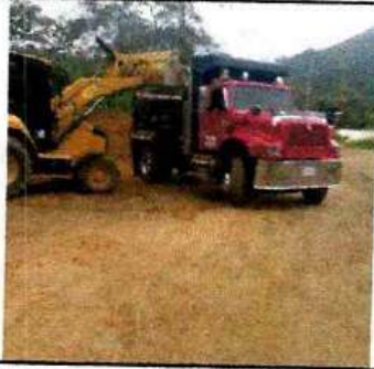
RETROEXCAVADORA CAT 416 Y VOLQUETA UNB 055 - CARGANDO RESEVO - PLANTA IBAL BARRIO LA POLA
