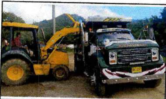
RETROEXCAVADORA JOHN DEERE Y VOLQUETA AKI 237 CARGANDO TRITURADO - PLANTA IBAL BARRIO LA POLA
