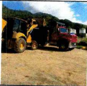
RETROEXCAVADORA 416 - CARGANDO MATERIAL - PLANTA IBAL BARRIO LA POLA
