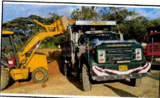
RETROEXCAVADORA JOHN DEERE 310G Y VOLQUETA AKI 237 - CARGANDO MATERIAL PLANTA IBAL BARRIO LA POLA
