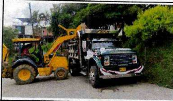
RETROEXCAVADORA JOHN DEERE 310G - CARGANDO MATERIAL - MURILLO TORO
