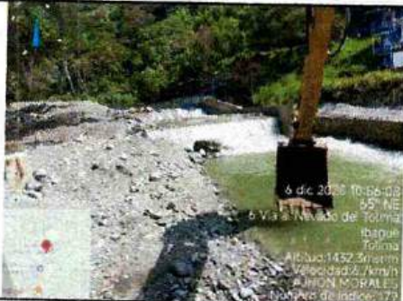
RETROEXCAVADORA DE ORUGAS PC200 - BOCATOMA COMBEIMA
