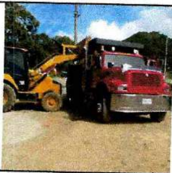
RETROEXCAVADORA CAT 416 Y VOLQUETA UNB 055 - CARGANDO TRITURADO - PLANTA IBAL BARRIO LA POLA
