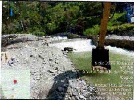
RETROEXCAVADORA DE ORUGAS PC200 -REALIZANDO LABORES DE LIMPIEZA BOCATOMA COMBEIMA
