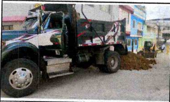
VOLQUETA AKI 237 - DESCARGANDO MATERIAL - BARRIO MALABAR
