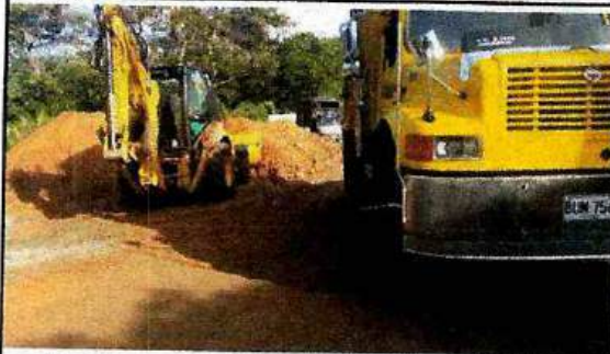
RETROEXCAVADORA CAT 420E Y VOLQUETA BUM 756 - CARGANDO MATERIAL PLANTA IBAL BARRIO LA POLA
