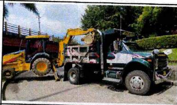
RETROEXCAVADORA JOHN DEERE 310G Y VOLQUETA AKI 237 - CARGANDO MATERIAL CORTOLIMA
