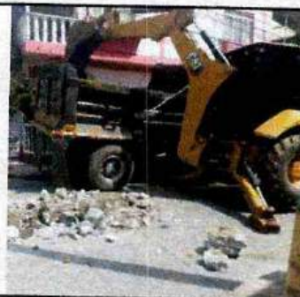
RETROEXCAVADORA CAT 420E CARGANDO TIERRA A VOLQUETA UNB 055 - PRIMAVERA ENTRE RÍOS
