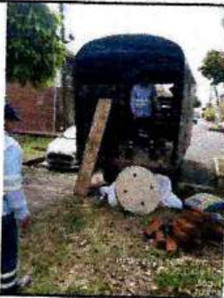
TURBOCAMIÓN SPL 933 - DESCARGANDO PERSONAL Y MATERIALES - BARRIO AGUA MARINA
