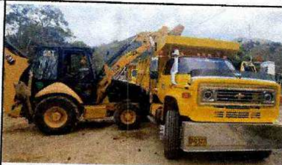
RETROEXCAVADORA CAT 420E CARGANDO MATERIAL A VOLQUETA OVD 527 - PLANTA IBAL BARRIO LA POLA
