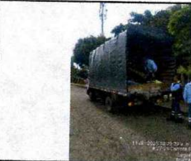
TURBOCAMIÓN TMZ 690 - DESCARGANDO PERSONAL Y MATERIALES - BARRIO CAÑAVERAL
