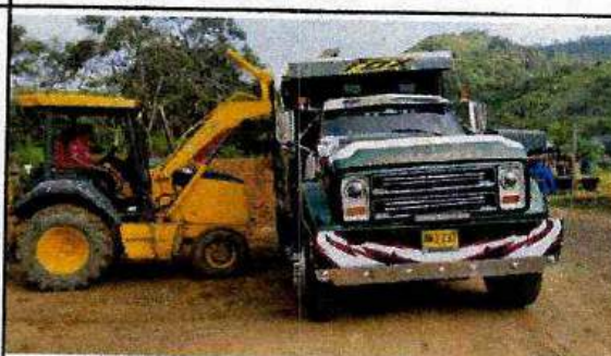
RETROEXCAVADORA JOHN DEERE 310G - CARGANDO MATERIAL - PLANTA IBAI BARRIO LA POLA
