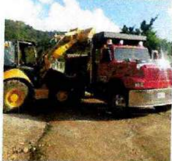
RETROEXCAVADORA CAT 420E Y VOLQUETA UNB 055 - CARGANDO MATERIAL PLANTA IBAL BARRIO LA POLA
