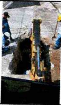
RETROEXCAVADORA CAT 416 - EXCAVACIÓN - BARRIO PRIMAVERA ENTRE RÍOS
