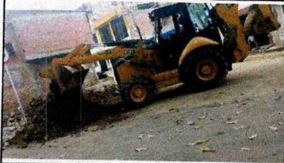
RETROEXCAVADORA CAT 420E - LIMPIEZA BARRIO SAN LUIS
