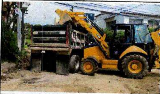
RETROEXCAVADORA CAT 420E Y VOLQUETA AKI 237 - CARGANDO MATERIAL BARRIO EL LIMONAR
