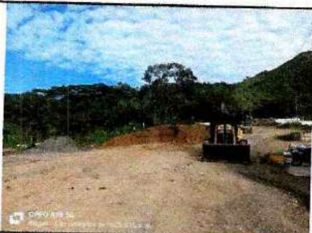
RETROEXCAVADORA 416 - ACOPLANDO MATERIAL - PLANTA IBAL BARRIO LA POLA
