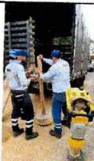
TURBO CAMIÓN SPL 933 - DESCARGANDO PERSONAL Y EQUIPO SALTARIN - PLANTA IBAL BARRIO LA POLA
