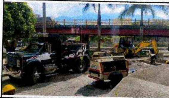
RETROEXCAVADORA JOHN DEERE 310G Y VOLQUETA AKI 237 - CARGANDO MATERIAL 42 CON 5A
