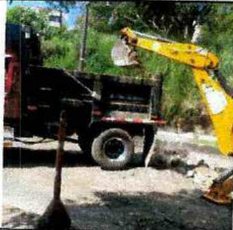
VOLQUETA UNB 055 - CARGANDO MATERIAL - CARRERA 5A
