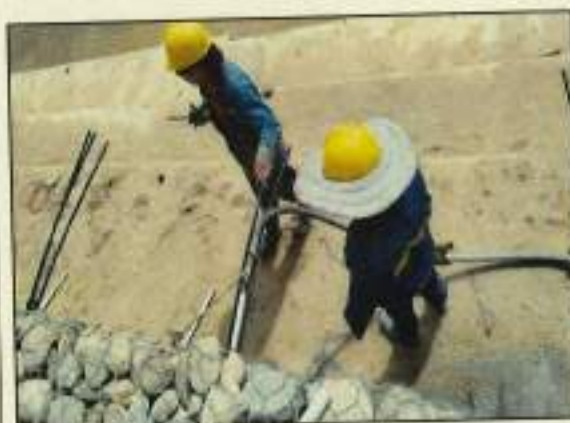
Llenado e inyección de anclajes
