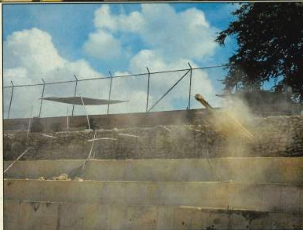
Ejecución de perforación horizontal para anclajes de 0,00m a 15,00 m
