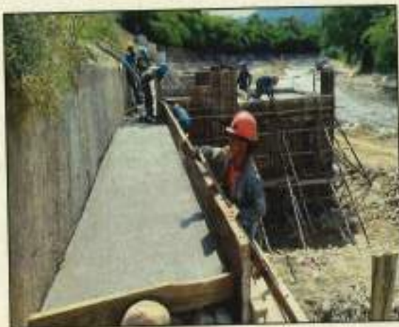
Suministro de concreto de 3.000 psi para recubrimiento de los gaviones
