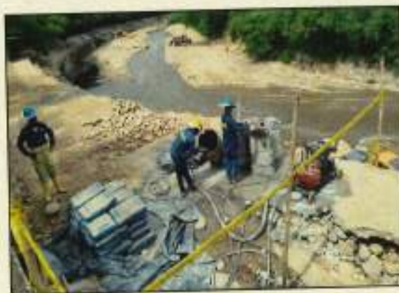
Llenado e inyección de anclajes
