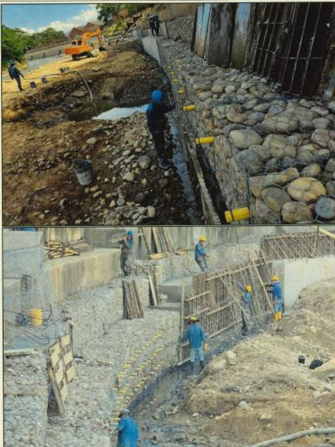
Suministro e instalación de tubería sanitaria de 2" pasamuros o lloraderos
