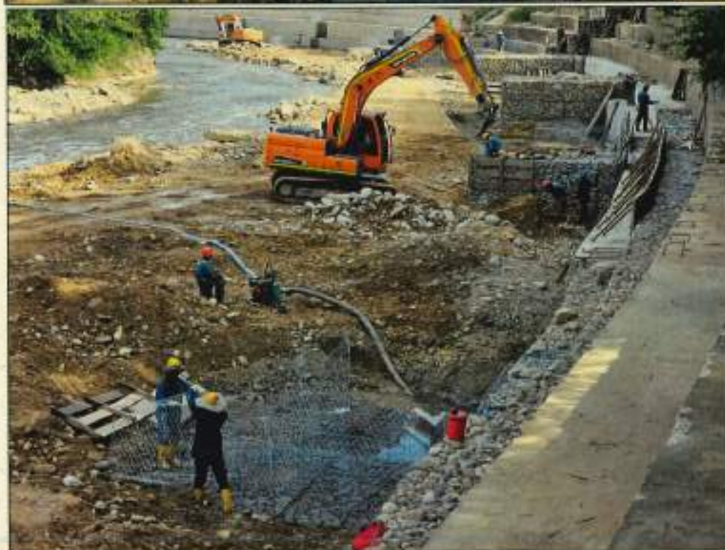
Gaviones con malla electrosoldada
