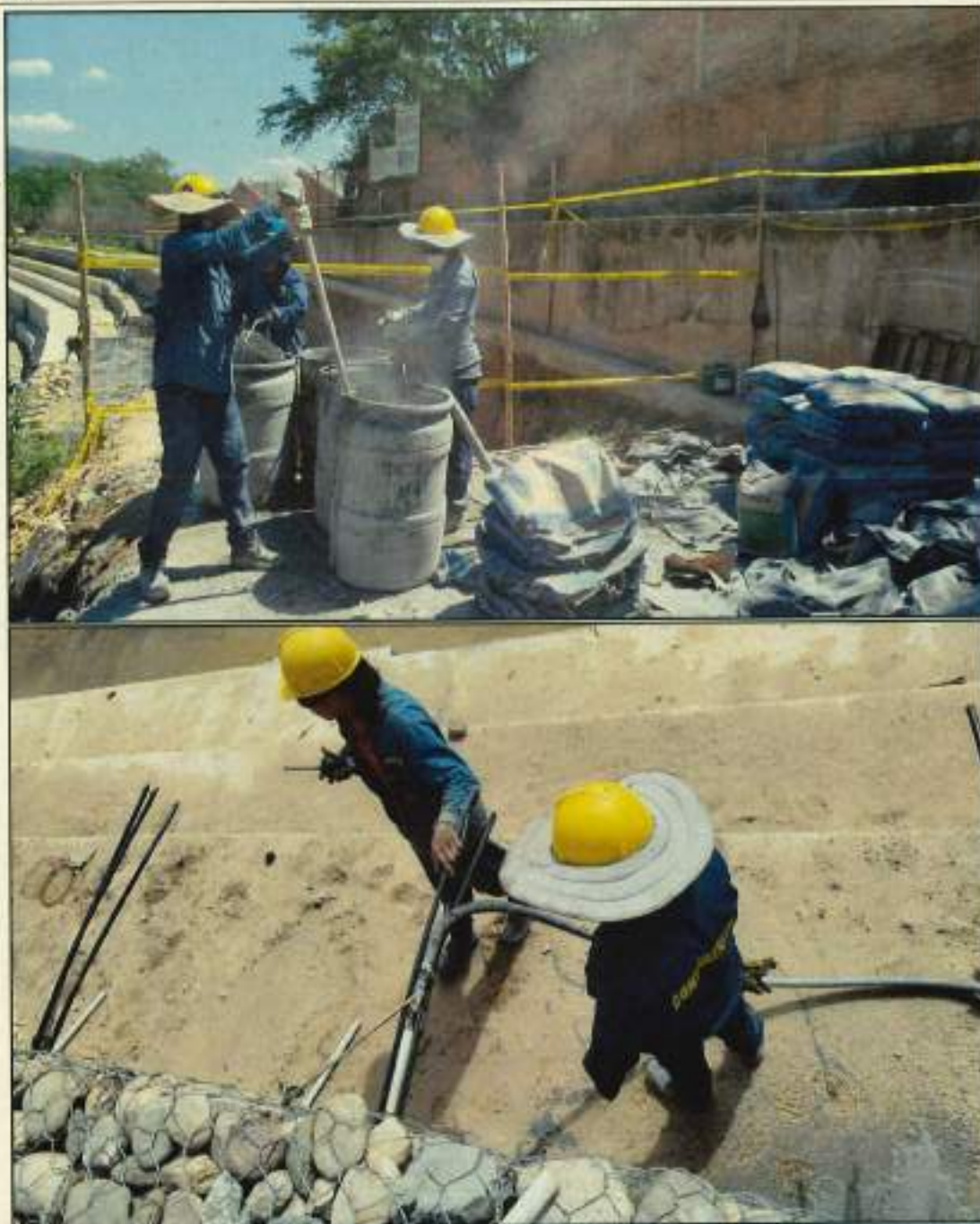
Llenado e inyección de anclajes
