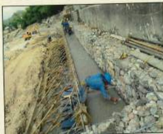
Suministro de concreto de 3.000 psi para recubrimiento de los gaviones
