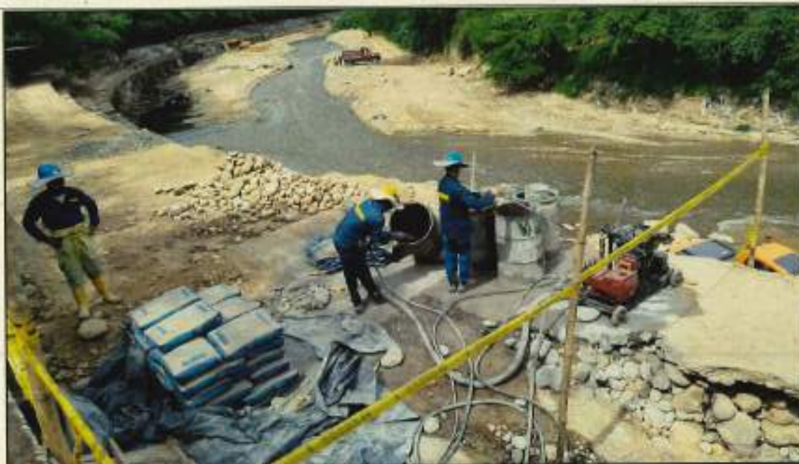
Llenado e inyección de anclajes
