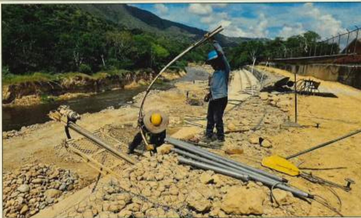
Suministro e instalación de anclajes.
