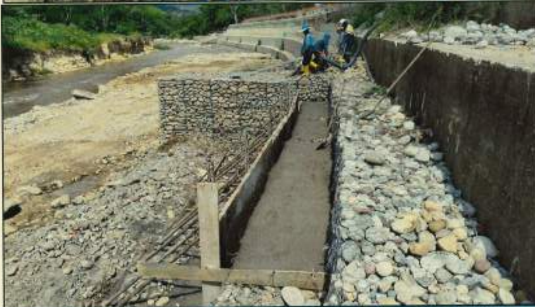
Suministro de concreto de 3.000 psi para recubrimiento de los gaviones
