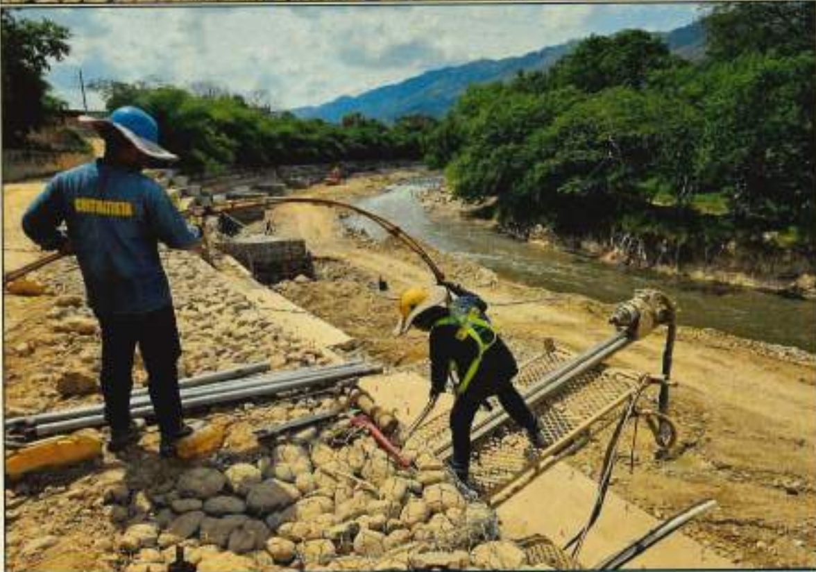
Suministro e instalación de anclajes.
