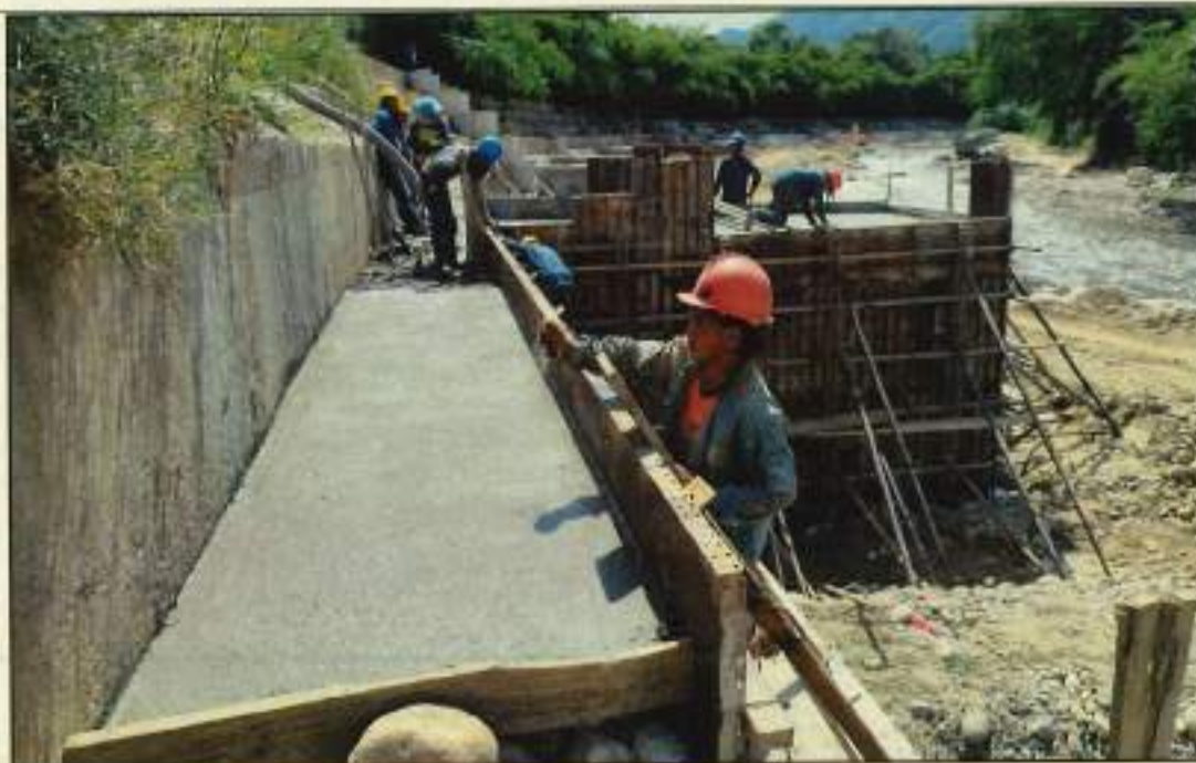
Suministro de concreto de 3.000 psi para recubrimiento de los gaviones
