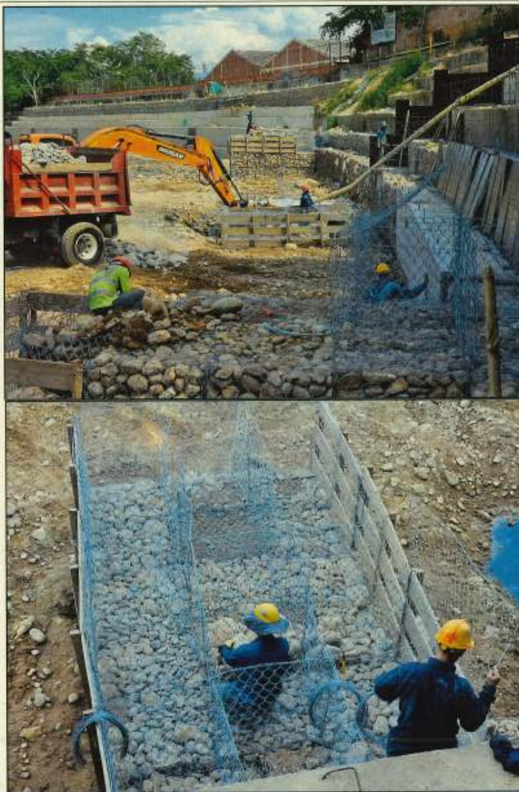
Gaviones con malla electrosoldada
