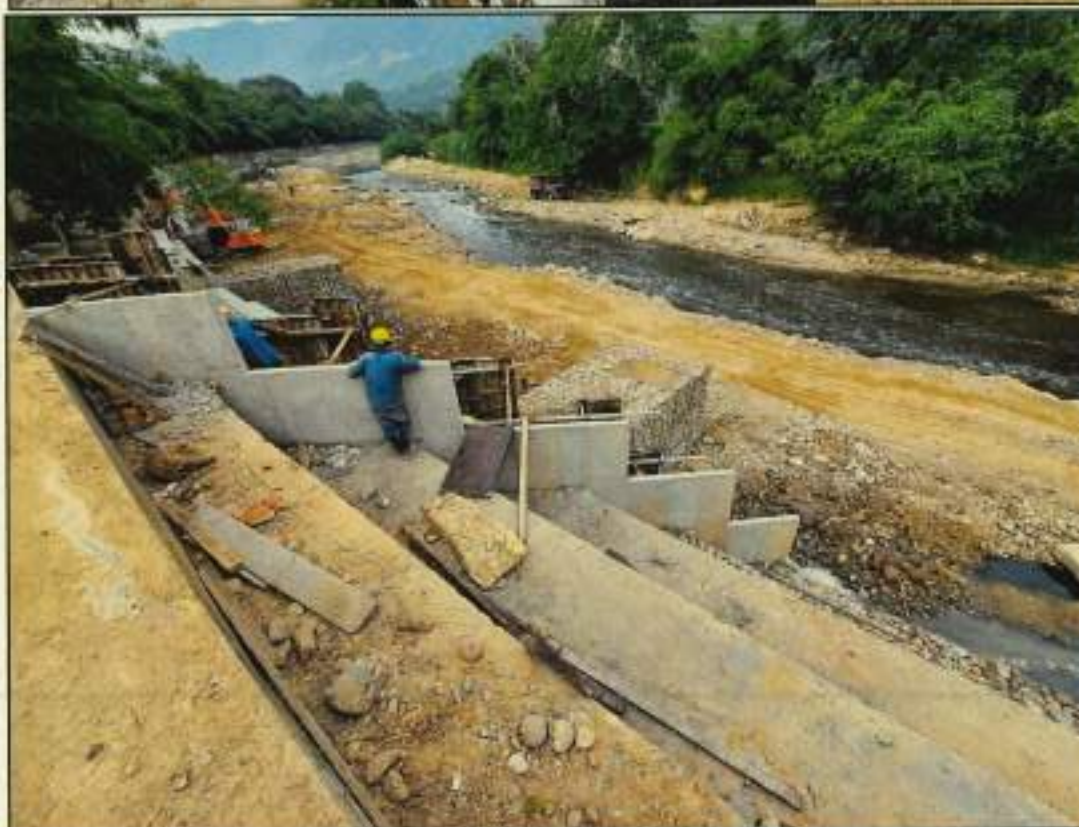
Estructura de disipación de energía
