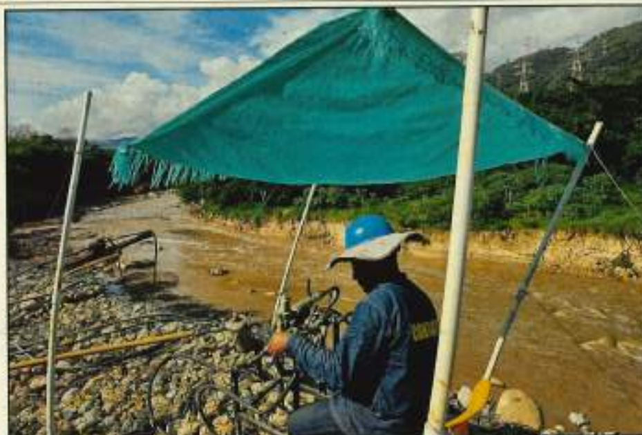
Ejecución de perforación horizontal para anclajes de 0,00m a 15,00 m
