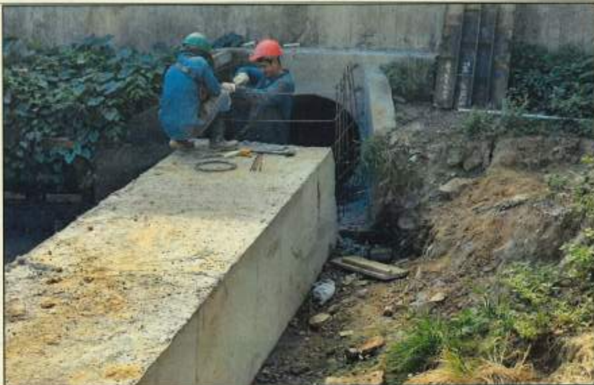
Estructura de disipación de energía
