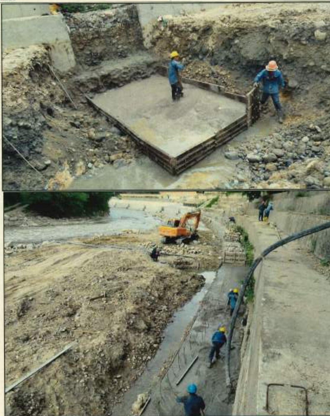
Suministro de concreto para solado.
