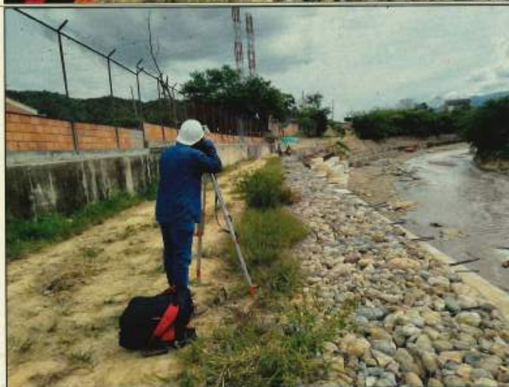
Trabajos de topografía.
