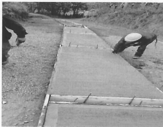
CONCRETO RESISTENCIA 14 MPA (G) (CICLOPEO) ZARZAL
