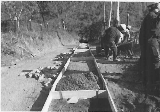
SUMINISTRO, EXTENDIDA Y COMPACTACION DE MATERIAL SELECCIONADO PARA SUBBASE GRANULAR (INCLUYE ACARREO LIBRE DE 5KM) ZARZAL
