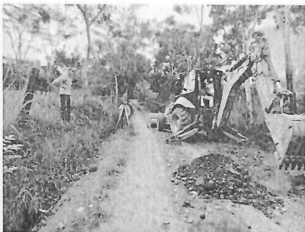
EXCAVACIÓN DE CORTES, CANALES Y PRETAMOS EN MATERIAL COMÚN A MAQUINA INCLUYE CARGUE Y ACARREO LIBRE DE 5 KM ZARZAL
