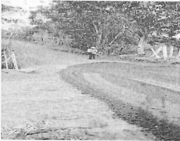
SUMINISTRO, EXTENDIDA Y COMPACTACION DE MATERIAL SELECCIONADO PARA SUBBASE GRANULAR (INCLUYE ACARREO LIBRE DE 5KM) ZARZAL
