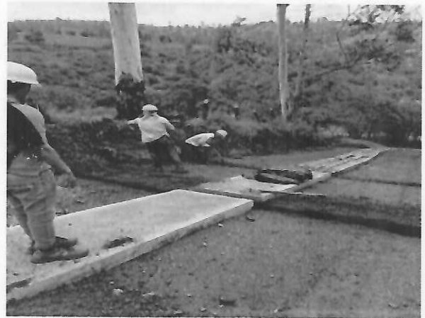
SUMINISTRO, EXTENDIDA Y COMPACTACION DE MATERIAL SELECCIONADO PARA SUBBASE GRANULAR (INCLUYE ACARREO LIBRE DE 5KM) ZARZAL
