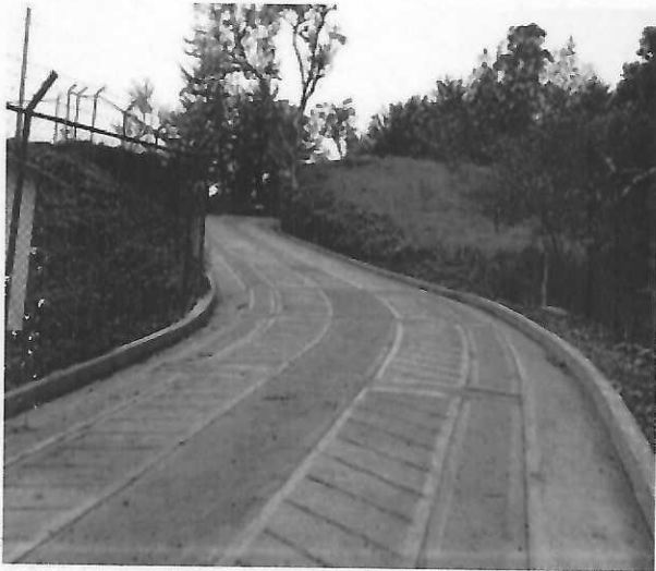
CONSTRUCCION DE PLACA HUELLA, SUMINISTRO, EXTENDIDA Y COMPACTACION DE MATERIAL SELECCIONADO PARA SUBBASE GRANULAR (INCLUYE ACARREO LIBRE DE 5KM
