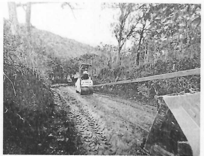
SUMINISTRO, EXTENDIDA Y COMPACTACION DE MATERIAL SELECCIONADO PARA SUBBASE GRANULAR (INCLUYE ACARREO LIBRE DE 5KM) ZARZAL
