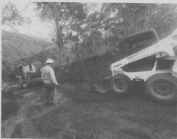
CONSTRUCCIÓN DE FILTROS A CUALQUIER PROFUNDIDAD, CON MATERIAL FILTRANTE SEGÚN NORMA INVIAS, SIN EXCAVACIÓN, INCLUYE GEOTEXTIL NT 2000 ZARZAL
