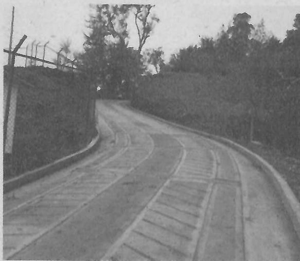
CÓNSTRUCCION DE PLACA HUELLA, SUMINISTRO, EXTENDIDA Y COMPACTACION DE MATERIAL SELECCIONADO PARA SUBBASE GRANULAR (INCLUYE ACARREO LIBRE DE 5KM
