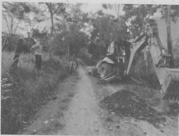
EXCAVACIÓN DE CORTES, CANALES Y PRETAMOS EN MATERIAL COMÚN A MAQUINA INCLUYE CARGUE Y ACARREO LIBRE DE 5 KM ZARZAL
