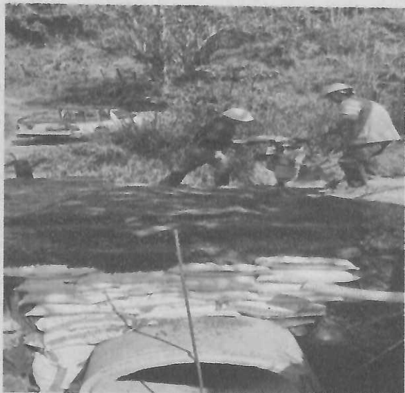
MEJORAMIENTO DE PISO CON MATERIAL DE AFIRMADO COMPACTADO CON PLANCHA VIBRADORA, INCLUYE ACARREO LIBRE DE 5 KM Y CONSTRUCCION DE ALCANTARILLA ZARZAL
