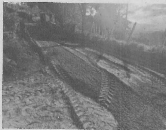
CONSTRUCCIÓN DE FILTROS A CUALQUIER PROFUNDIDAD, CON MATERIAL FILTRANTE SEGÚN NORMA INVIAS, SIN EXCAVACIÓN, INCLUYE GEOTEXTIL NT 2000 ZARZAL
