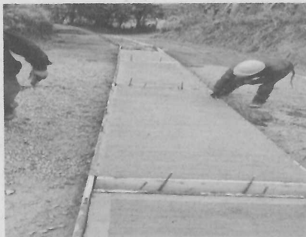
CONCRETO RESISTENCIA 14 MPA (G) (CICLOPEO) ZARZAL
