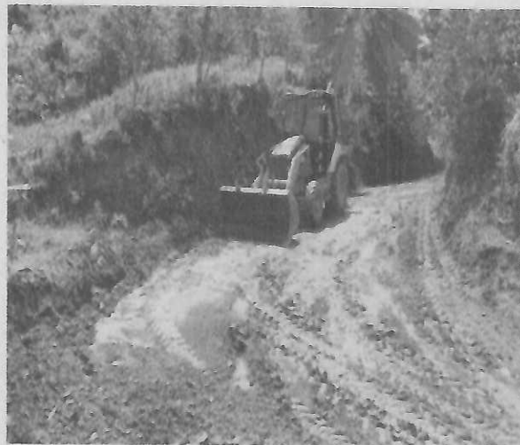
EXCAVACIÓN DE CORTES, CANALES Y PRETAMOS EN MATERIAL COMÚN A MAQUINA INCLUYE CARGUE Y ACARREO LIBRE DE 5 KM RESGUARDO SECTOR LA ESCUELA Y SECTOR CIRO
