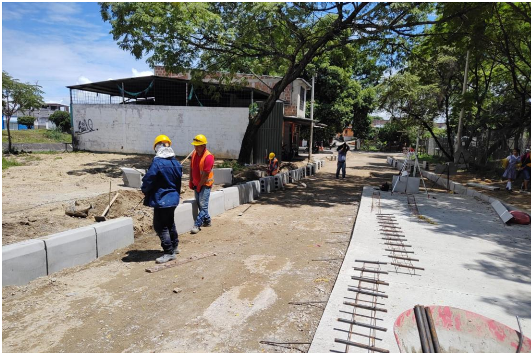
Instalación de sardineles prefabricados.
