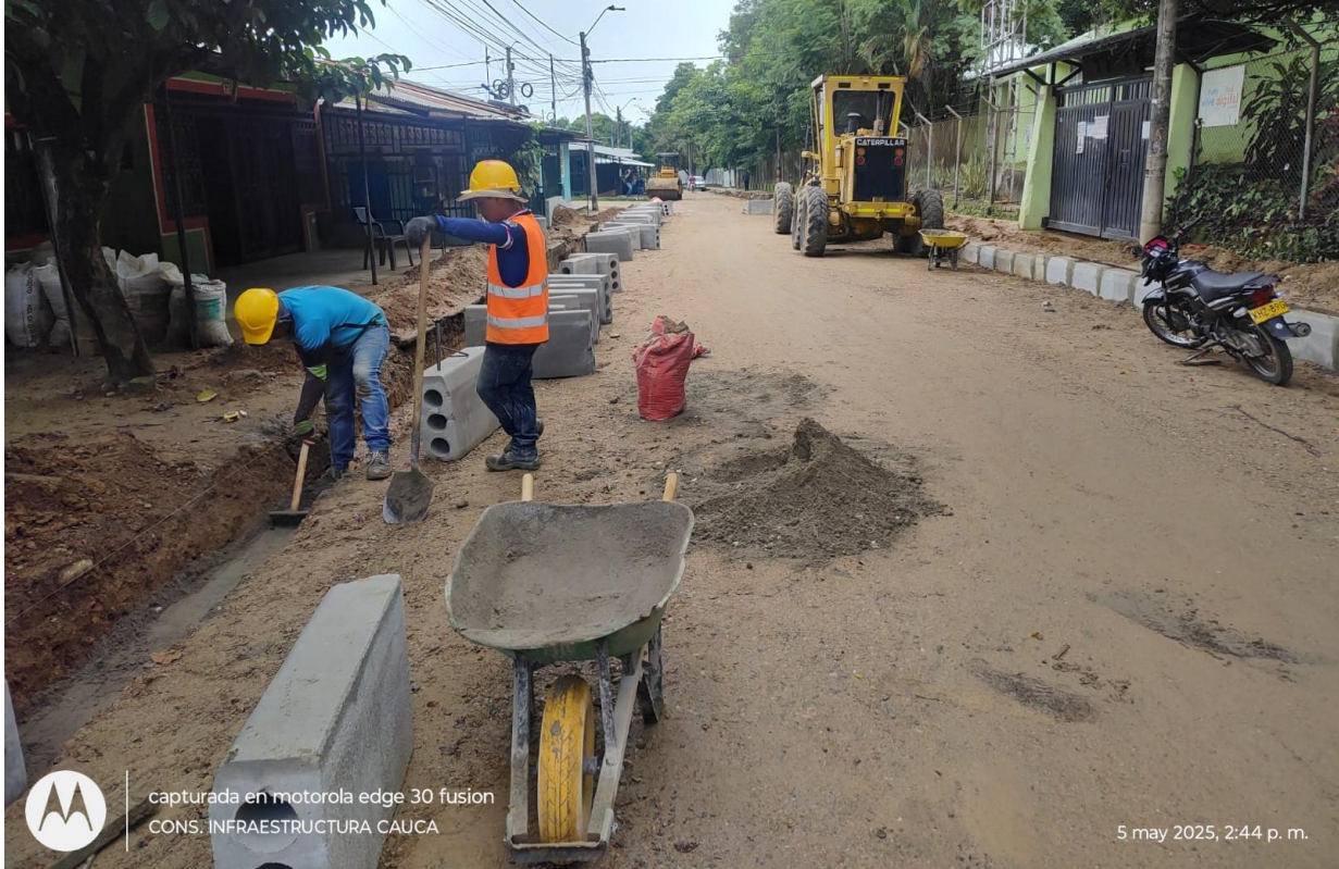
Instalación de sardineles prefabricados.
