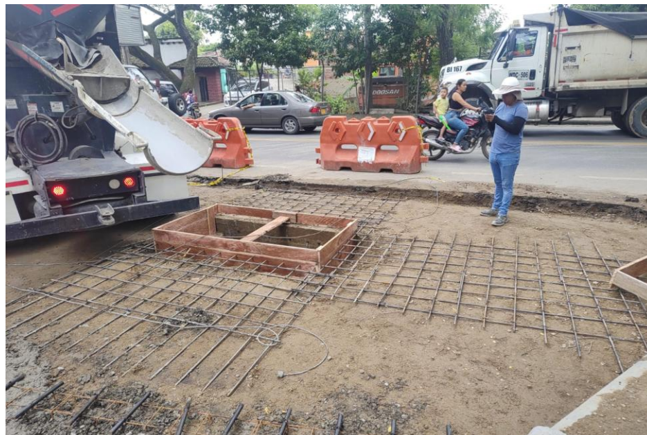
Instalación de acero de refuerzo para losas en concreto irregulares.
