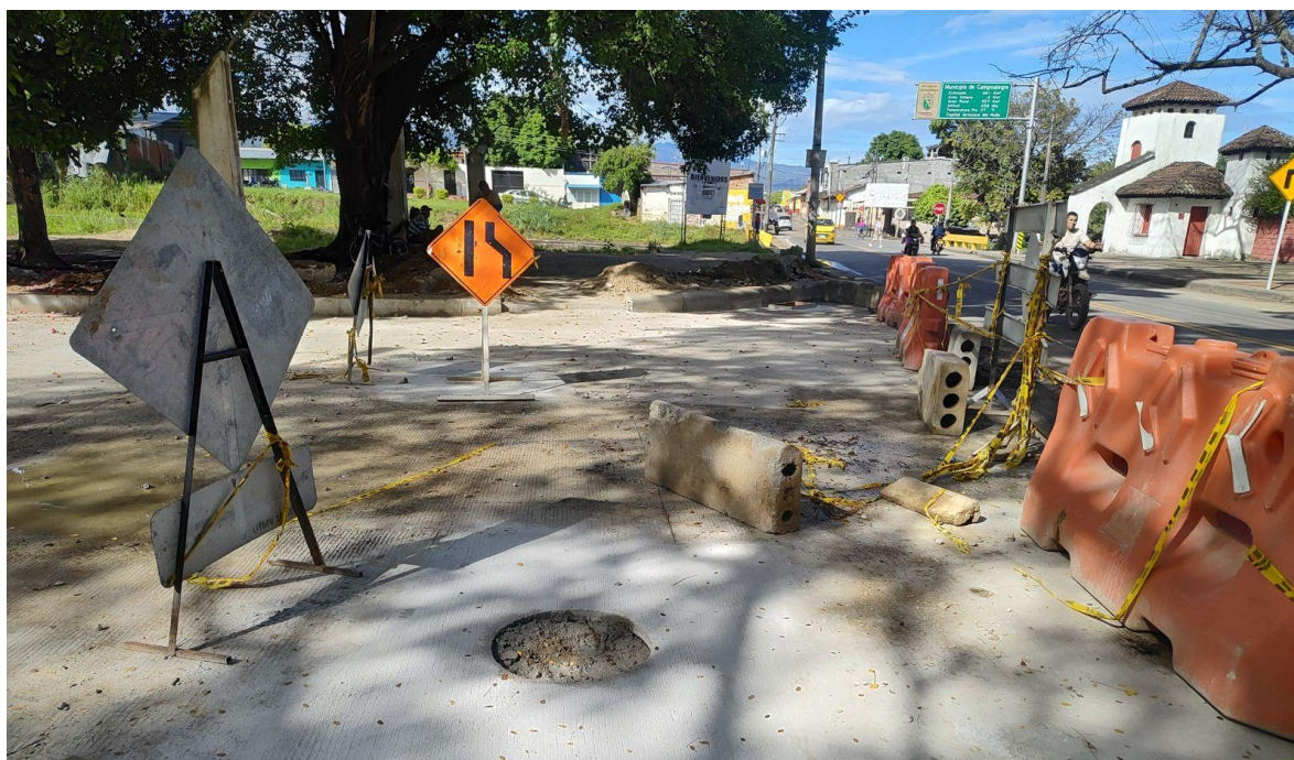
Cierre de vía.
