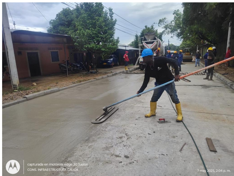
Allanado de losas de concreto.
