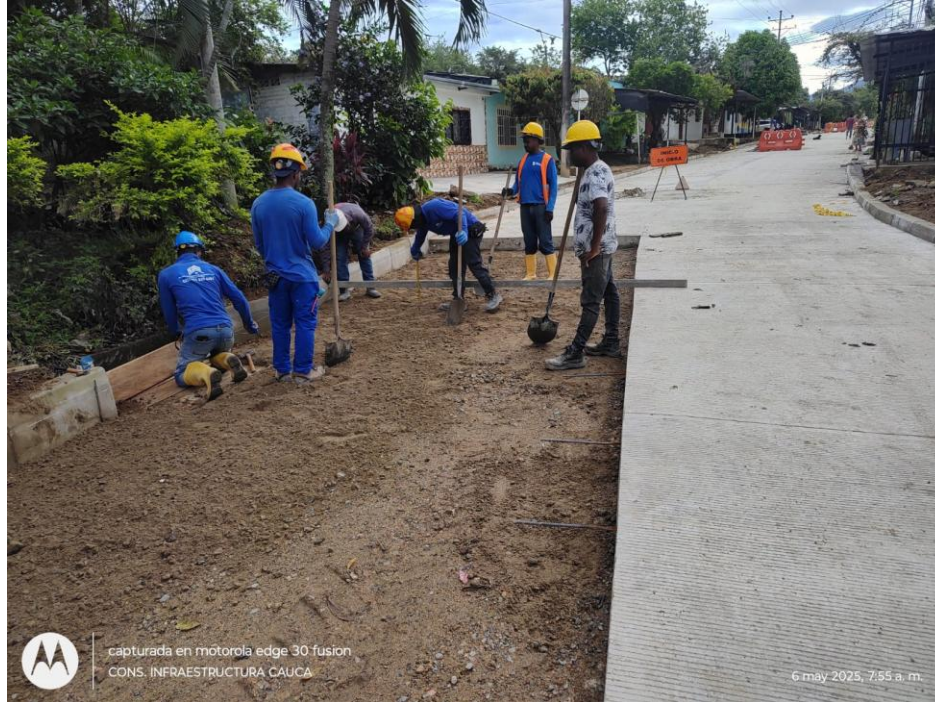
Verificación de especificaciones técnicas y corrección de afectaciones causadas por las lluvias a la base granular
