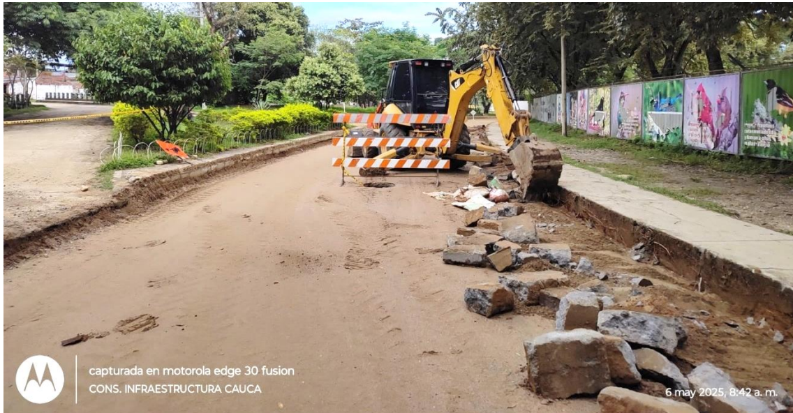
Demolición de bordillos.
