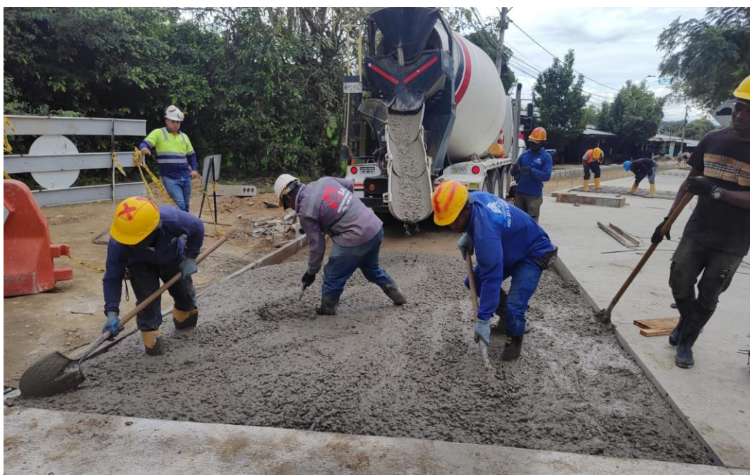
Fundición de losas del pavimento.
