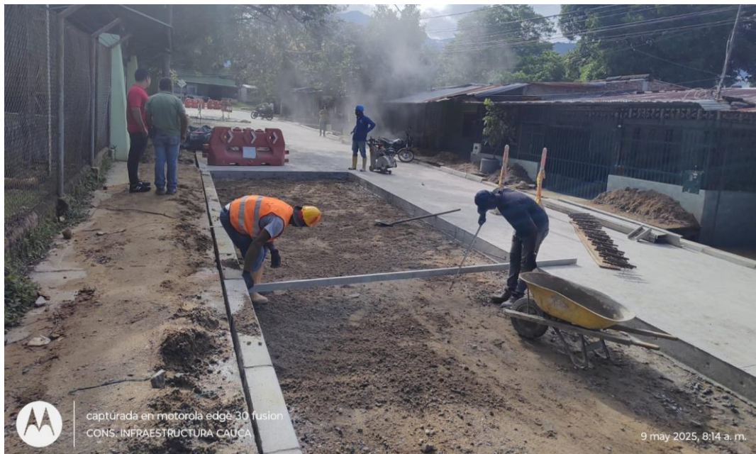
Verificación de especificaciones técnicas para la losa de concreto.
