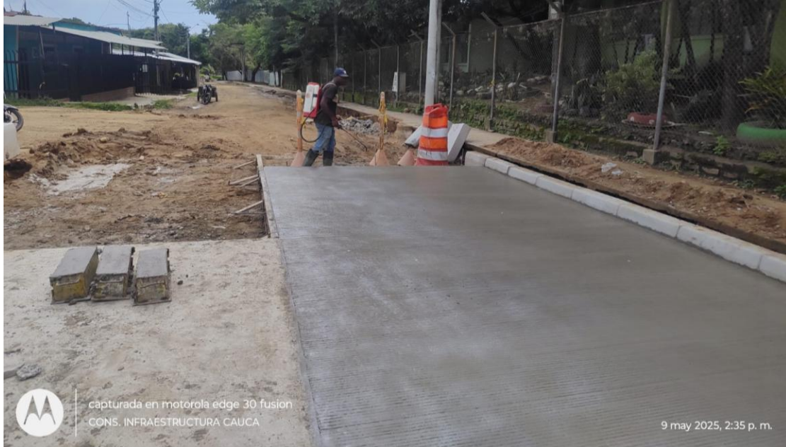
Curado de las losas en concreto.
