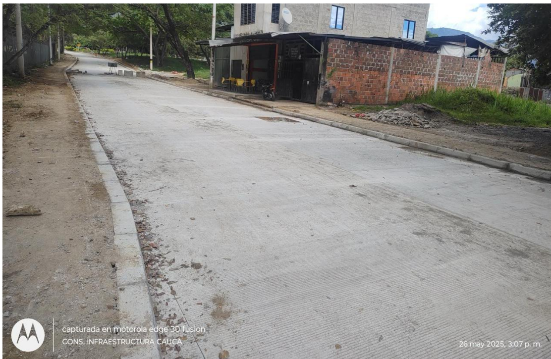
Acabado final del pavimento en concreto hidráulico MR-45.
