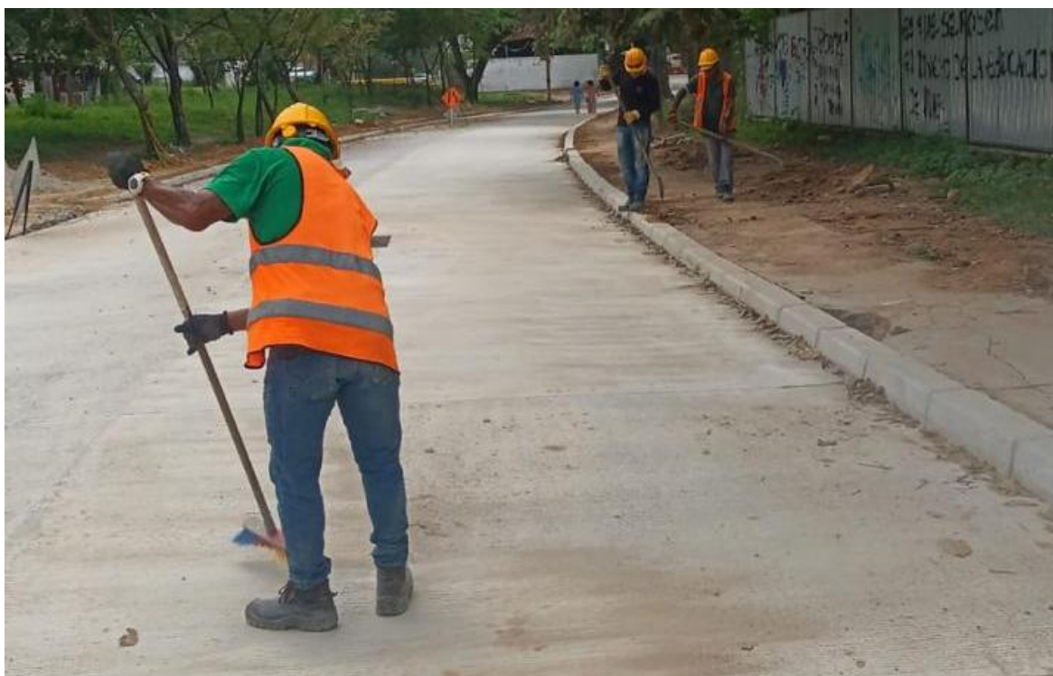
Jornadas de aseo general de obra.
