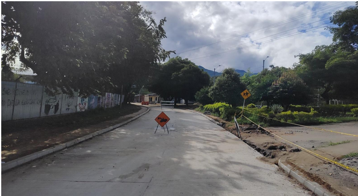
Cierre de vía.
