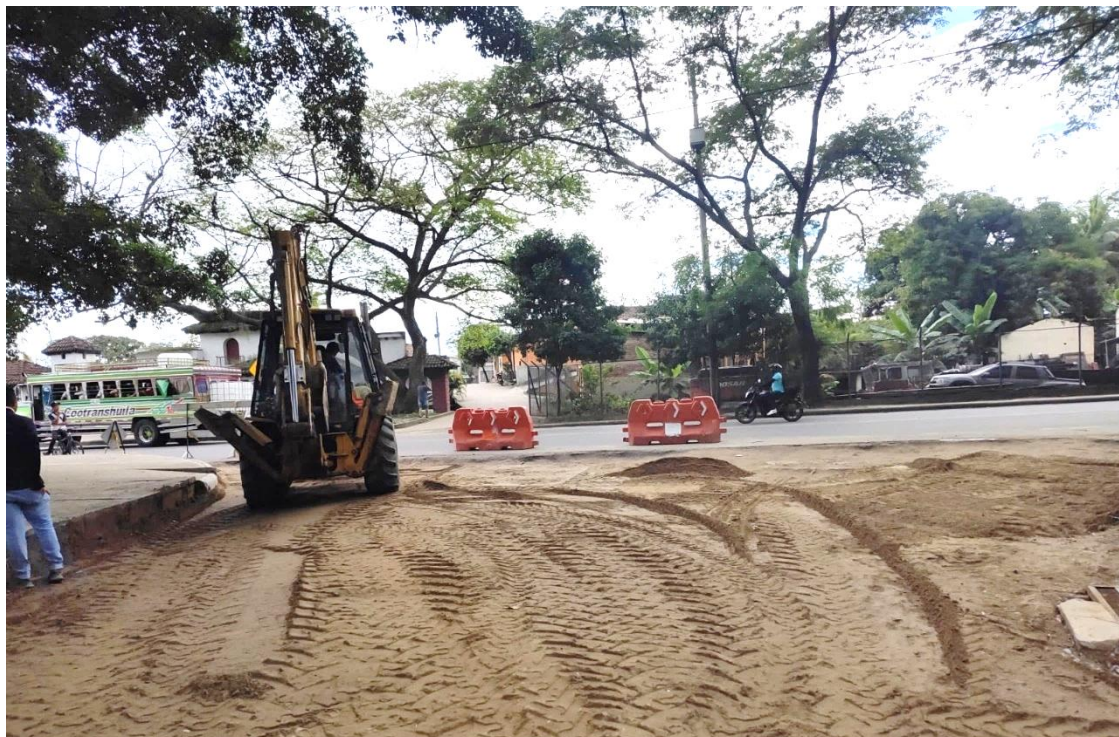
Conformación de calzada.
