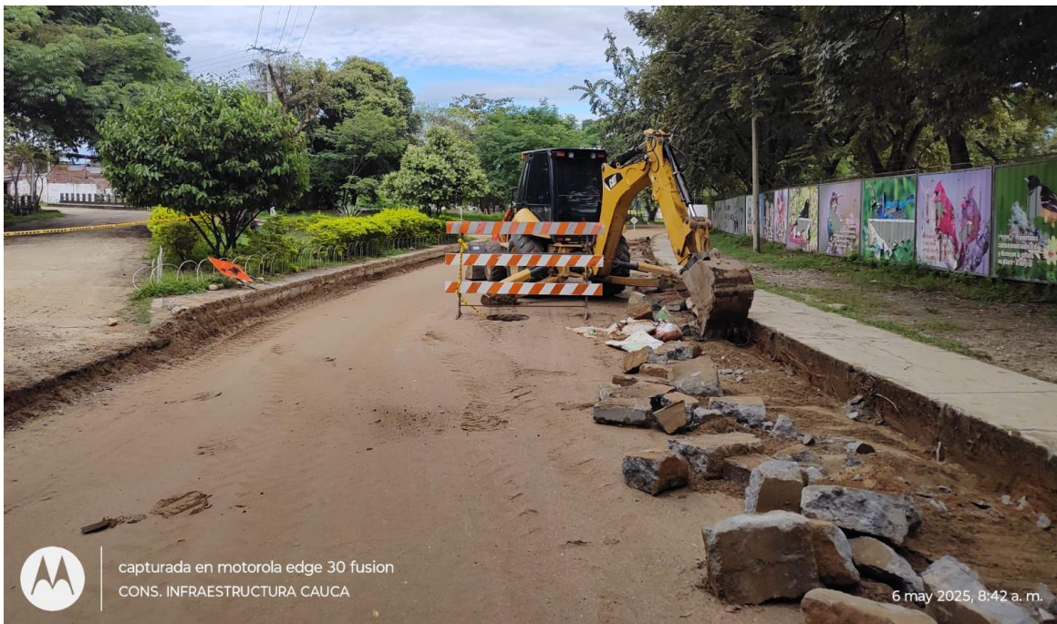
Demolición de bordillos.
