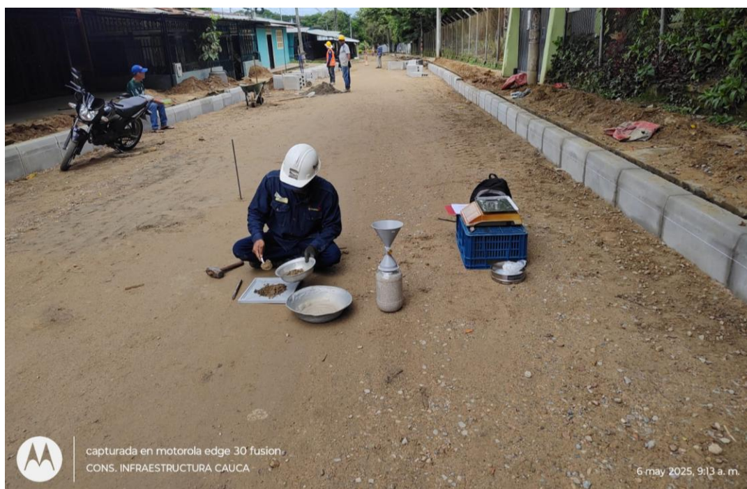
Control de calidad con ensayos de laboratorio de densidades aplicadas a la base granular.
