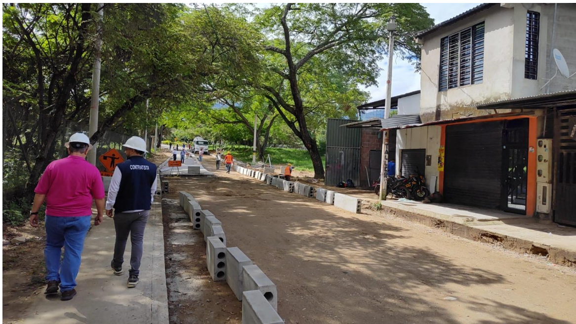
Asistencia de obra del representante legal de la interventoría CONSORCIO INFRAESTRUCTURA CAUCA, Ing. James Andrade Zambrano.
