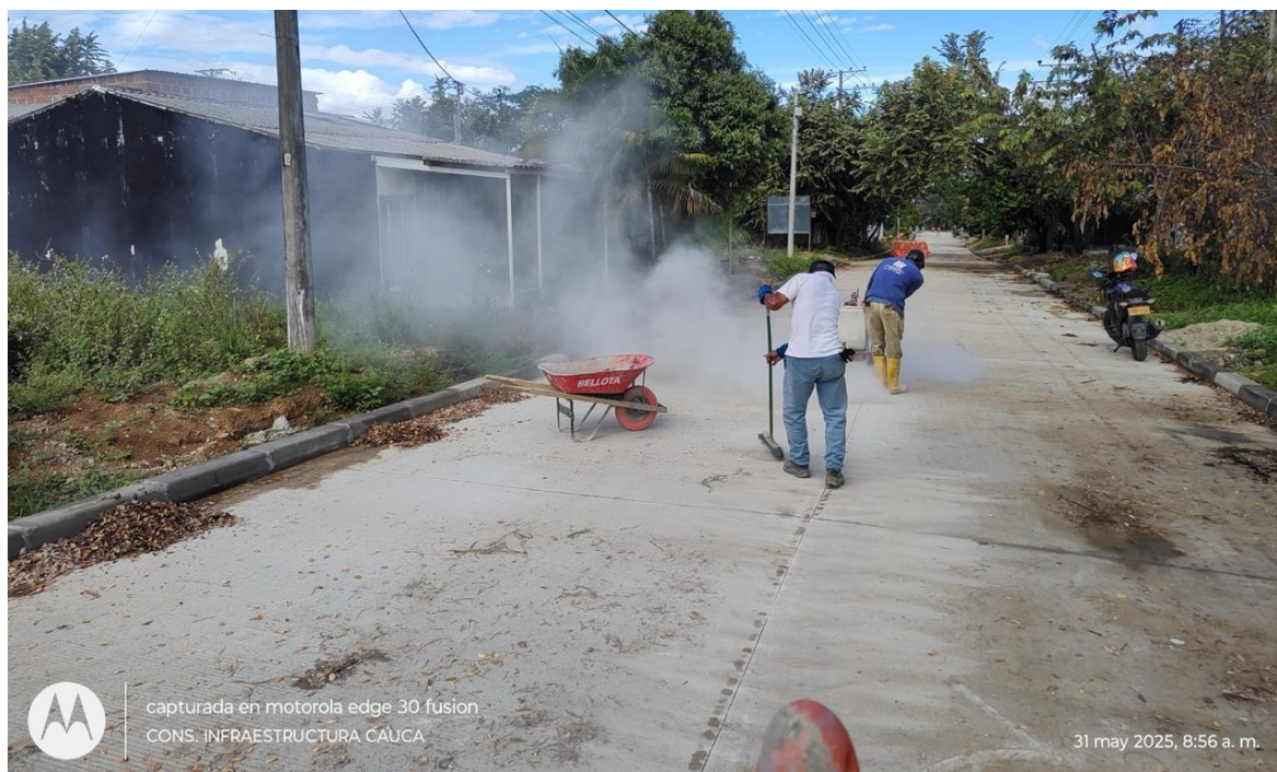
Corte y dilatación de las losas de pavimento.
