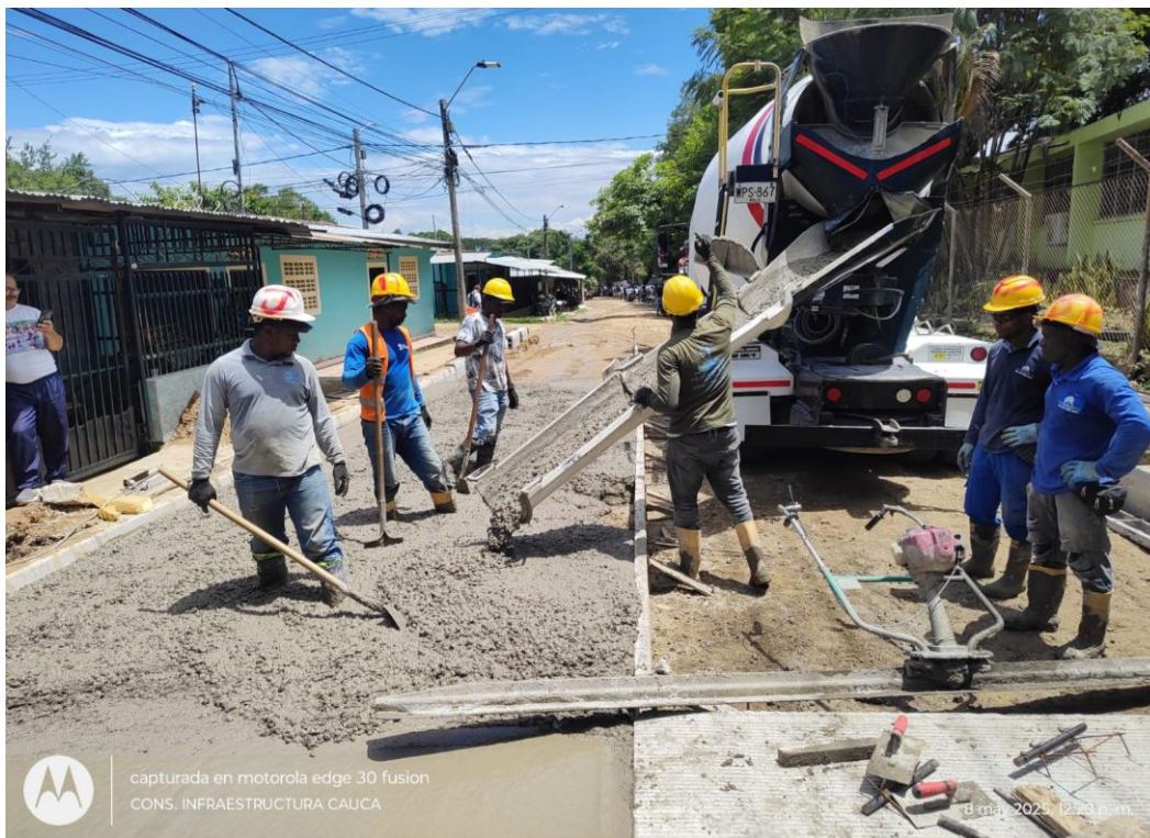
Camiones mixer transportadores de concreto premezclado.
