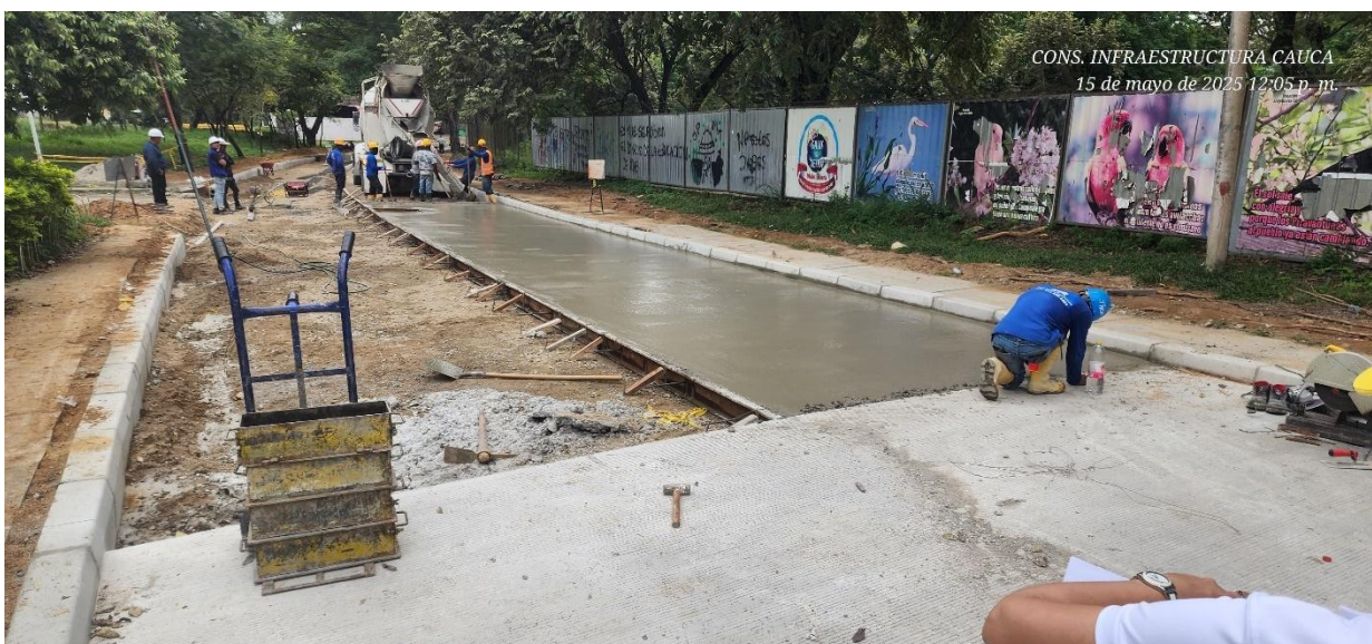
Fundición de losas en concreto.
