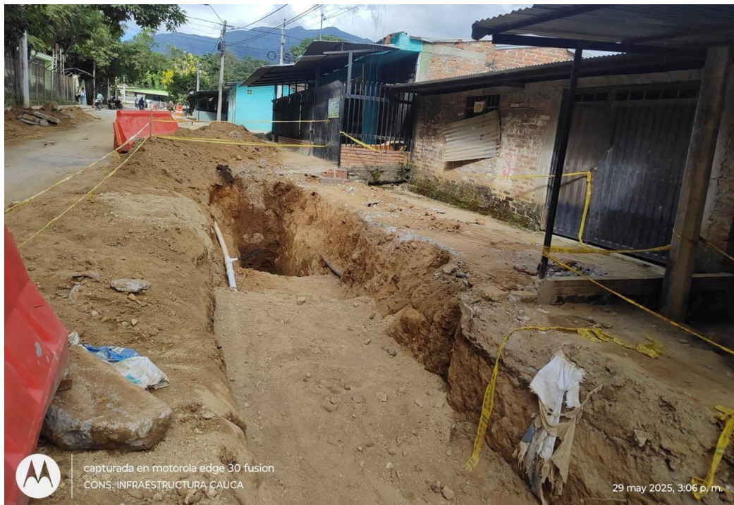
Evidencia de rellenos con suelos sueltos (sin compactación).
