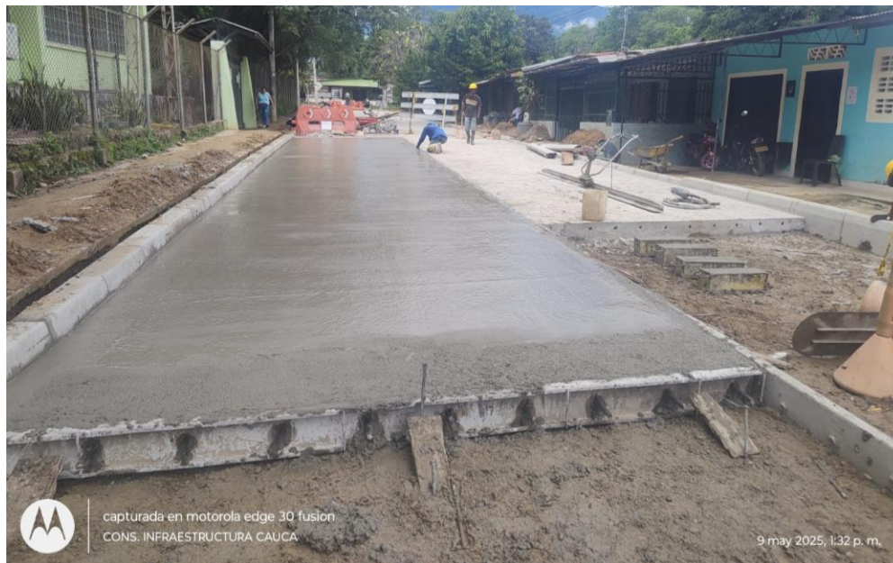
Acabado de las losas en concreto.
