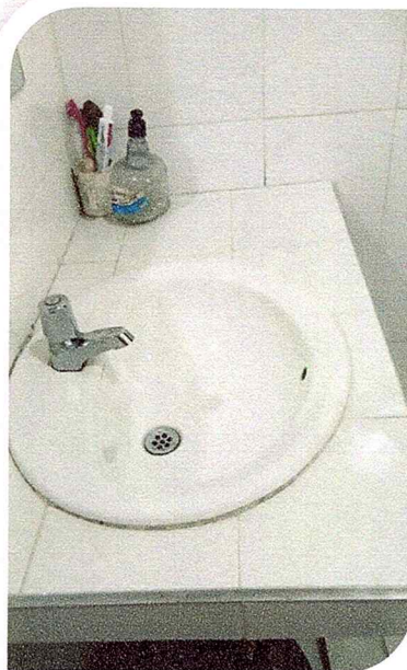
Limpieza, desinfección área de baños.
