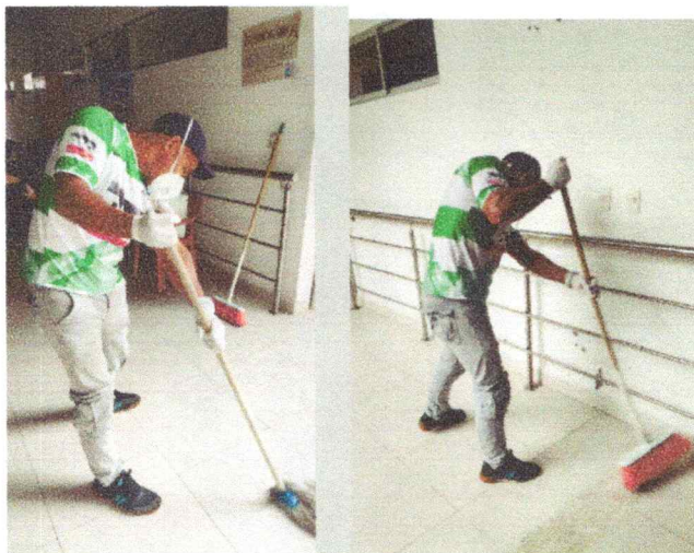
Limpieza de instalaciones
