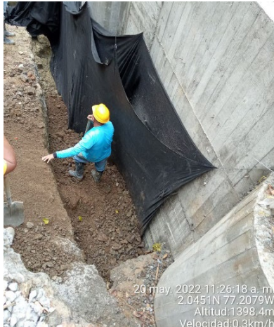
Instalación de geotextil y material filtrante
