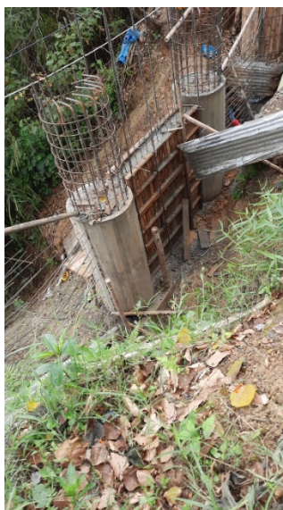
Columnas a 3 metros y fundida de pantalla entre columnas
