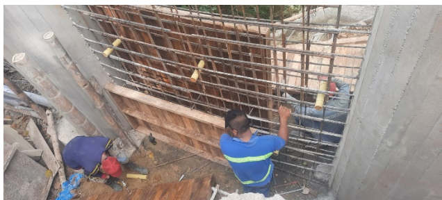
Armado de acero de refuerzo y formaleta para pantalla
