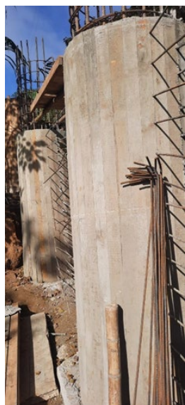
Columnas a 3 metros y fundida de pantalla entre columnas
