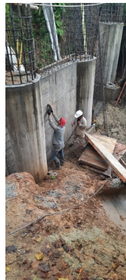
Columnas a 3 metros y fundida de pantalla entre columnas
