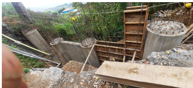
Armado de acero de refuerzo y formaleta para pantalla
