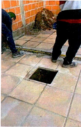
EXCAVACION DE PEDESTALES
