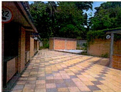
Imagen. Zona de equipamiento público transitable
