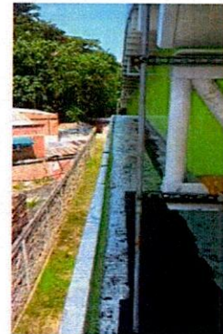
APLICACIÓN DE EMULSION ASFALTICA
