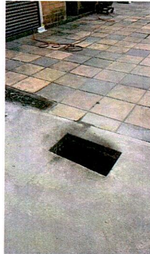
EXCAVACION DE PEDESTALES
