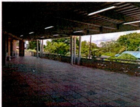
Imagen. Fachada principal 2do piso
