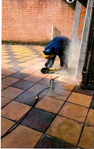
CORTE DE LOSETA EXISTENTE
