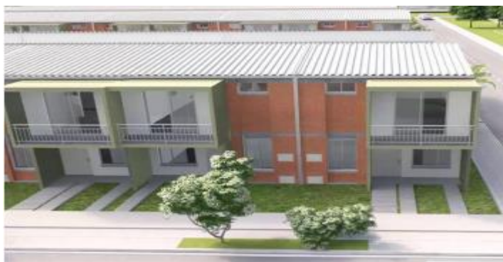
128 PARQUE RESIDENCIAL ALTAVISTA 750 VIVIENDAS DE INTERES SOCIAL PUERTO TEJADA CAUCA
