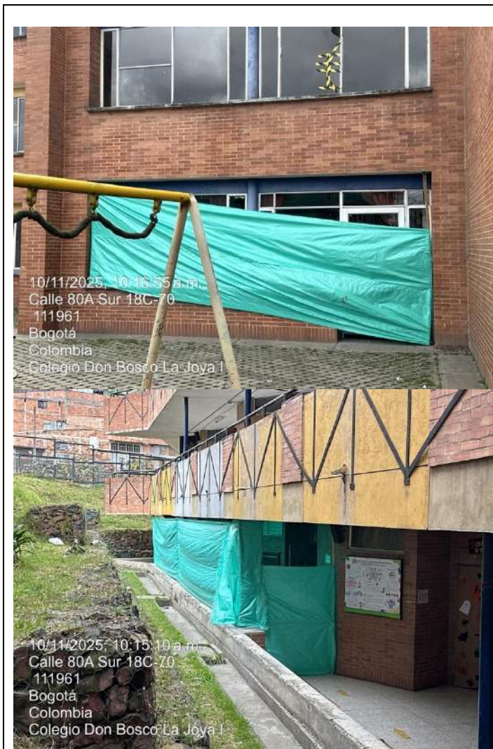
Fotografía No.3: cerramiento del área de trabajo.
