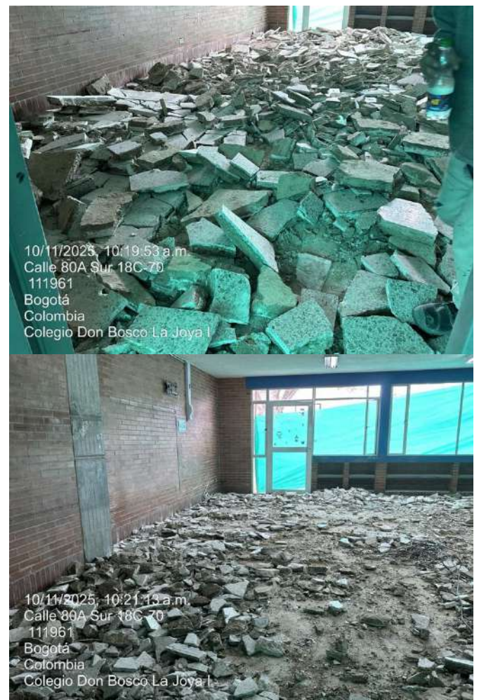
Fotografía No.4: demolición de alistado de piso.
