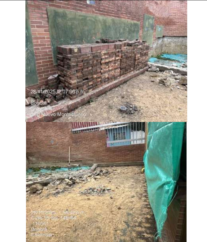
Fotografía No.27: desmonte de todo tipo de adoquines.
