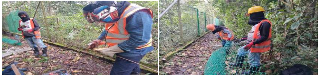
REEMPLAZO DE PANELES DEMALLA DE CERRAMIENTO
