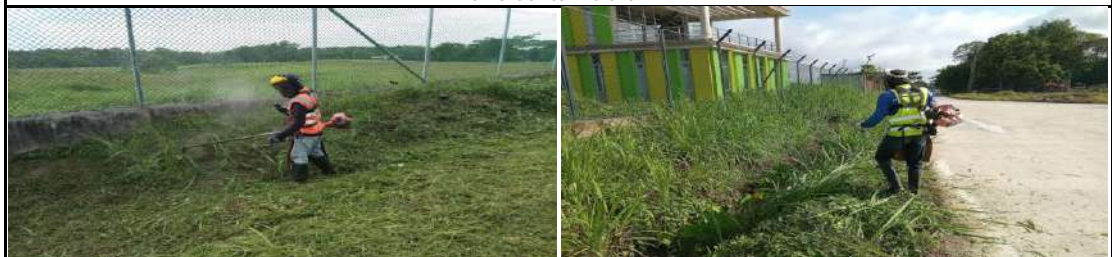
LIMPIEZA DE CARRAMIENTO
