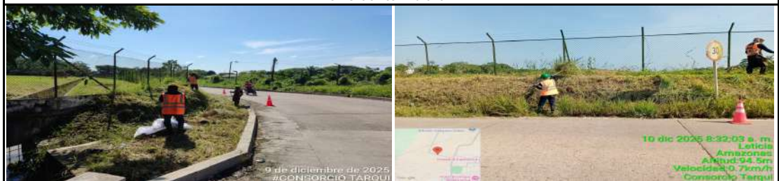
LIMPIEZA DE CARRAMIENTO
