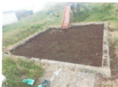
Figura 17: Excavación común seco a mano.
