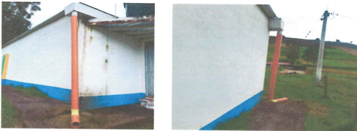
Figura 32: Bajante Aguas Lluvias D= 4".
