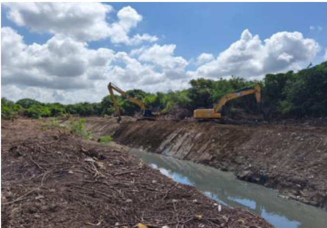
Seguimiento a Limpieza para recuperación ambiental en tramo anexo o brazo en abscisa K0+ 850 margen derecha
