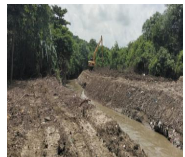
Limpieza para recuperación mecánica, perfilado y conformación de la sección transversal abscisa K1+ 040
