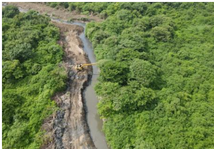
Limpieza para recuperación mecánica, perfilado y conformación de la sección transversal abscisa K0+ 700
