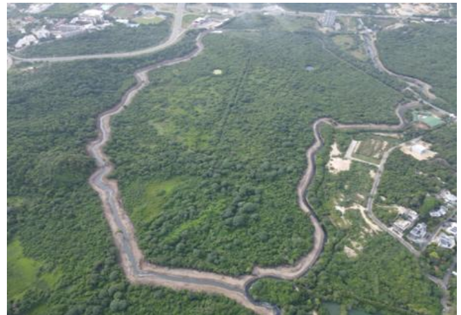
Vista aérea de Limpieza y recuperación ambiental sobre el brazo y tramo principal
