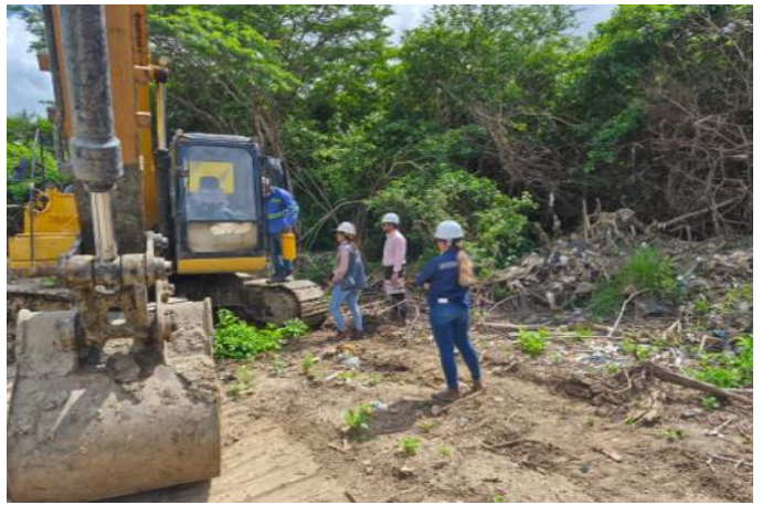
Visita de verificación de cumplimiento de lineamientos de SST por parte de la Entidad Contratante. Se verifican las condiciones de operación de la maquinaria y su funcionamiento
