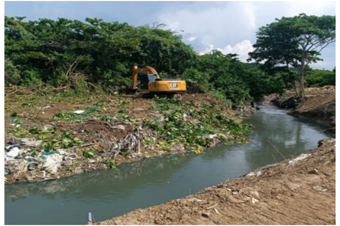
Seguimiento a Limpieza para recuperación ambiental en tramo anexo o brazo en abscisa K0+ 650 margen derecha
