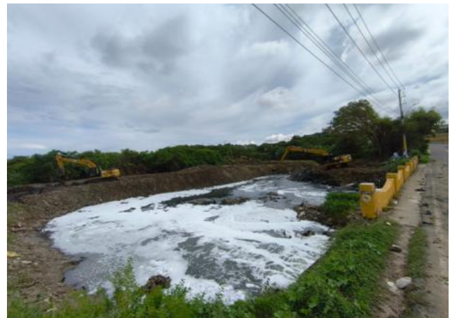
Seguimiento a Limpieza para recuperación ambiental en tramo anexo o brazo en abscisa K0+ 050 margen derecha
