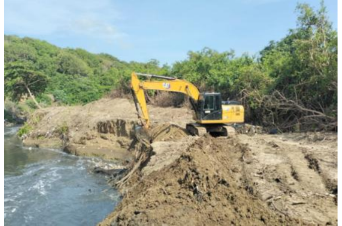
Seguimiento a Limpieza para recuperación mecánica, perfilado y conformación de la sección transversal abscisa K1+780 de tramo principal margen derecha
