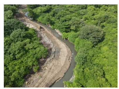
Limpieza para recuperación mecánica, perfilado y conformación de la sección transversal abscisa K0+ 500
