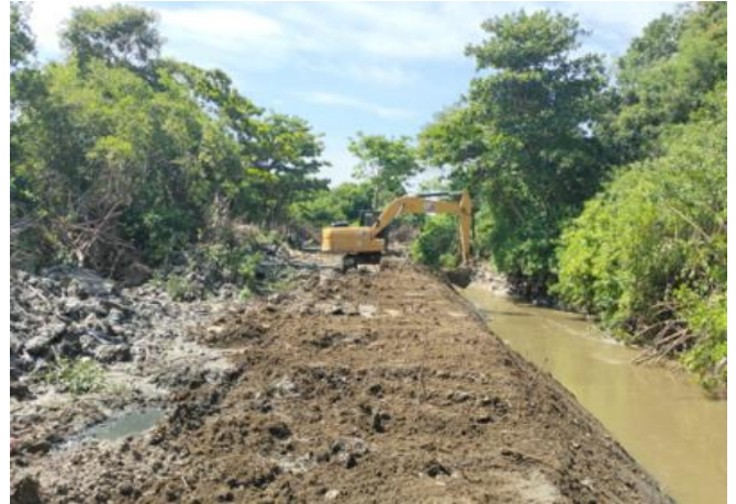
Seguimiento a Limpieza para recuperación mecánica, perfilado y conformación de la sección transversal abscisa K1+ 180 de tramo principal margen izquierda
