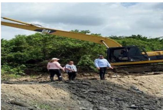
Ref. Recorrido de obra con Julieth Carrascal
