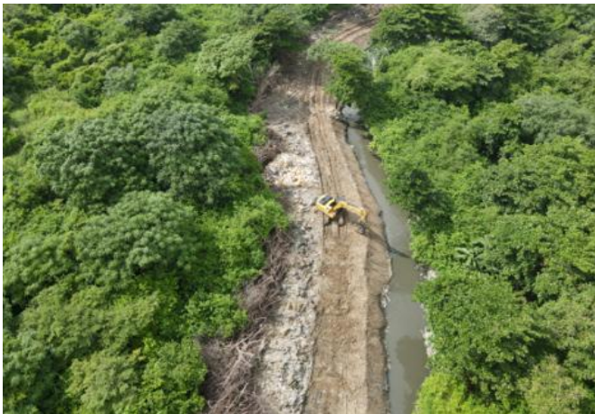
Seguimiento a Limpieza para recuperación mecánica, perfilado y conformación de la sección transversal abscisa K1+880 de tramo principal margen derecha
