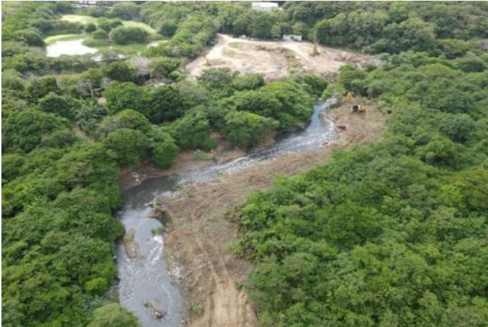
Seguimiento a Limpieza para recuperación mecánica, perfilado y conformación de la sección transversal abscisa K1+280 de tramo principal margen izquierda
