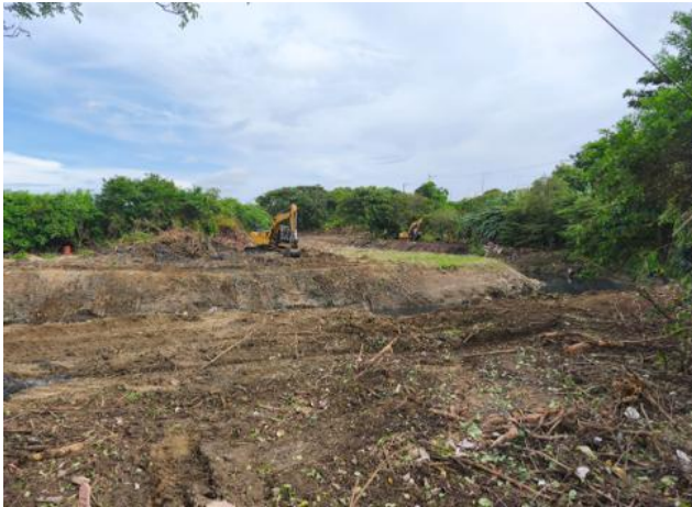
Seguimiento a Limpieza para recuperación ambiental en tramo anexo o brazo en abscisa K0+ 150 margen derecha
