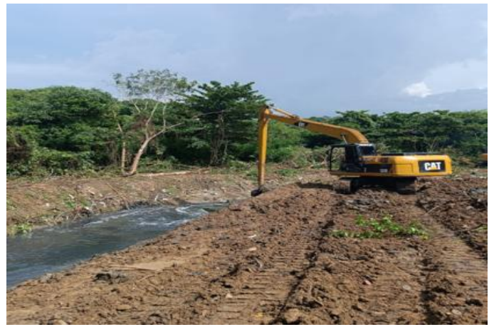
Seguimiento a Limpieza para recuperación mecánica, perfilado y conformación de la sección transversal abscisa K1+ 530 de tramo principal margen izquierda
