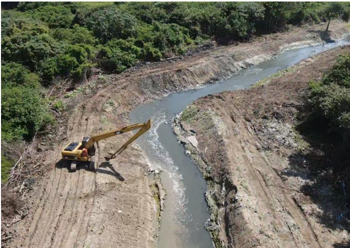
Limpieza para recuperación mecánica, perfilado y conformación de la sección transversal en el costado izquierdo del tramo auxiliar del arroyo León en la abscisa K1+010
