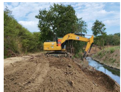
Seguimiento a limpieza para recuperación mecánica, perfilado y conformación de la sección transversal en el costado izquierdo del tramo principal del arroyo León en la abscisa K1+ 980
