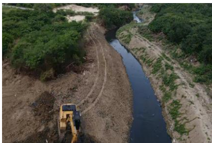
Limpieza para recuperación mecánica, perfilado y conformación de la sección transversal en el costado izquierdo del tramo auxiliar del arroyo León en la abscisa K1+110
