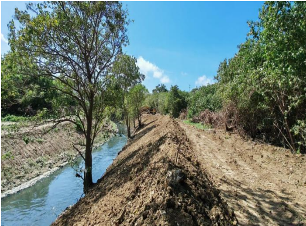
Seguimiento a limpieza para recuperación mecánica, perfilado y conformación de la sección transversal en el costado izquierdo del tramo del principal del arroyo León en la abscisa K1+ 760
