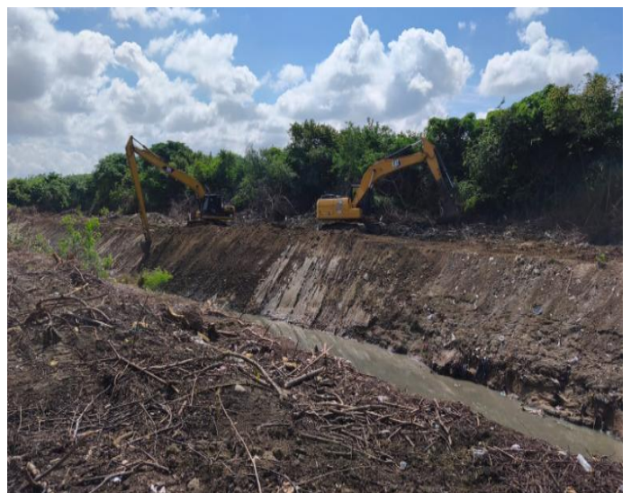
Limpieza para recuperación mecánica, perfilado y conformación de la sección transversal en el costado izquierdo del tramo auxiliar del arroyo León en la abscisa K0+ 920
