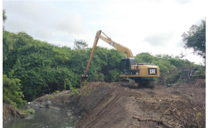
Seguimiento a limpieza para recuperación ambiental, específicamente en abscisa K1+270 Talud Izquierdo del sector adicional del tramo principal del Arroyo León.
