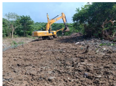
Limpieza para recuperación mecánica, perfilado y conformación de la sección transversal en el costado izquierdo del tramo auxiliar del arroyo León en la abscisa K1+150
