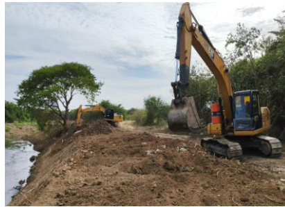
Seguimiento a limpieza para recuperación mecánica, perfilado y conformación de la sección transversal en el costado izquierdo del tramo principal del arroyo León en la abscisa K1+ 880
