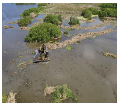
Seguimiento Limpieza y Recuperación Ambiental mediante retiro de vegetación (biota) acuática sobre planchón con maquinaria retro excavadora iniciando por el área de las 2.0 Hectáreas
