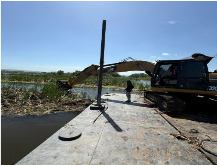
Seguimiento Limpieza y Recuperación Ambiental mediante retiro de vegetación (biota) acuática sobre planchón con maquinaria retro excavadora iniciando por el área de las 2.0 Hectáreas
