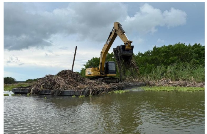
Seguimiento Limpieza y Recuperación Ambiental mediante retiro de vegetación (biota) acuática sobre planchón con maquinaria retro excavadora iniciando por el área de las 2.0 Hectáreas
