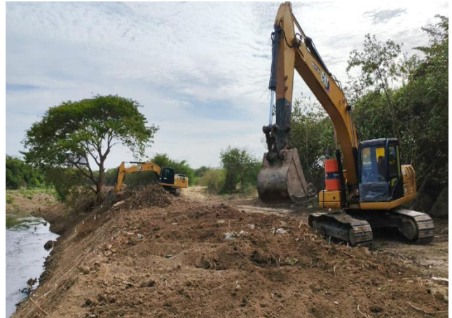
Seguimiento a limpieza para recuperación mecánica, perfilado y conformación de la sección transversal en el costado izquierdo del tramo del principal del arroyo León en la abscisa K1+ 880
