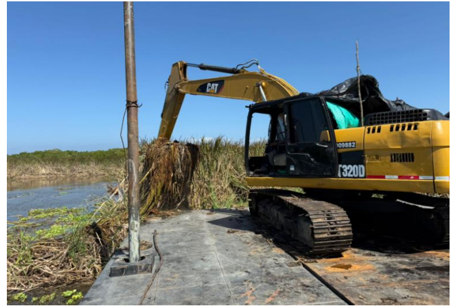
Seguimiento Limpieza y Recuperación Ambiental mediante retiro de vegetación (biota) acuática sobre planchón con maquinaria retro excavadora iniciando por el área de las 2.0 Hectáreas
