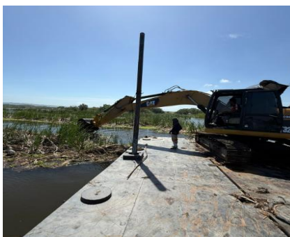
Seguimiento Limpieza y Recuperación Ambiental mediante retiro de vegetación (biota) acuática sobre planchón con maquinaria retro excavadora iniciando por el área de las 2.0 Hectáreas
