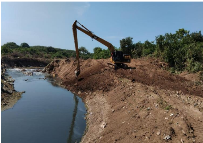
Limpieza para recuperación mecánica, perfilado y conformación de la sección transversal en el costado izquierdo del tramo auxiliar del arroyo León en la abscisa K1+ 350
