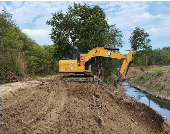
Seguimiento a limpieza para recuperación mecánica, perfilado y conformación de la sección transversal en el costado izquierdo del tramo del principal del arroyo León en la abscisa K1+ 980
