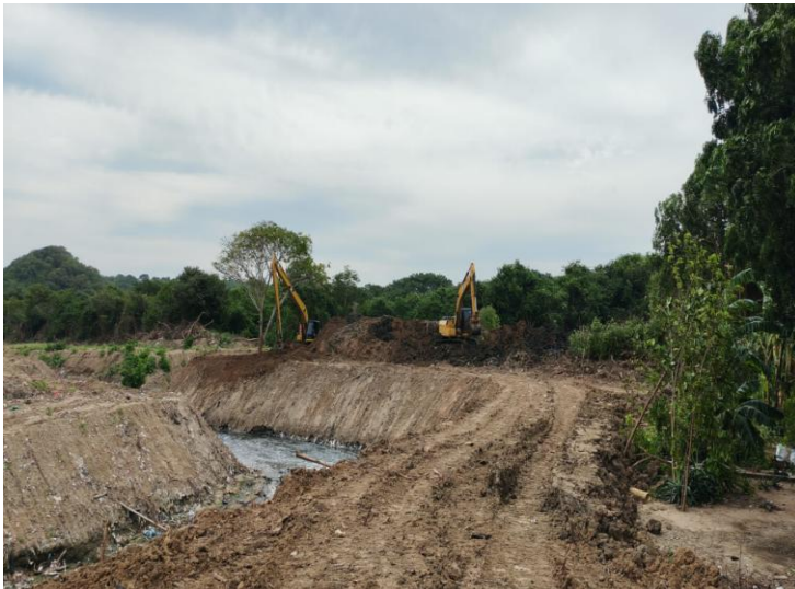
Limpieza para recuperación mecánica, perfilado y conformación de la sección transversal en el costado izquierdo del tramo del principal del arroyo León en la abscisa K1+ 170
