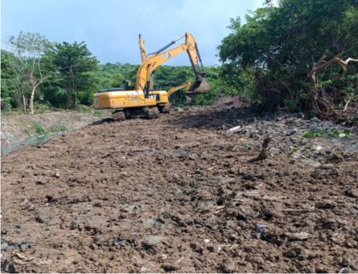
Limpieza para recuperación mecánica, perfilado y conformación de la sección transversal en el costado izquierdo del tramo del principal del arroyo León en la abscisa K1+ 150
