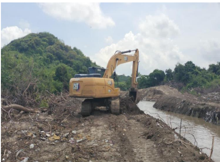
Limpieza para recuperación mecánica, perfilado y conformación de la sección transversal en el costado izquierdo del tramo del principal del arroyo León en la abscisa K1+ 280
