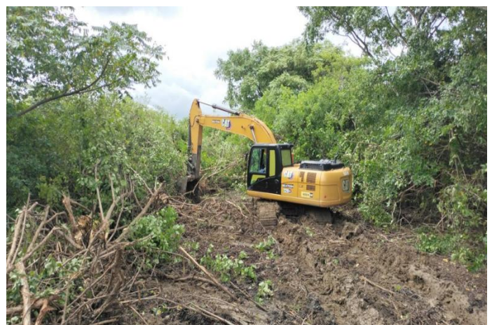
Limpieza para recuperación ambiental, específicamente en abscisa K1+400 Talud Izquierdo del sector adicional del tramo principal del Arroyo León.
