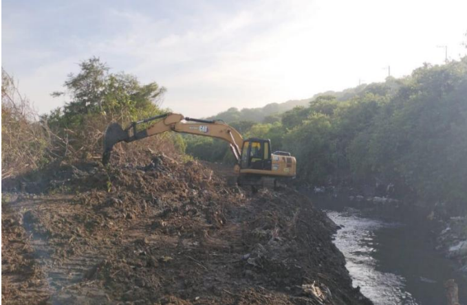
Ingreso de maquinaria en tramo adicional para limpieza para recuperación ambiental, específicamente en abscisa K1+350 Talud Izquierdo Tramo Adicional
