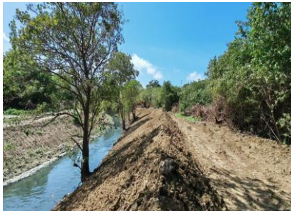
Seguimiento a limpieza para recuperación mecánica, perfilado y conformación de la sección transversal en el costado izquierdo del tramo principal del arroyo León en la abscisa K1+ 780
