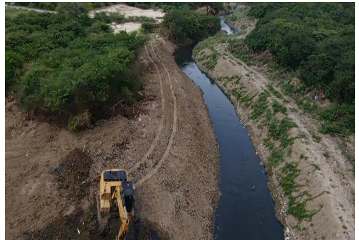
Limpieza para recuperación mecánica, perfilado y conformación de la sección transversal en el costado izquierdo del tramo del principal del arroyo León en la abscisa K1+ 110
