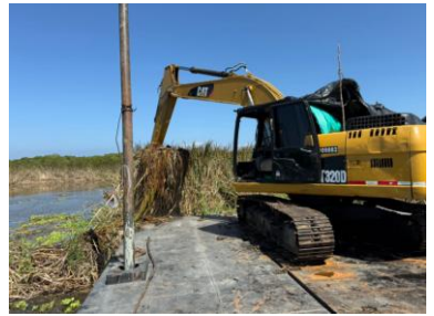
Seguimiento Limpieza y Recuperación Ambiental mediante retiro de vegetación (biota) acuática sobre planchón con maquinaria retro excavadora iniciando por el área de las 2.0 Hectáreas
