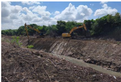
Limpieza para recuperación mecánica, perfilado y conformación de la sección transversal en el costado izquierdo del tramo auxiliar del arroyo León en la abscisa K0+ 920
