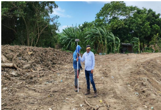
Trazado y replanteo de la adición al tramo principal del arroyo león, K0+820 del sector adicional del tramo principal
