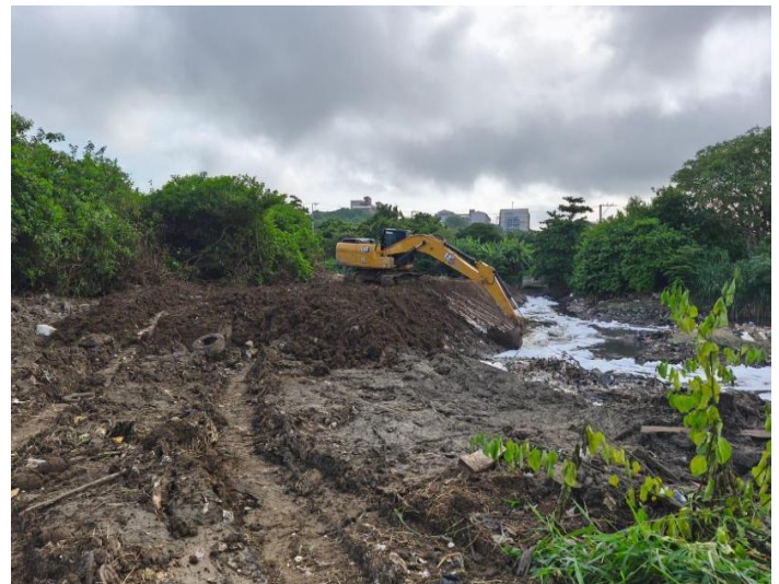
Limpieza para recuperación mecánica, perfilado y conformación de la sección transversal en el costado izquierdo del tramo del principal del arroyo León en la abscisa K1+ 220
