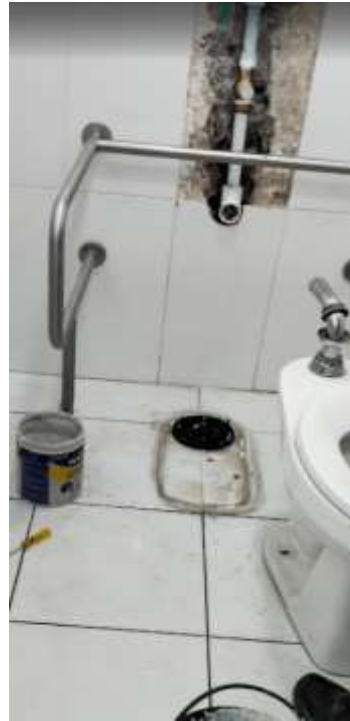
1,4 REGATA EN MAMPOSTERIA EXISTENTE PARA RED HIDRAULICA
