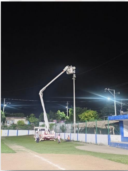
INSTALACIÓN DE LUMINARIAS
