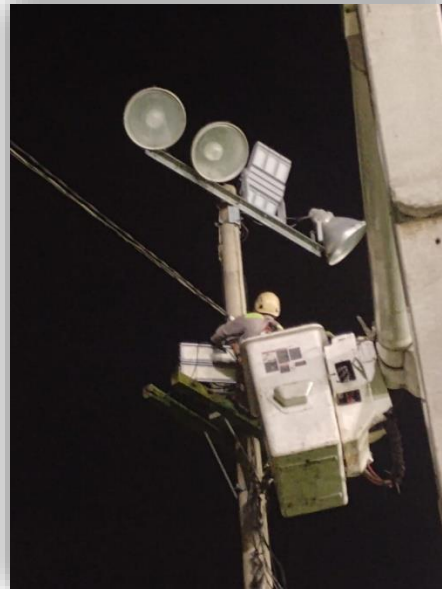
INSTALACIÓN DE LUMINARIAS
