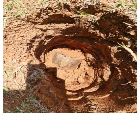
Toma molde CBR Apique 1 Unidad Recreativa La Estrella
