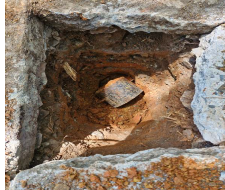
Toma molde CBR Apique 4 Unidad Recreativa La Estrella
