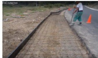
Colocamos la parrilla de acero esta lleva varilla de \frac{1}{2}
