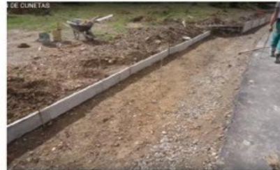
Iniciamos a formar lateral. Existen dos tipos de cuneta, cuneta vatea y en L. Iniciamos con la de vatea
