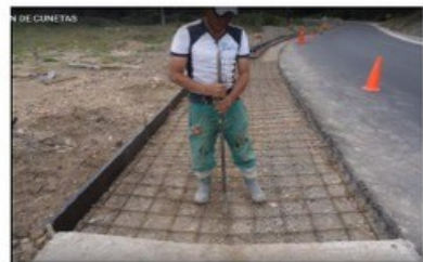
Doblamos en la mitad para darle forma de V para esto utilizamos la barra
