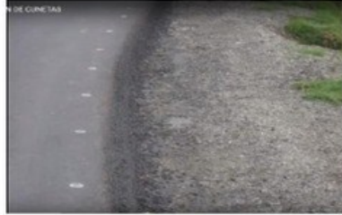
Iniciamos con la marcación para el corte
