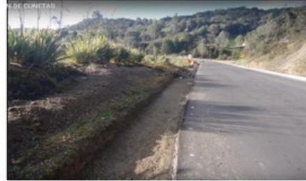
Iniciamos replanteo tomando un nivel del pavimento y dejando una pendiente de 10 cm
