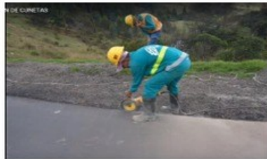
Procedemos a cortar para esto utilizamos una cortadora o pulidora
