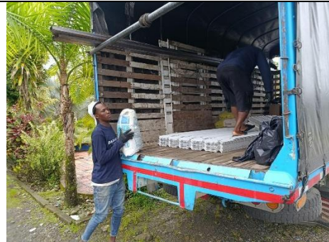
Descargue de materiales para la obra
