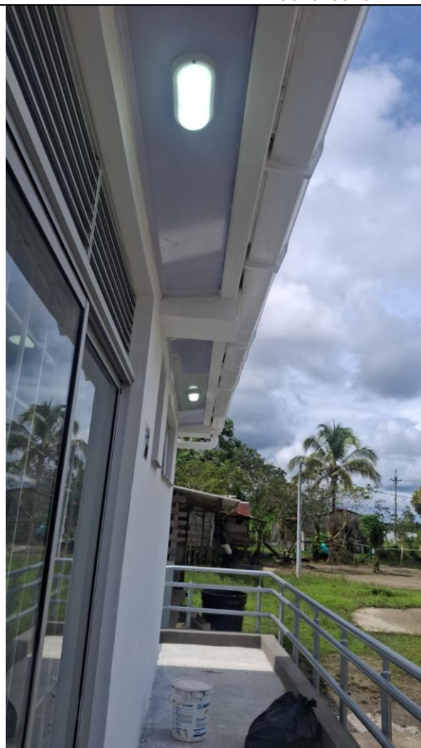
Instalación de lámparas en exterior
