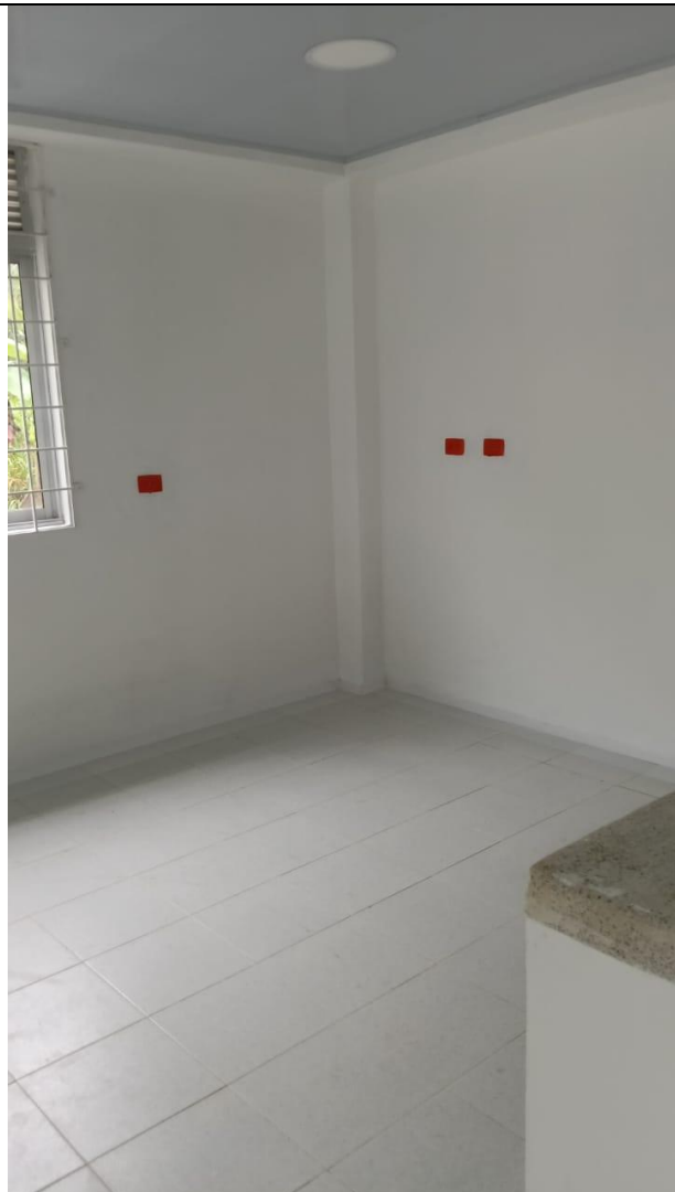
Instalación de toma corrientes
