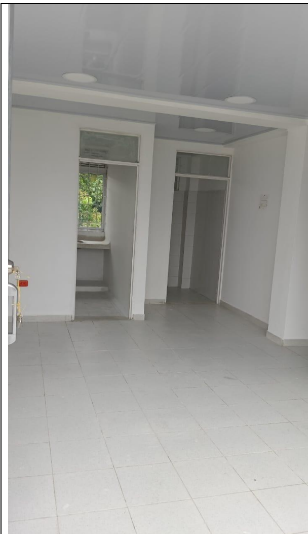
Lámparas led instaladas, pintura sobre muro
