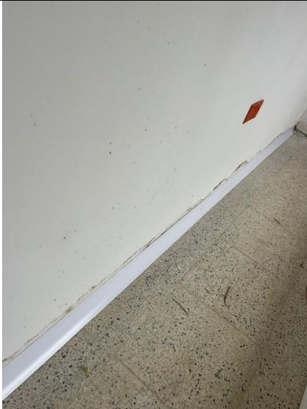
Instalación de guarda escoba en PVC
