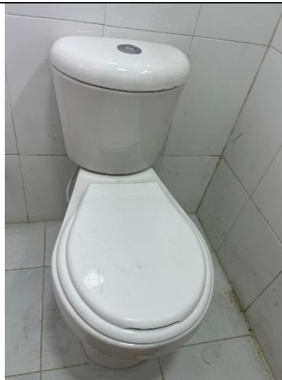
Instalación de sanitario
