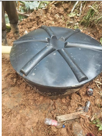
Instalacion de pozo septico
