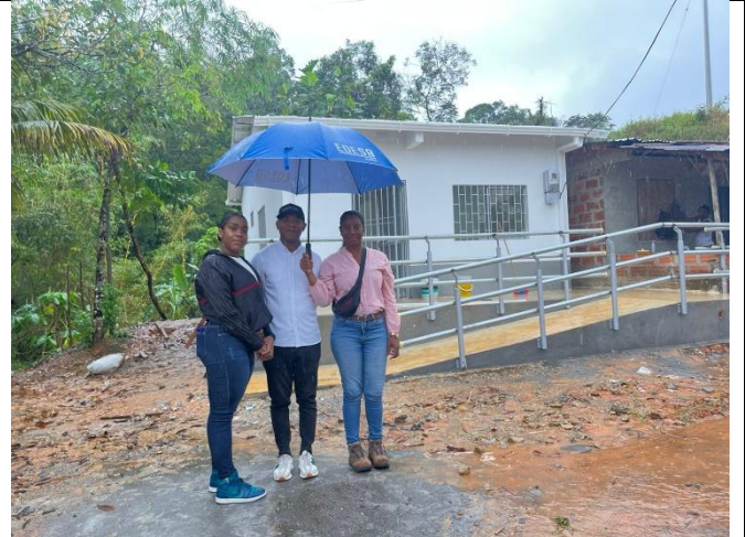
Visita de seguimiento de obra
