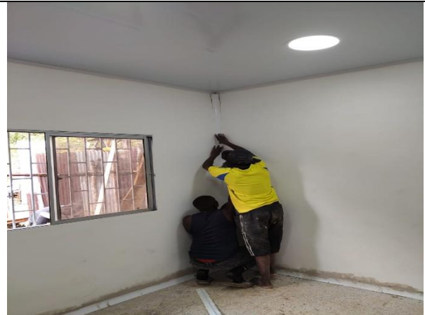
Instalación de pvc en muros
