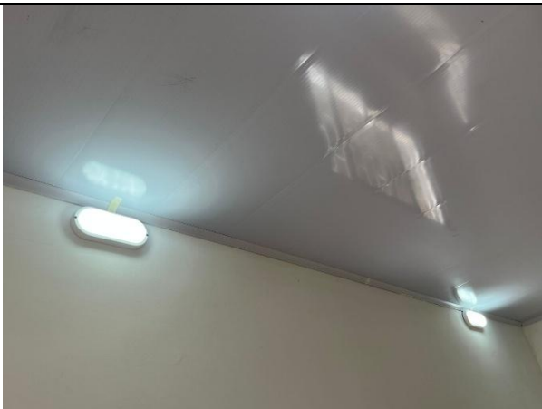
Instalación de lámparas internas
