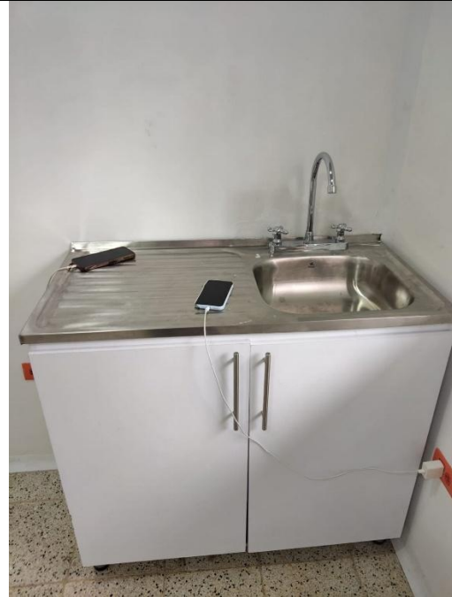
Instalación de mueble
