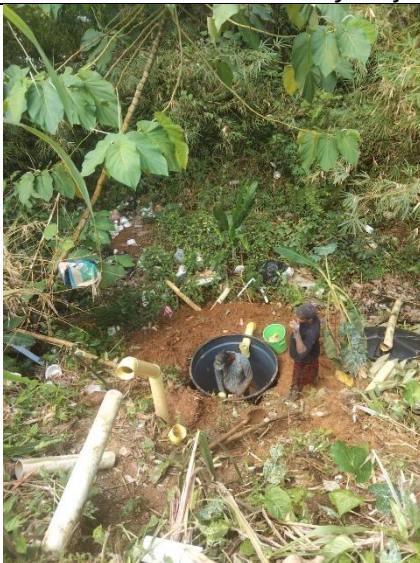
Instalacion de pozo septico
