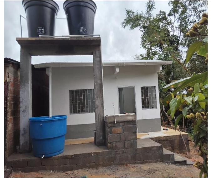
Instalación de tanques elevados
