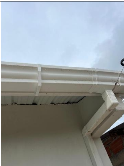
Instalación de canoera y bajante
