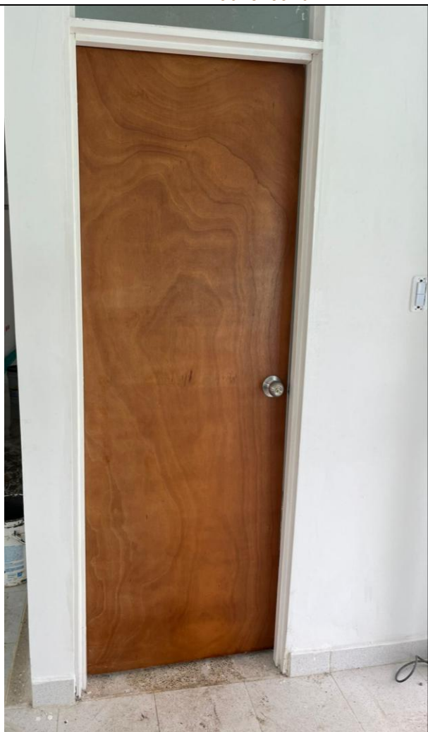
Instalación de puertas
