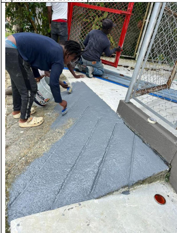
Pintura rampa y reja
