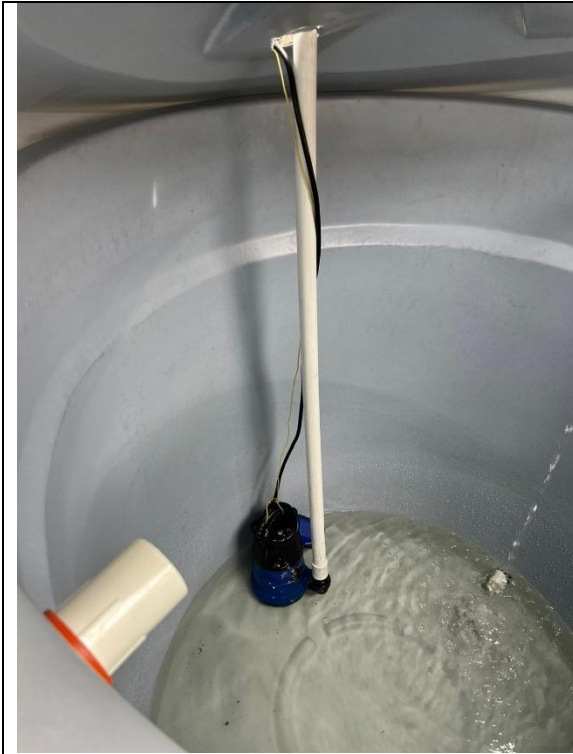
Instalación de bomba sumergible
