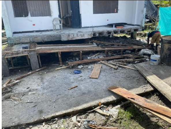
Construcción de rampa de acceso
