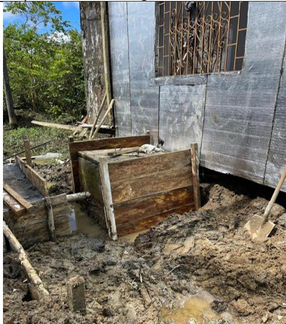
Adecuación de caja de inspección
