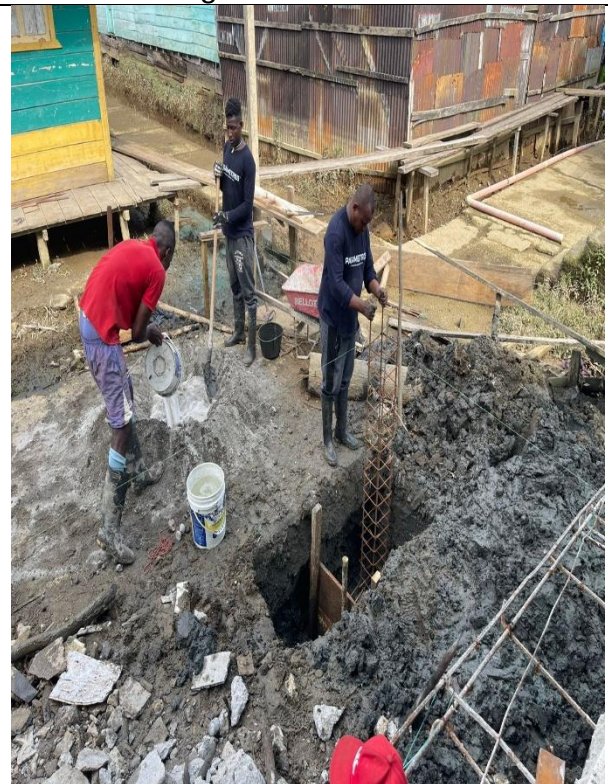
Construcción de rampa de acceso
