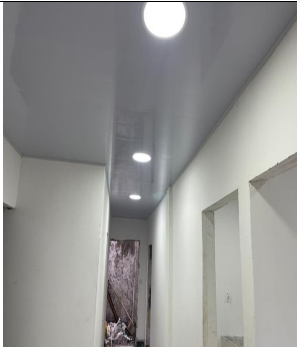
Instalacion de lamaparas
