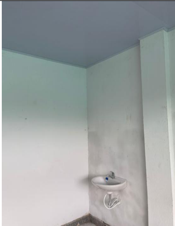
Instalacion de lava mano
