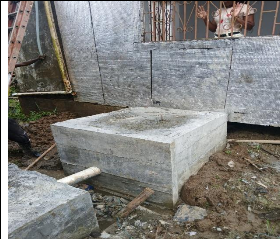
Adecuación de tanque
