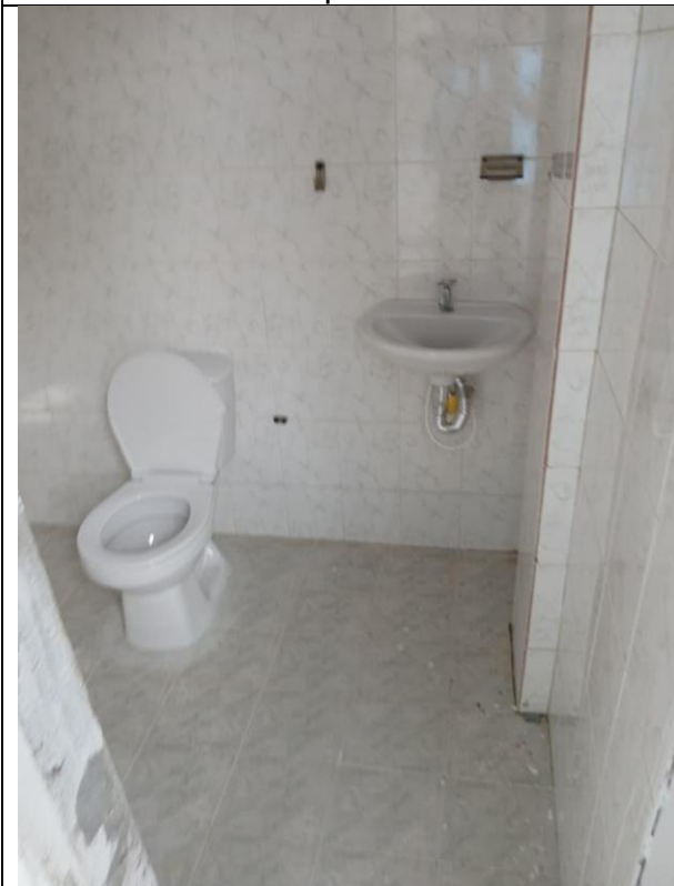
Instalación de sanitario y lavamanos
