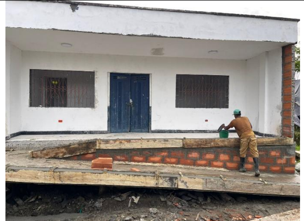
Construcción de rampa de acceso
