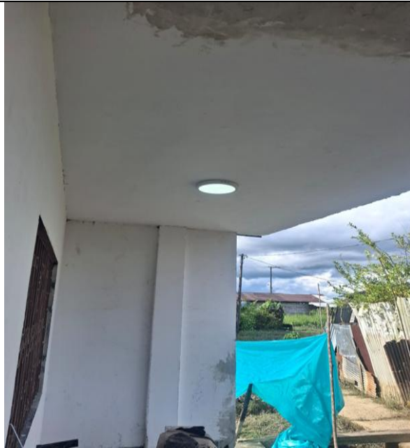
Reparacion de la viga canal
