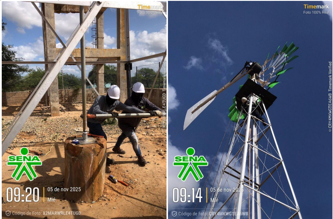
Nota: Desmontaje de la bomba del molino para mantenimiento, en paralelo con el reemplazo de la plataforma operativa para garantizar la seguridad de las personas cuando realicen el cambio del molino de viento.
