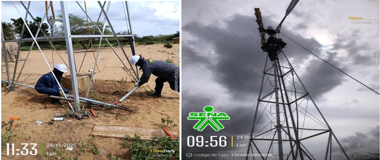
Figura 1. Inicio de actividades de mantenimiento en KOUIPANA.
