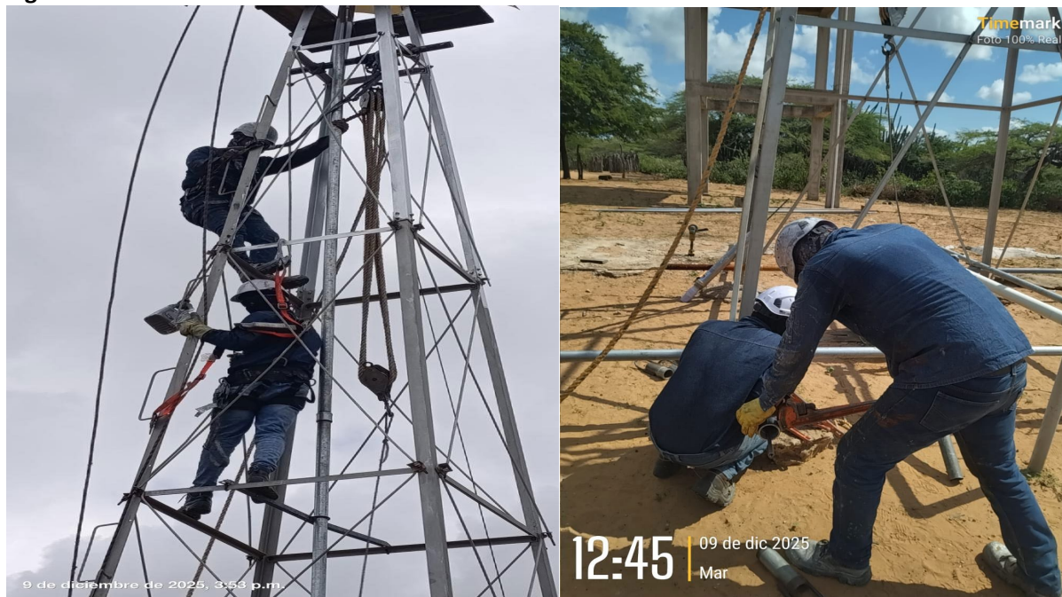
Figura 1. Inicio de actividades de mantenimiento en SANTA ELENA.
