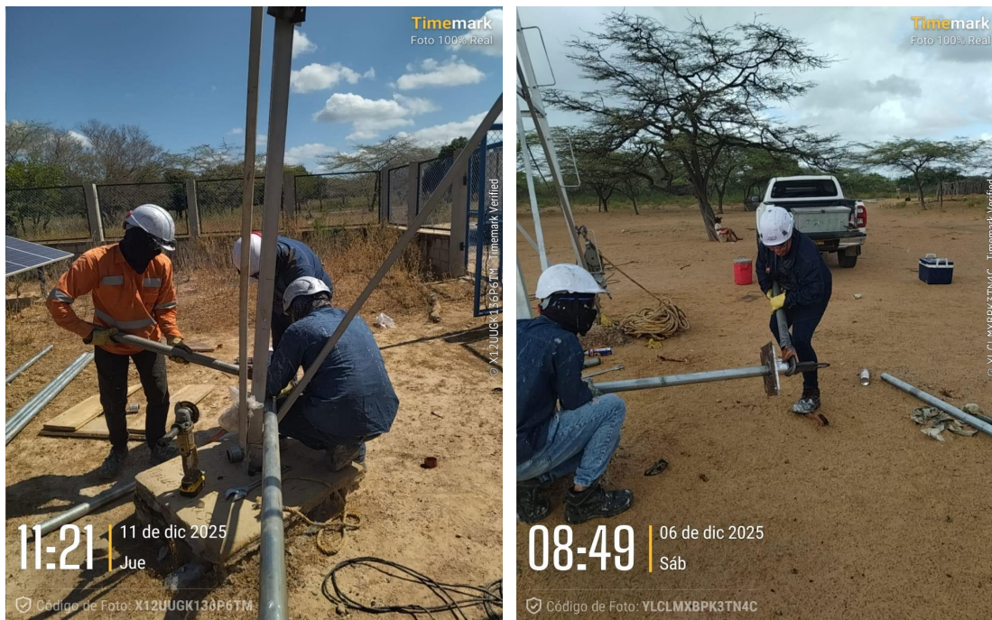
Figura 1. Mantenimiento y cambio de tuberías y varillas de molinos
