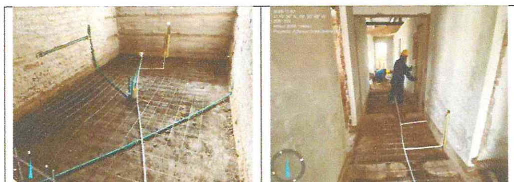
Acometida hidráulica y eléctrica
