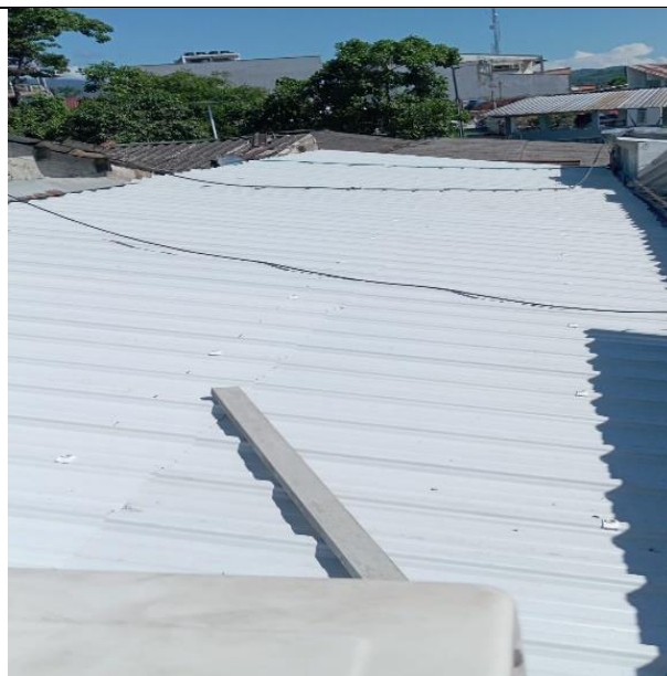
Suministro e instalación de cubierta en UPVC cresta alta e:2,5mm
