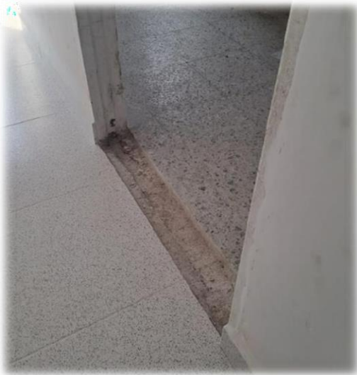
Detección boca puerta en estado de deterioro, aplicar acciones correctivas
