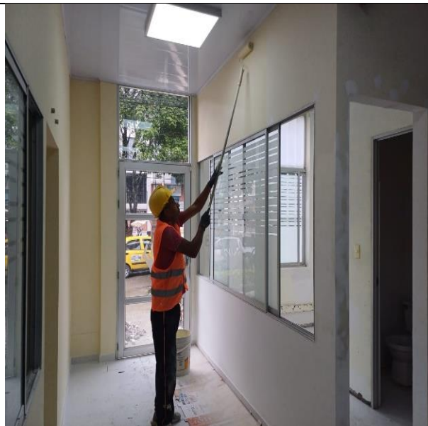
aplicación de pintura vinilo tipo I sobre muros lavable
