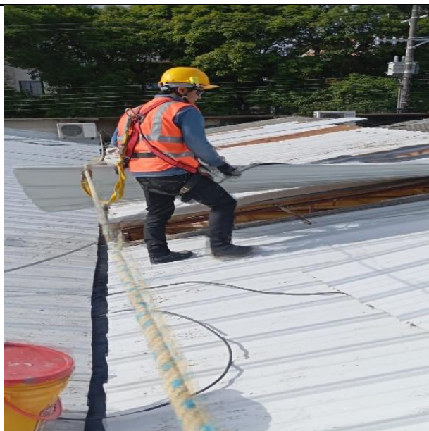
Suministro e instalación de cubierta en UPVC cresta alta e:2,5mm
