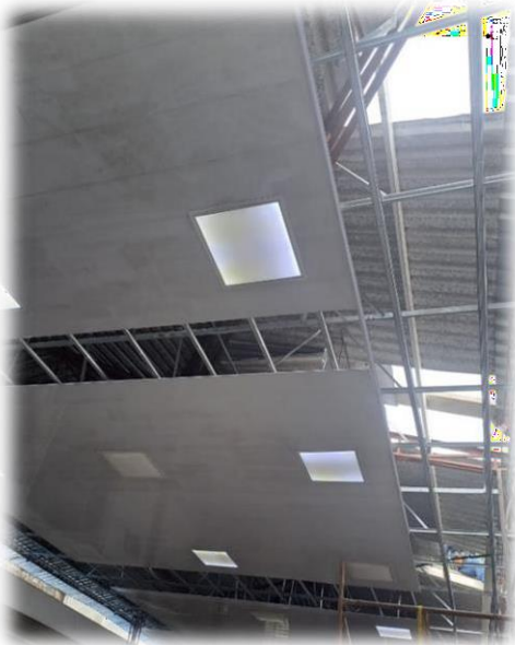
Suministro e instalación de lámparas led 60cm por 60cm, aplicar acciones correctivas
