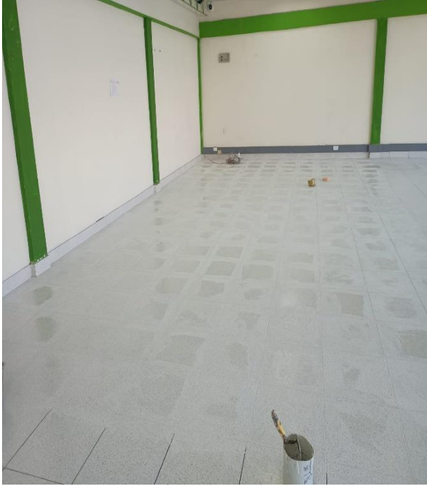
Guarda escoba en cerámica (incluye corte, pegador y boquilla)
