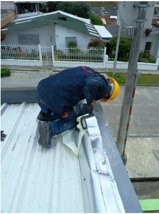
Estuco acrílico para filos y dilataciones
