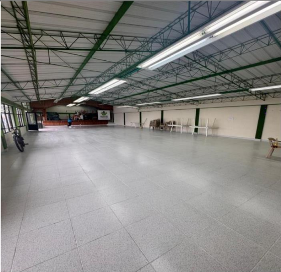
Retiro y disposición final de cubierta existente y Suministro e instalación de cubierta UPVC creta alta 2.5 mm, incluye tornillería.
