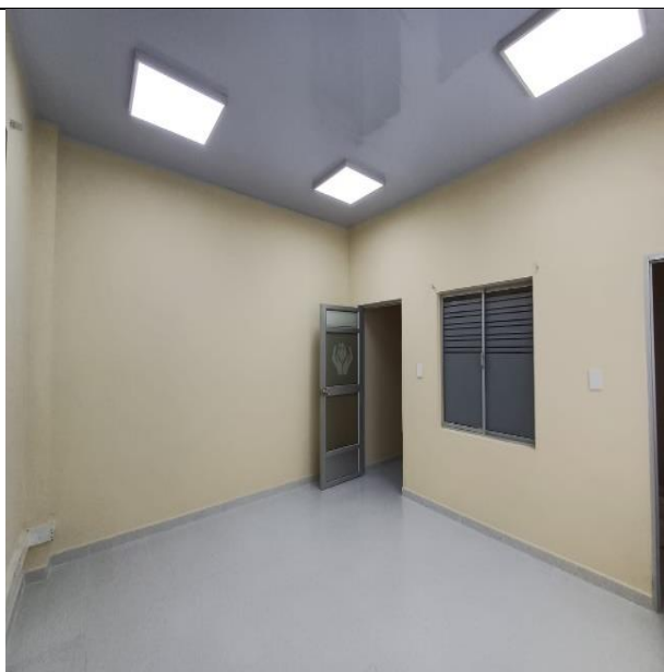
Suministro e instalación de luminaria led 8" para incrustar, 18w, luz blanca, 120v
