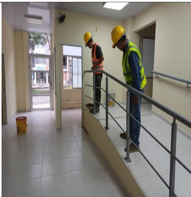
Instalación de barandas metálicas existentes (incluye anticorrosivo y pintura en esmalte).
