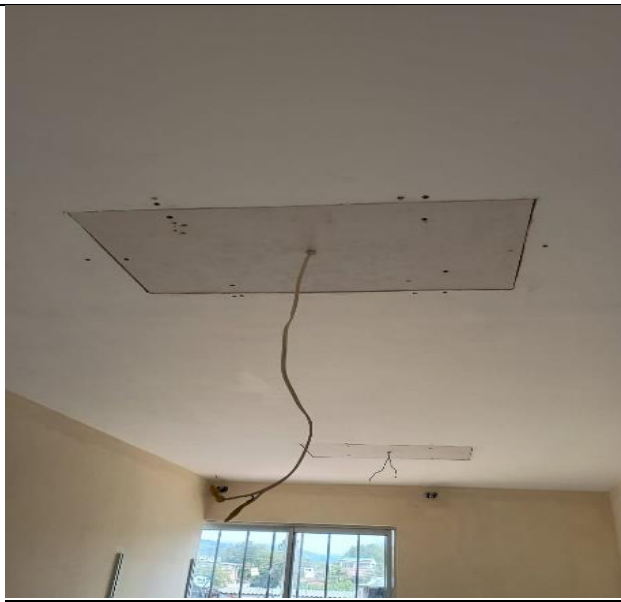
Taponamiento de aberturas de luminarias existentes
