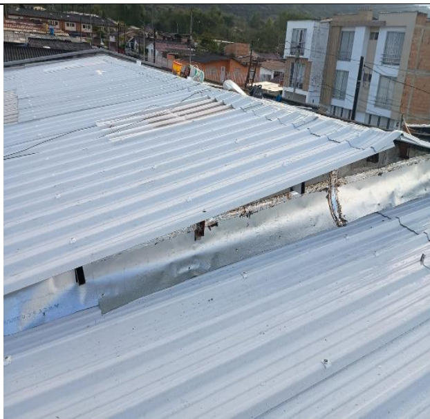
instalación de cubierta UPVC creta alta 2.5 mm, incluye tornillería.
