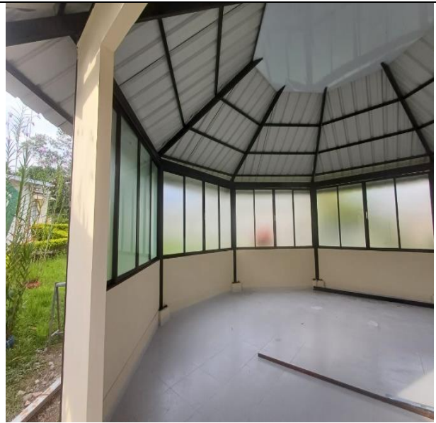
Instalación de ventana en aluminio, divisiones en drwall y cambio de cubierta UPVC cresta alta.
