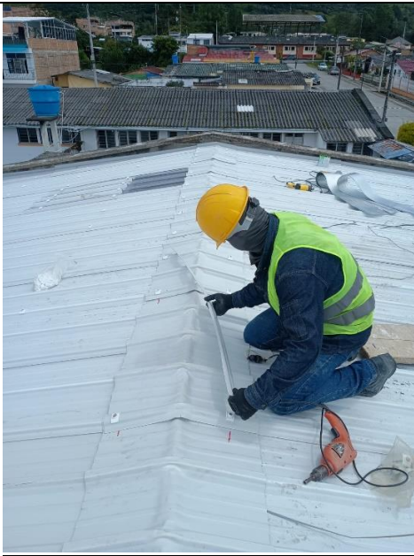
Suministro e instalación de cinta multiseat
