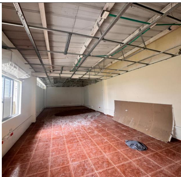
suministro e instalación de cielo raso en UPVC, aplicación de pintura en mampostería e instalación de luminarias 60x60
