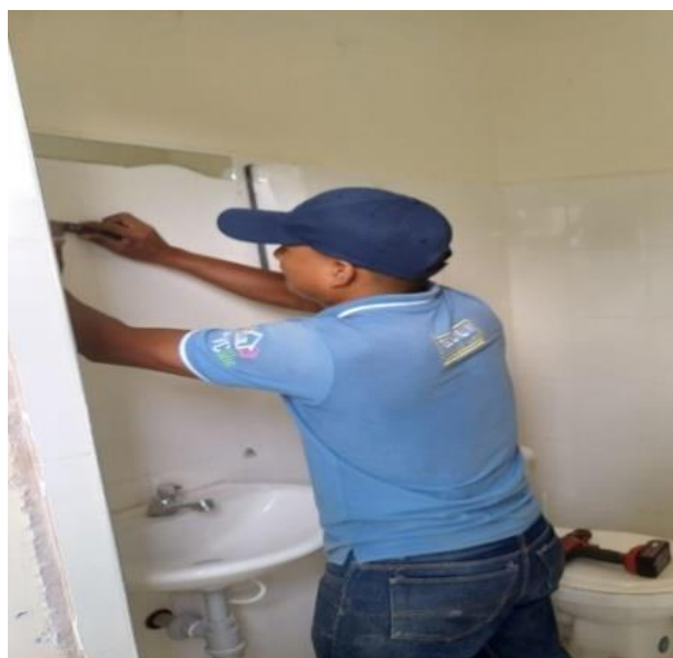
Retiro y disposición final de espejos
