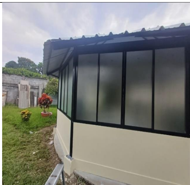
Instalación de muro superboar
