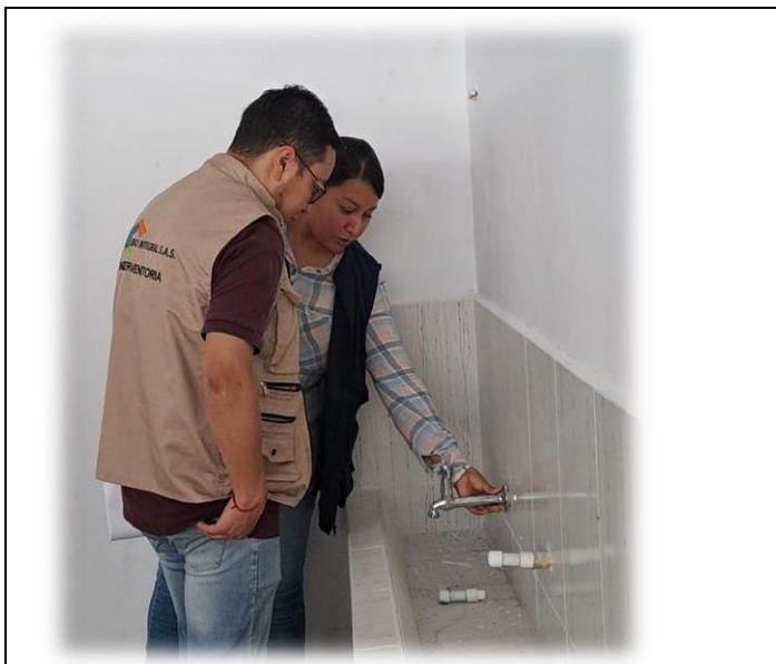
Detección de salida para punto hidráulico en mal estado, aplicar acciones correctivas y reemplazo de grifería
