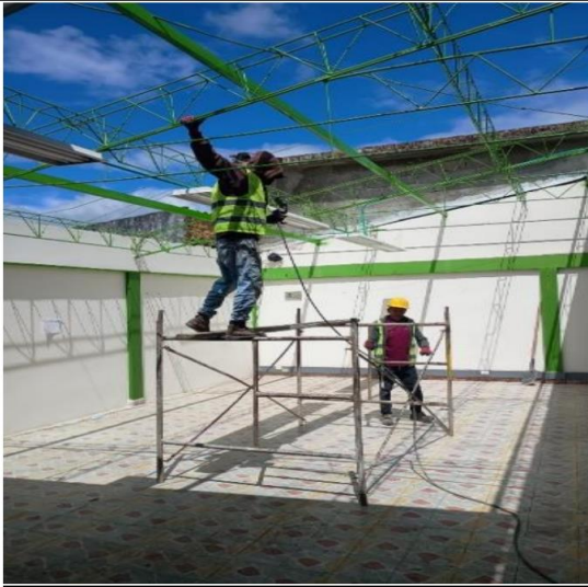
Retiro y disposición final de cubierta existente y Suministro e instalación de cubierta UPVC creta alta 2.5 mm, incluye tornillería.
