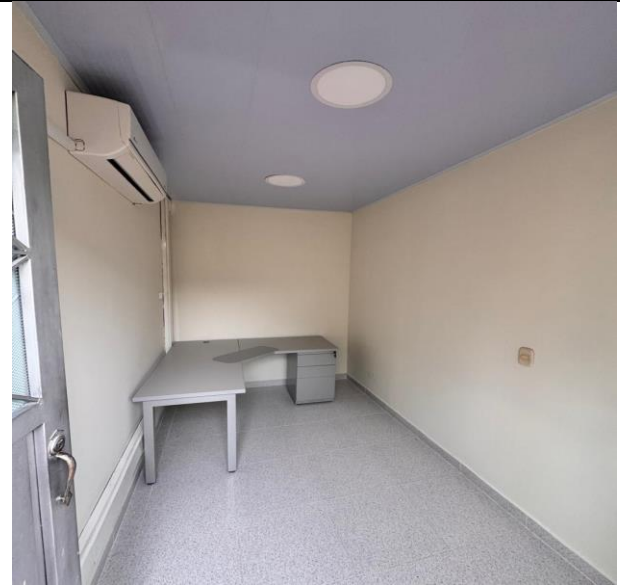
Retiro y disposición final del piso existente, y suministro e instalación de sistema de piso y cielo raso en PVC (UPVC).
