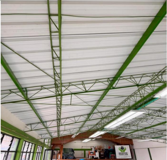
Retiro y disposición final de cubierta existente y Suministro e instalación de cubierta UPVC creta alta 2.5 mm, incluye tornillería.
