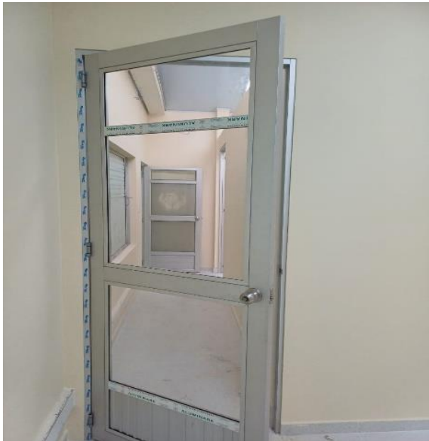
Suministro e instalación de puerta sencilla en aluminio entamborada (Incluye Chapa). (1,0x2,20)
