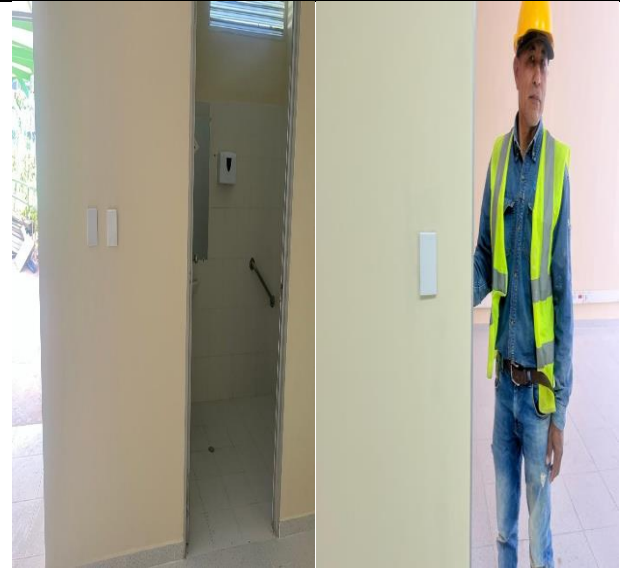
Suministro e instalación de interruptores sencillos y dobles.
