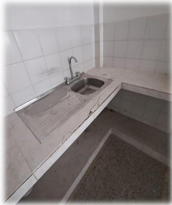
Detección de enchape en mal estado, aplicar acciones correctivas
