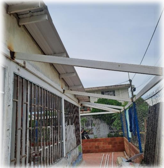
Escasez de masilla en anclaje de la parte superior
