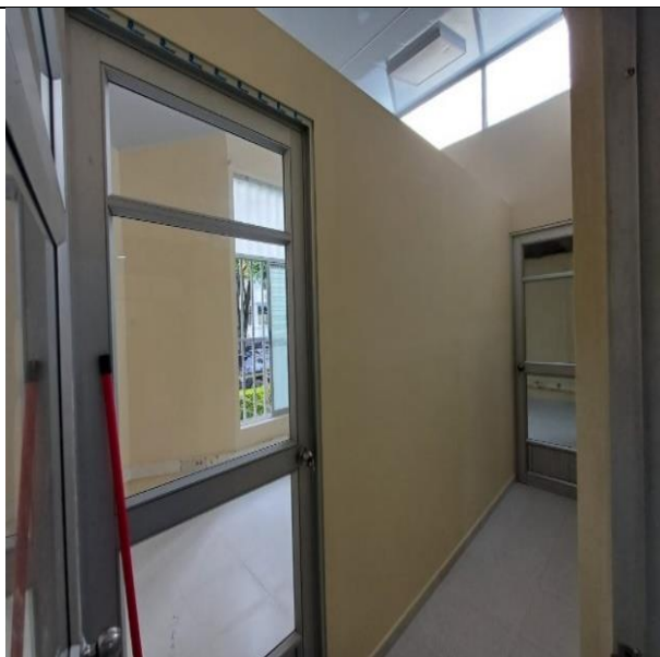
División de muro drywall doble cara 0.10 M- (incluye estructura, accesorios, anclaje, cinta y pintura).
