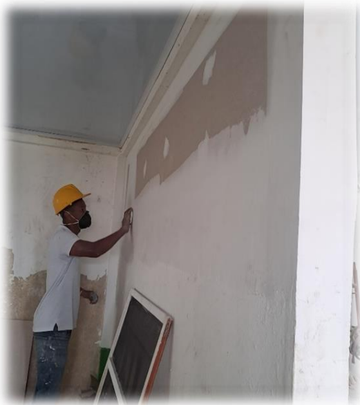
verificación de instalación de muro drywall doble cara 0.10 m- (incluye estructura, se identifica buena modulación, con bajas capas de pintura, realizar acciones correctivas
