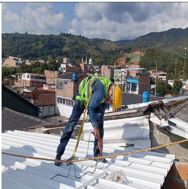
instalación de cubierta UPVC creta alta 2.5 mm, incluye tornillería.
