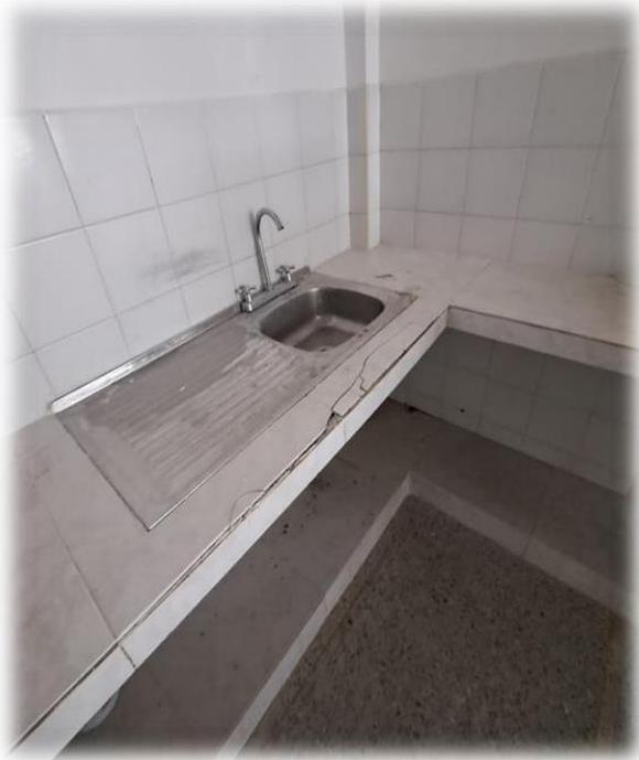
Detección de enchape en mal estado, aplicar acciones correctivas
