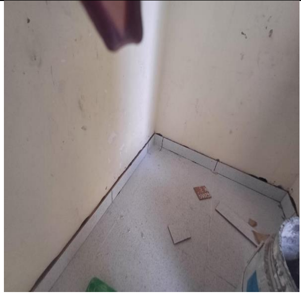
Guarda escoba en cerámica (incluye corte, pegacor y boquilla)
