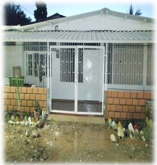
Adecuaciones de rampa de acceso principal y mantenimiento de mampostería de los bloques perimetrales.
