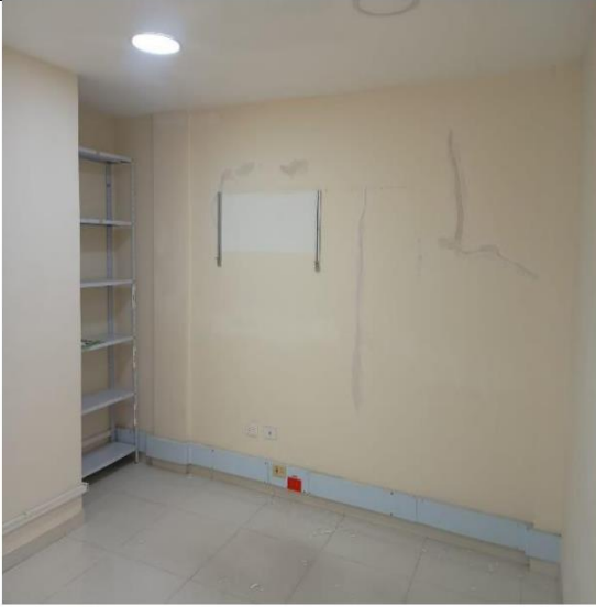
Estuco acrílico para filos y dilataciones
