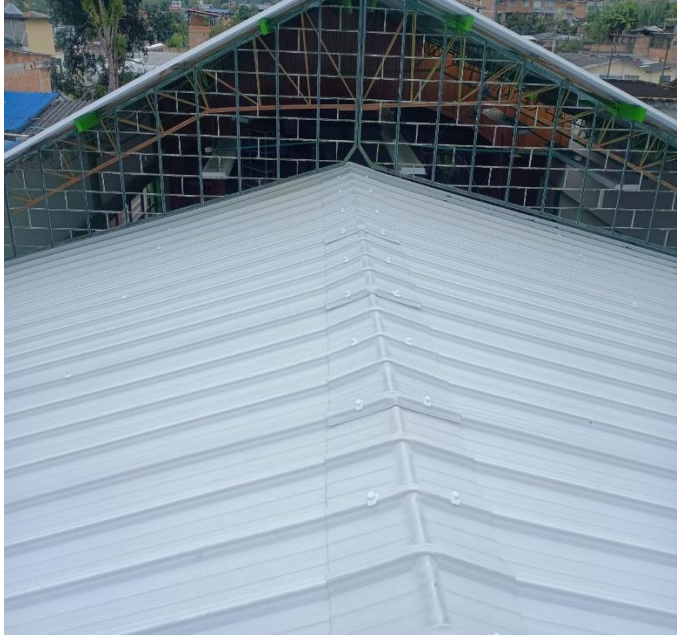
Suministro e instalación de perfiles cal 18 incluye anticorrosivo y pintura esmalte
