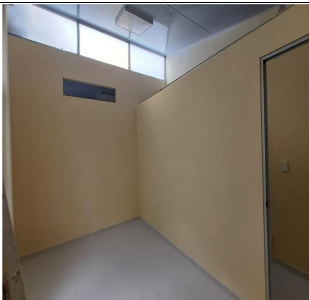
División de muro drywall doble cara 0.10 M- (incluye estructura, accesorios, anclaje, cinta y pintura).
