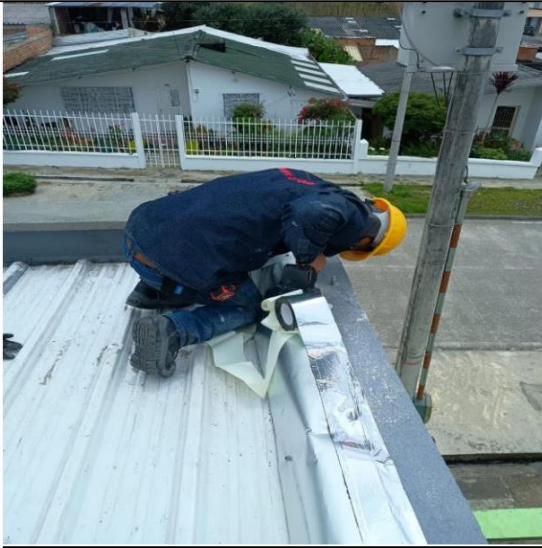
Suministro e instalación de cinta multiseat
