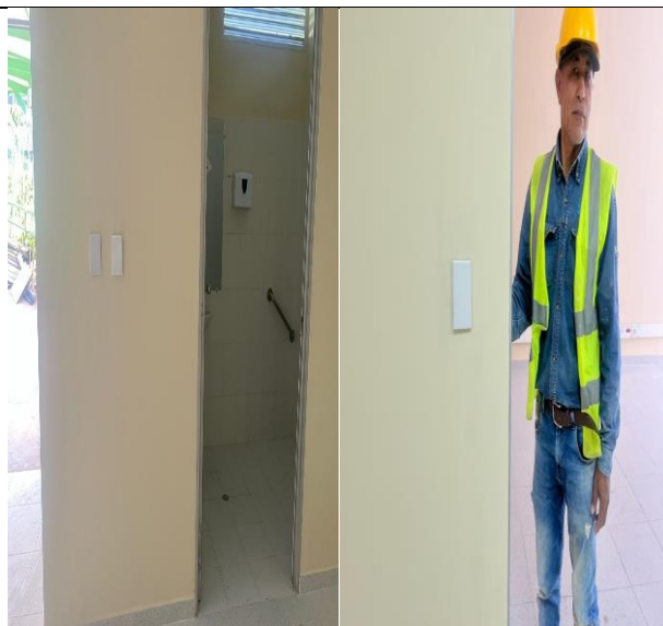
Suministro e instalación de interruptores sencillos y dobles.
