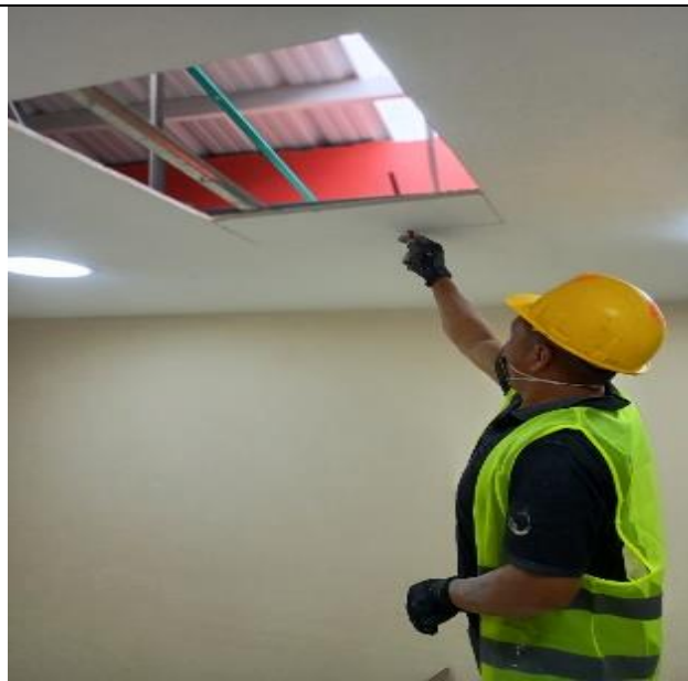
Instalación de acrílicos traslucidos para el paso de luz natural
