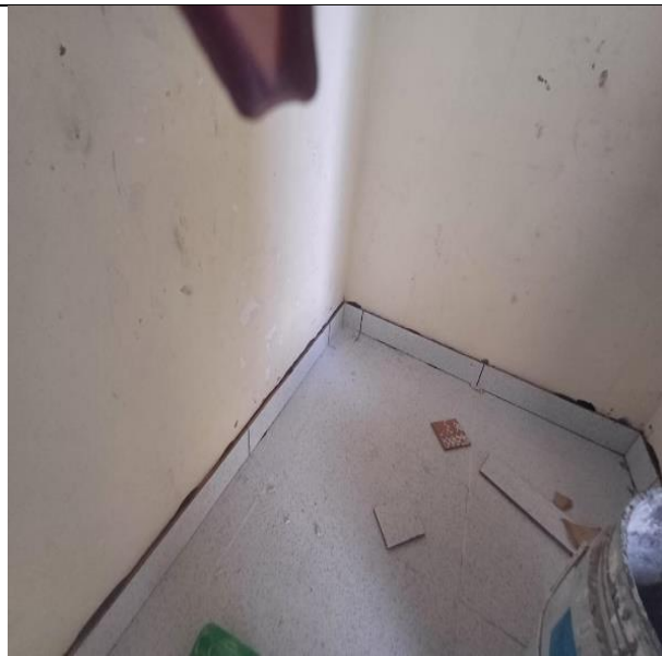
Guarda escoba en cerámica (incluye corte, pegador y boquilla)
