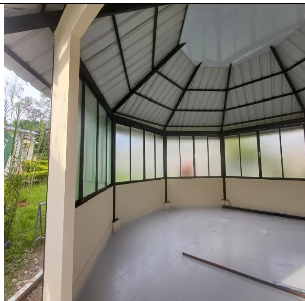
Instalación de ventana en aluminio, divisiones en driwall y cambio de cubierta UPVC cresta alta.
