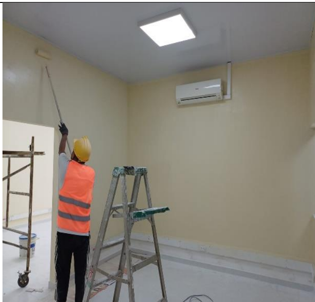
aplicación de pintura vinilo tipo I sobre muros lavable
