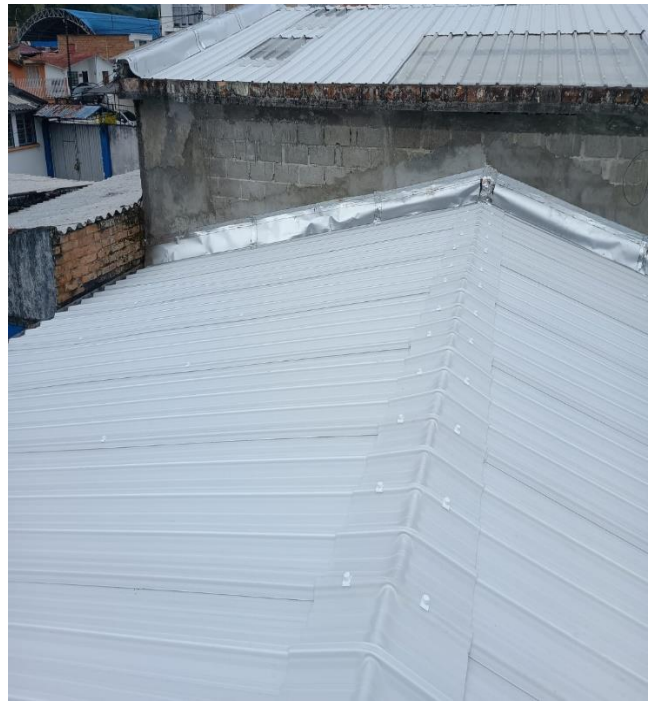
Limpieza y mantenimiento en pintura tipo sika fill viga canal
