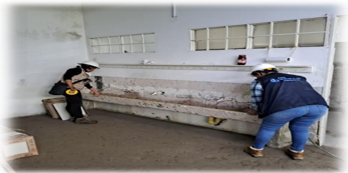
Detección de grifos en mal estado, aplicar acciones correctivas
