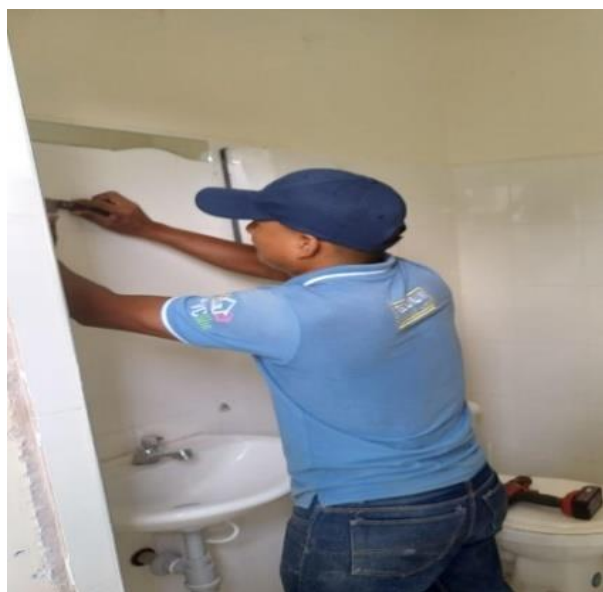
Retiro y disposición final de espejos
