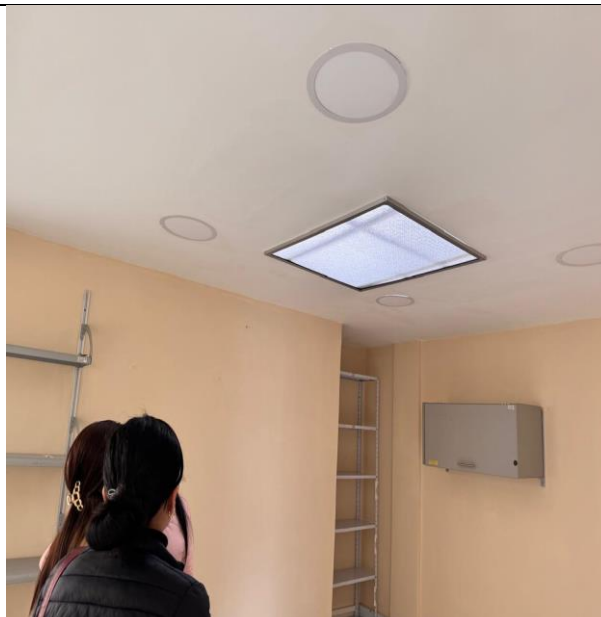
Instalación de acrílicos traslucidos para el paso de luz natural
