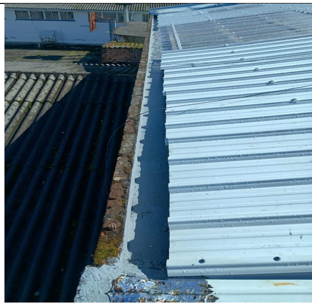
Limpieza y mantenimiento en pintura tipo sika fill viga canal
