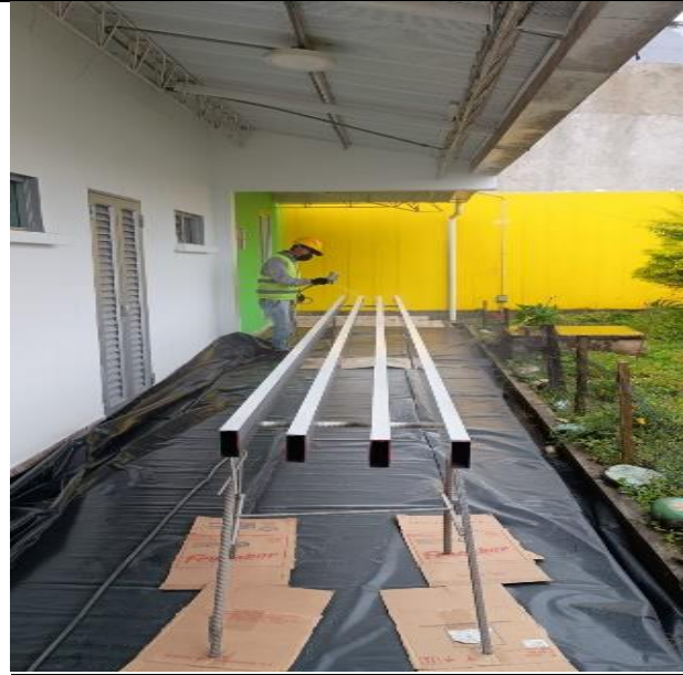
Suministro e instalación de perfiles cal 18 incluye anticorrosivo y pintura esmalte
