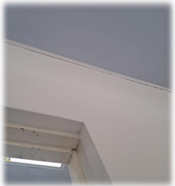
Se debe ajustar revoques entre cornisa y cielo raso y pared con estuco acrílico
