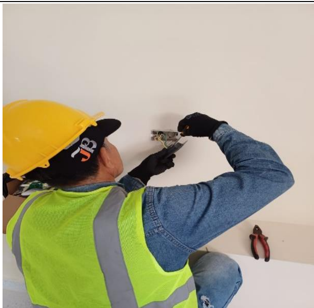
Desmante de interruptores existentes en mal estado.
