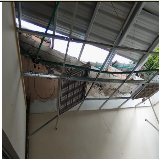
Desmonte cielo raso en cualquier material
