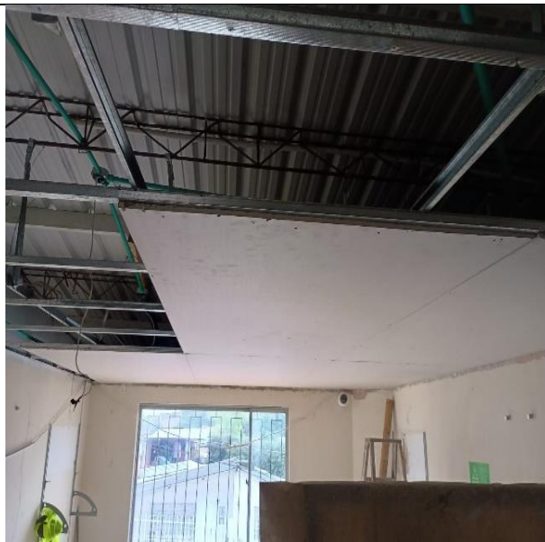
Cielo raso en drywall con perfilera de aluminio (incluye acabado final con cinta y pintura).
