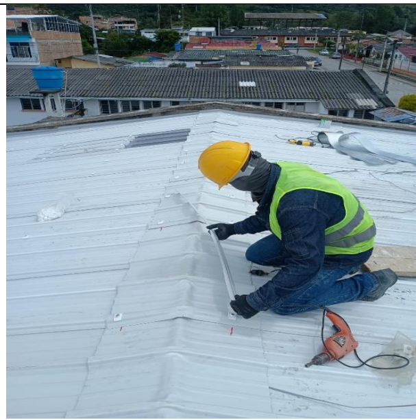
Limpieza y mantenimiento en pintura tipo sika fill viga canal
