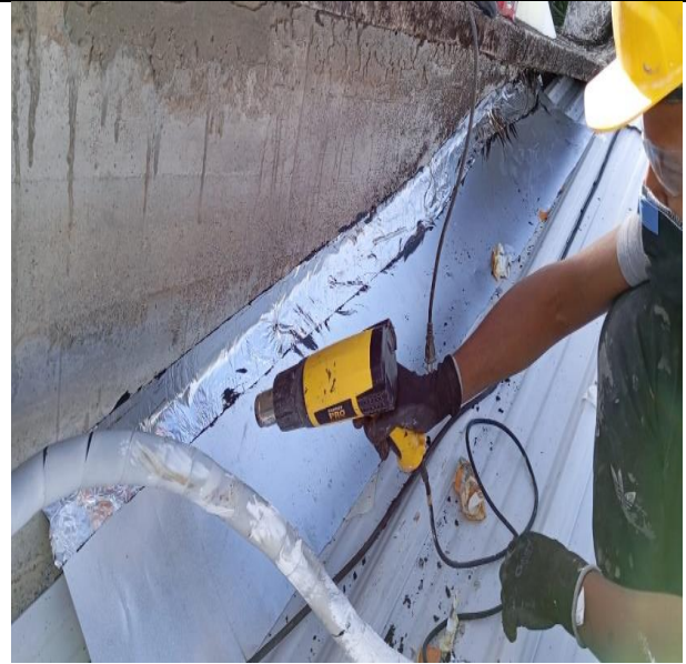
Suministro e instalación de cinta multiseat e:15cm. Incluye accesorios para su correcta instalación
