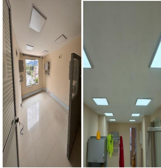
Mantenimiento de cielo raso en drwall y cambio de luminarias de 60x60
