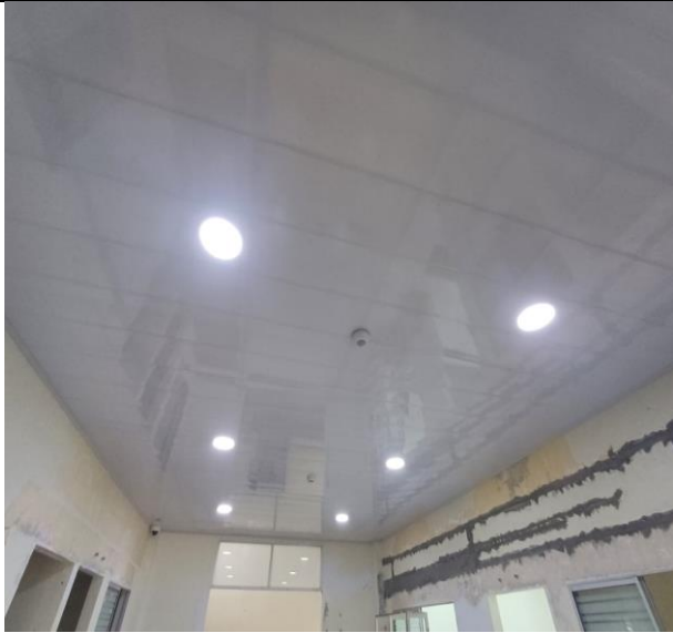
Suministro e instalación de cielo raso en PVC
