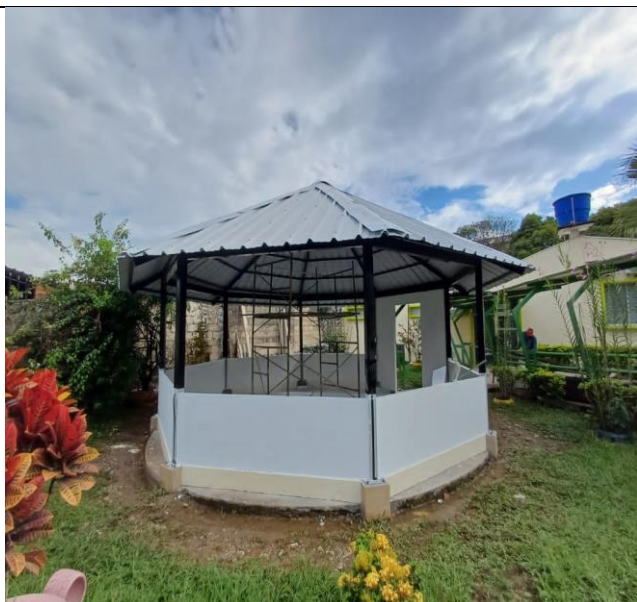
Instalación de muro superboard
