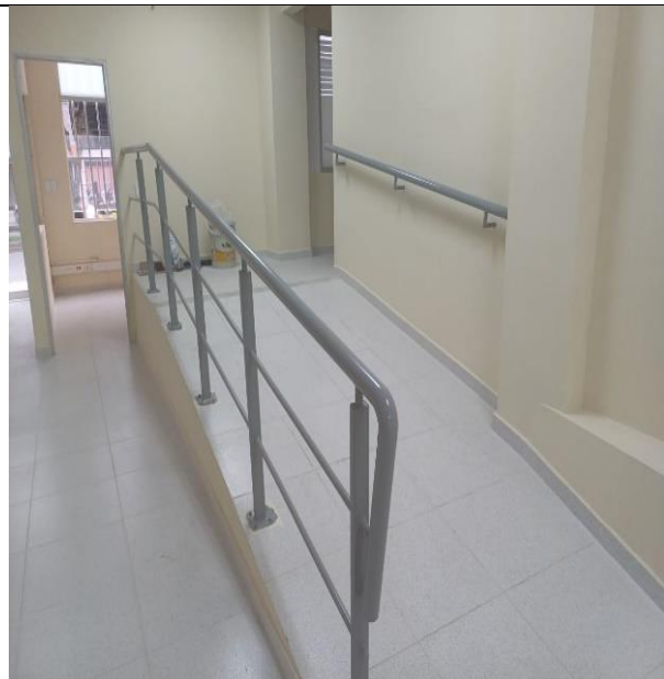
Instalación de barandas metálicas existentes (incluye anticorrosivo y pintura en esmalte).
