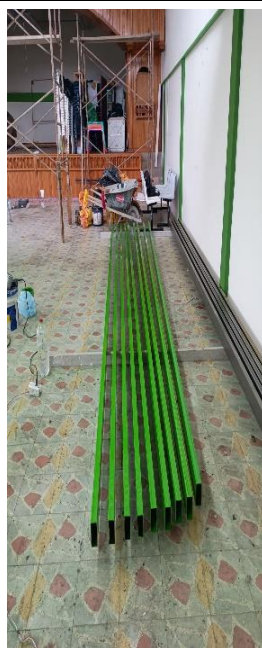
Suministro e instalación de flanches lámina galvanizada cal 20
