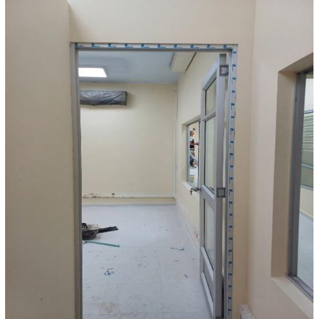
Suministro e instalación de puerta sencilla en aluminio entamborada (Incluye Chapa). (1,0x2,20)
