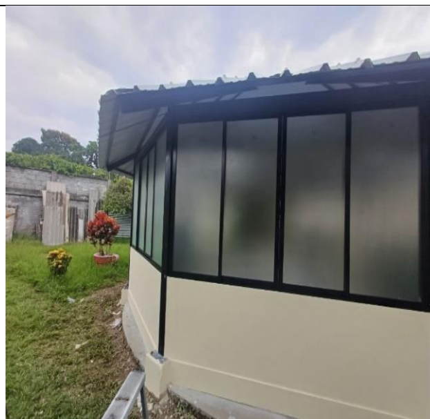
Instalación de muro superboard
