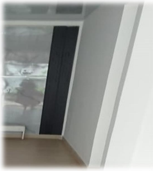
verificación de instalación de muro drywall doble cara 0.10 m- (incluye estructura, se identifica buena modulación, con bajas capas de pintura, realizar acciones correctivas
