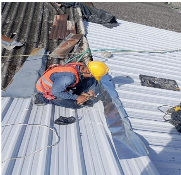
Suministro e instalación de flanches en lámina galvanizada cal 20
