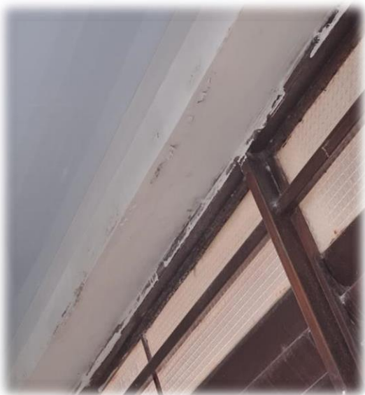
Presencia de humedad sobre la viga aérea
