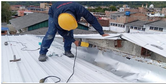
Suministro e instalación de cinta multiseat
