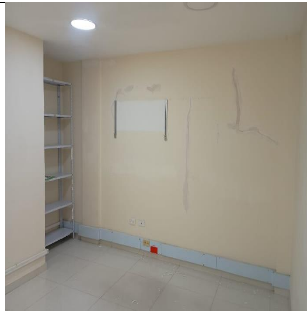
Estuco acrílico para filos y dilataciones
