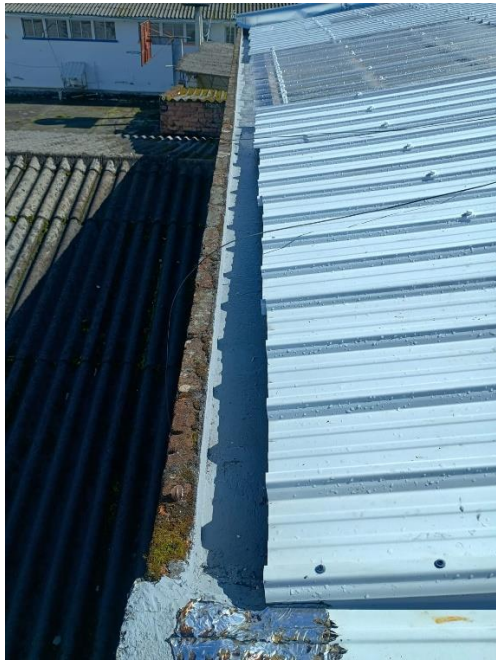
Vinilo tipo i sobre muros lavable (incluye aplicación 3 manos)
