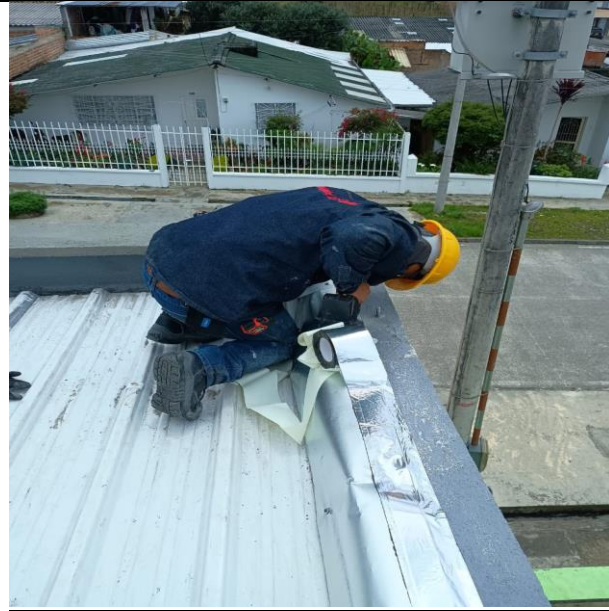
Suministro e instalación de cinta multiseat
