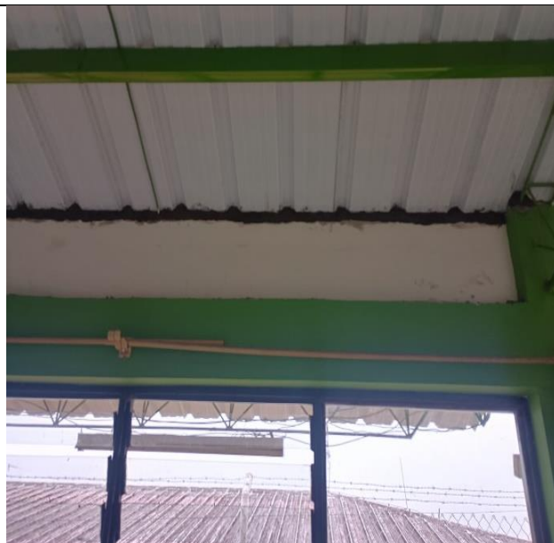
Retiro y disposición final de cubierta existente y Demolición y emparejamiento revoque de cubierta
