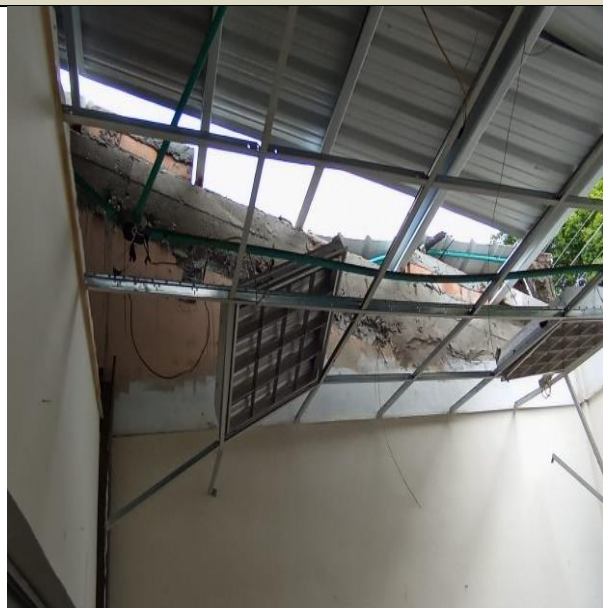
Desmonte cielo raso en cualquier material
