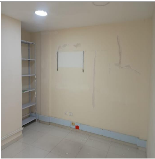
Estuco acrílico para filos y dilataciones
