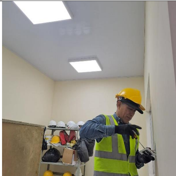
Desmante de interruptores existentes en mal estado.
