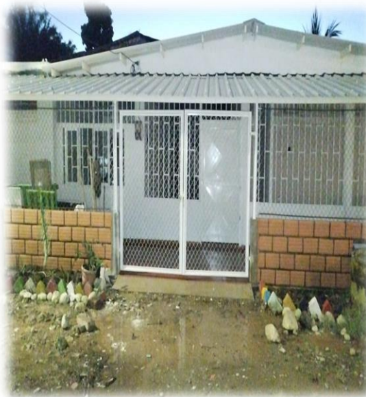
Adecuaciones de rampa de acceso principal y mantenimiento de mampostería de los bloques perimetrales.
