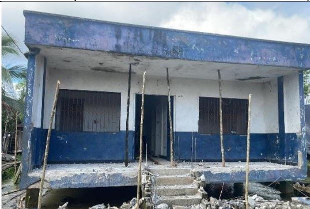
Demolición de bordillos
