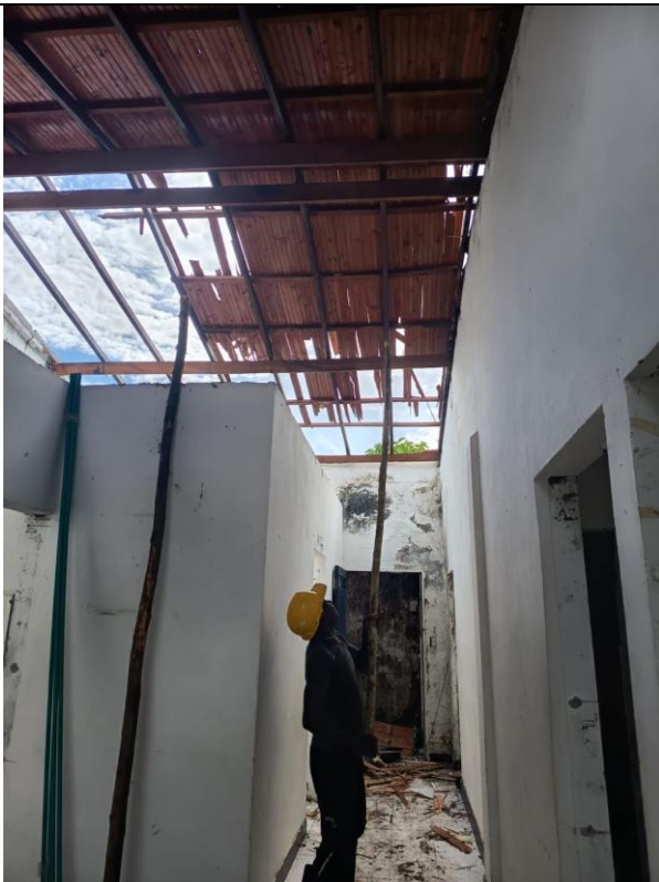
Desmante de cubierta y cielo falso
