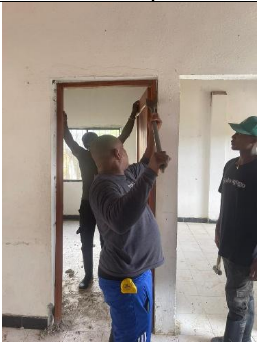
Retiro de puertas
