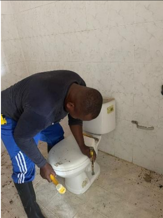
Retiro de aparatos sanitarios
