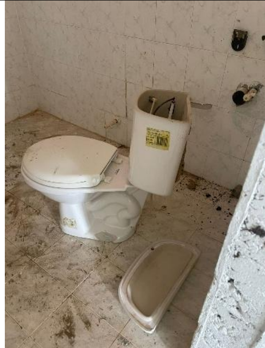
Retiro de aparatos sanitarios
