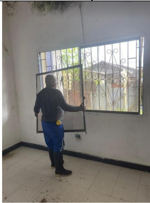
Retiro de ventanas
