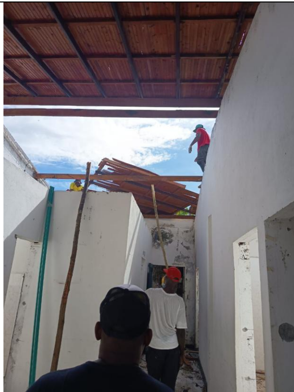
Desmante de cubierta y cielo falso
