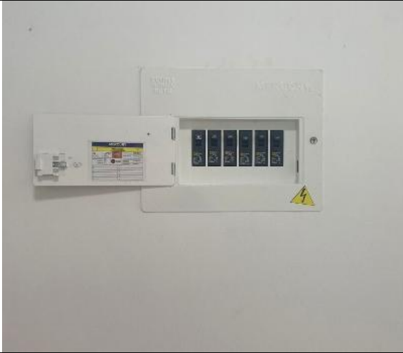
Instalación de caja de breaker
