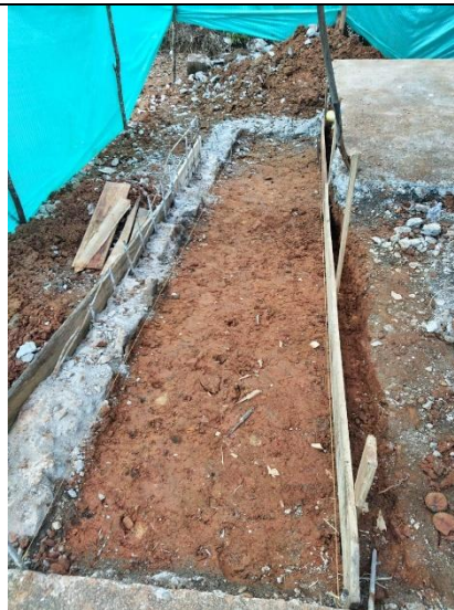
Conformación de rampa de acceso
