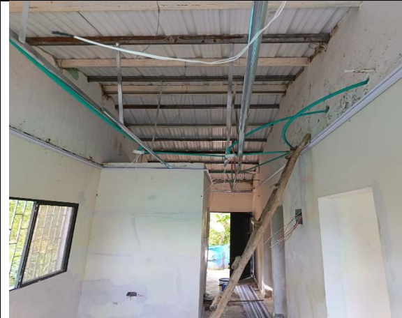
Desmonte de cielo falso
