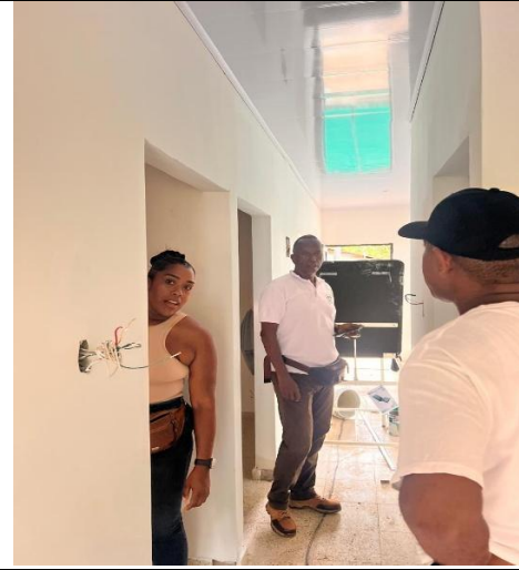
Visita de supervisión de obra
