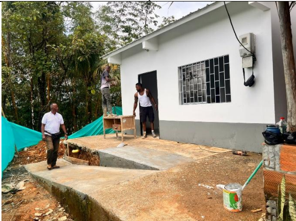
Pintura externa / rampa en concreto
