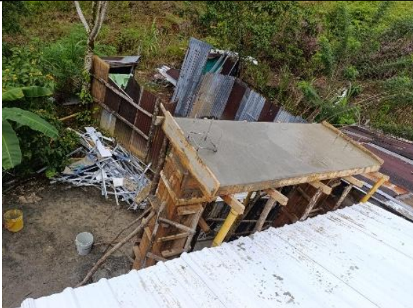
Construcción de tanquera en concreto
