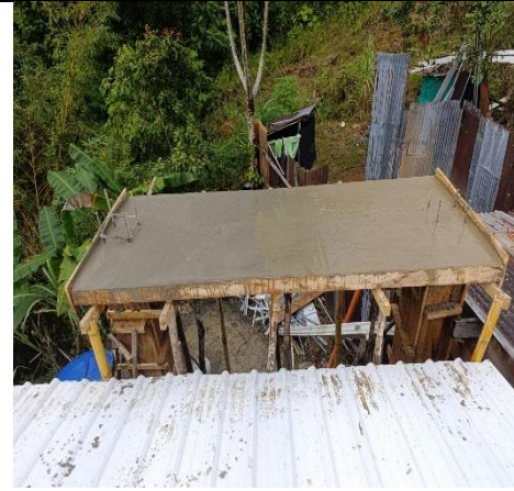
Construcción de tanquera en concreto
