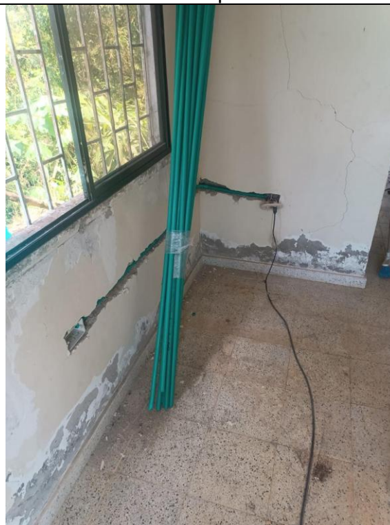
Regata para instalaciones eléctricas
