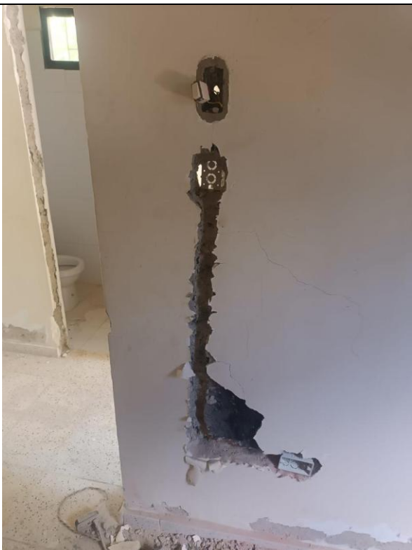
Regata para instalaciones eléctricas
