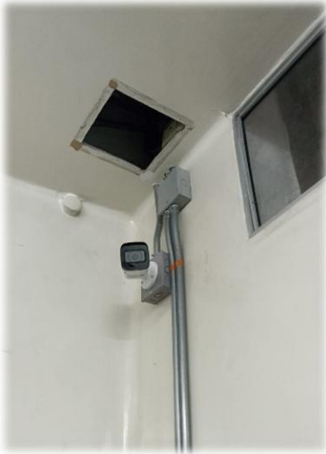
Cámara en Economato Fundacional
