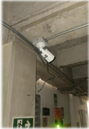
Cámara 2 en Sótano Bloque C
