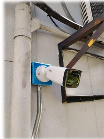
Cámara hacia Bodega de Asear Bloque Patrimonial
