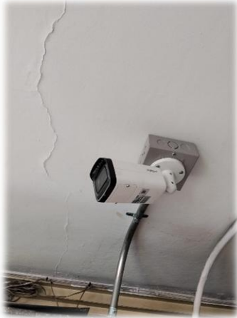
Cámara en Pasillo de Baño piso 2 Bloque patrimonial
