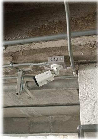
Cámara en Rampa Parqueadero Bloque C
