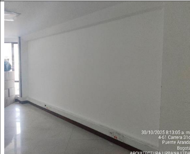
FOTO No 10: La interventoría ARQUITECTURA URBANA LTDA., revisa y verifica la construcción de muros superboard de 8 mm en ambas caras para la zona de depósito de residuos peligrosos y Vestier, ubicados en el primer piso de la ALCALDÍA LOCAL DE PUENTE ARANDA.
