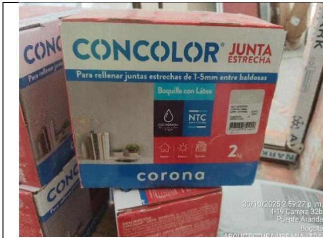
FOTO No 3: La interventoría ARQUITECTURA URBANA LTDA., revisa y verifica la llegada de boquilla y cerámica de 20x30cm para enchape de muros de baño en el edificio de la JUNTA ADMINISTRATIVA LOCAL (JAL).
