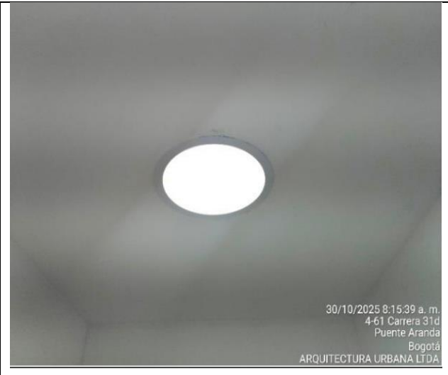
FOTO No 8: La interventoría ARQUITECTURA URBANA LTDA., revisa y verifica la instalación PANEL LED REDONDO DE SOBREPONER 24W, en zona de vestir de la ALCALDÍA LOCAL DE PUENTE ARANDA y puntos fijos de las escaleras de la JAL.
