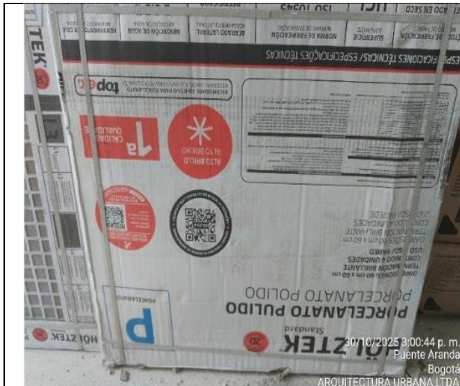
FOTO No 1: La interventoría ARQUITECTURA URBANA LTDA., revisa y verifica la llegada de porcelanato de 60x60 para piso de baños de la ALCALDÍA LOCAL DE PUENTE ARANDA.
