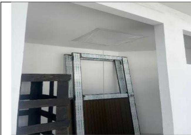
FOTO No 11: La interventoría ARQUITECTURA URBANA LTDA., revisa y verifica la llegada de puertas en aluminio para los depósitos y/o Vestier de la ALCALDÍA LOCAL DE PUENTE ARANDA.
