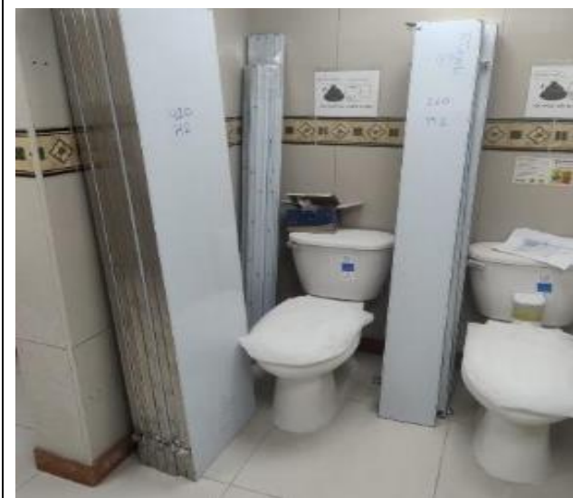
FOTO No 13: La interventoría ARQUITECTURA URBANA LTDA., revisa y verifica la llegada de las DIVISIÓN PARA BAÑO y PARA ORINAL EN ACERO INOXIDABLE CALIBRE 20 para baños de la ALCALDÍA LOCAL DE PUENTE ARANDA.
