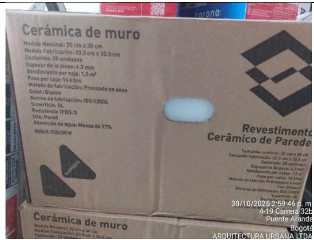
FOTO No 4: La interventoría ARQUITECTURA URBANA LTDA., revisa y verifica la llegada de boquilla y cerámica de 20x30cm para enchape de muros de baño en el edificio de la JUNTA ADMINISTRATIVA LOCAL (JAL)
