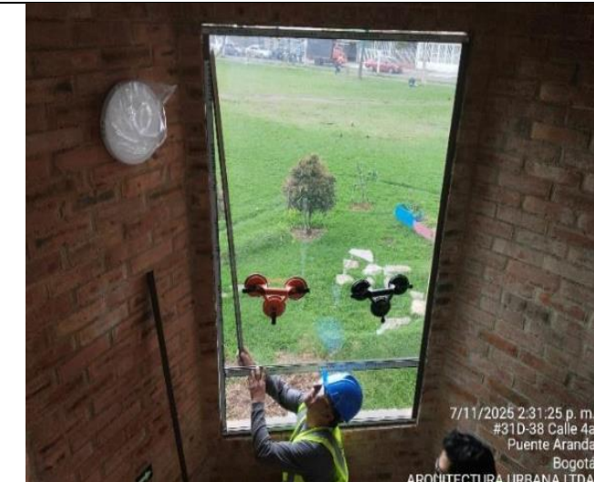
FOTO No 7: La interventoría ARQUITECTURA URBANA LTDA., revisa y verifica la instalación de ventanería en carpintería en aluminio e instalación de vidrio de 4 mm con película de seguridad en el edificio de la JUNTA ADMINISTRATIVA LOCAL (JAL).
