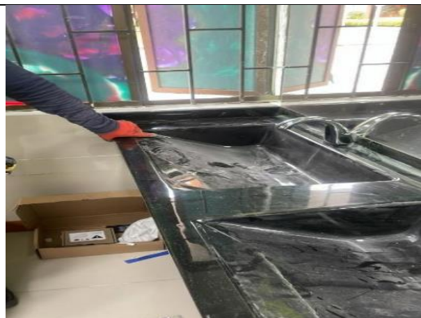
FOTO No 16: La interventoría ARQUITECTURA URBANA LTDA., revisa y verifica la llegada de mesones para la actividad de instalación en baños del primer piso, la cual será instalada en el primer piso de la ALCALDÍA LOCAL DE PUENTE ARANDA
