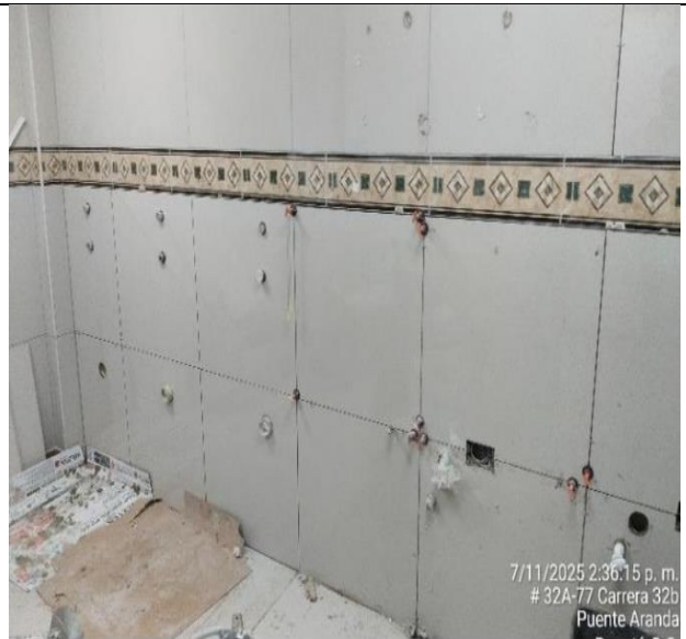
FOTO No 6: La interventoría ARQUITECTURA URBANA LTDA., revisa y verifica la actividad de enchape sobre muro en baños de mujeres y hombre del primer piso en edificio de la ALCALDÍA
