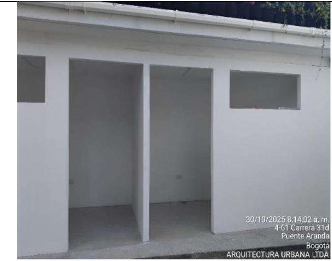
FOTO No 9: La interventoría ARQUITECTURA URBANA LTDA., revisa y verifica la construcción de muros superboard de 8 mm en ambas caras para la zona de depósito de residuos peligrosos y Vestier, ubicados en el primer piso de la ALCALDÍA LOCAL DE PUENTE ARANDA.
