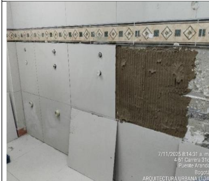
FOTO No 5: La interventoría ARQUITECTURA URBANA LTDA., revisa y verifica la actividad de enchape sobre muro en baños de mujeres y hombre del primer piso en edificio de la ALCALDÍA
