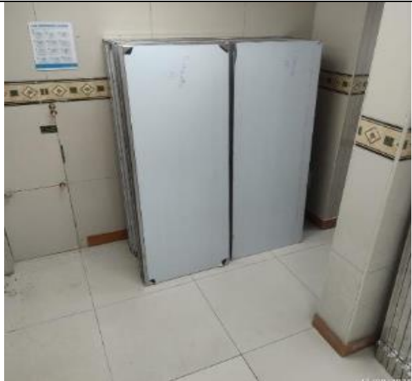
FOTO No 14: La interventoría ARQUITECTURA URBANA LTDA., revisa y verifica la llegada de las DIVISIÓN PARA BAÑO y PARA ORINAL EN ACERO INOXIDABLE CALIBRE 20 para baños de la ALCALDÍA LOCAL DE PUENTE ARANDA.
