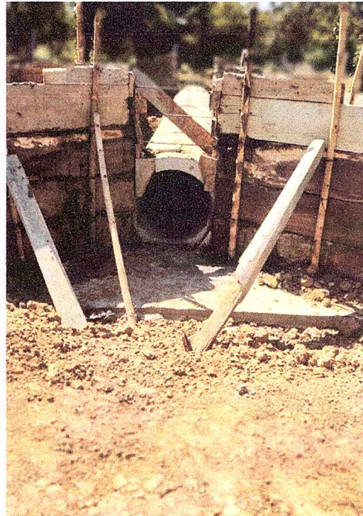
Fotografía 2. Instalación de anillos.
