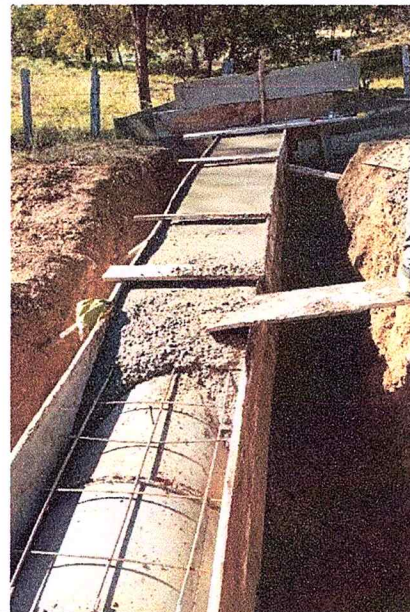
Fotografía 4. Vaciado de placa superior.
