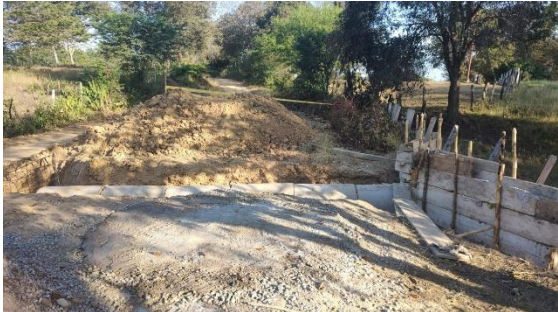
Ilustración 5. Instalación de anillos de drenaje.
