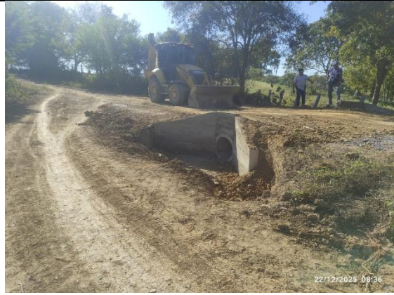
Ilustración 11. Alcantarilla terminada.
