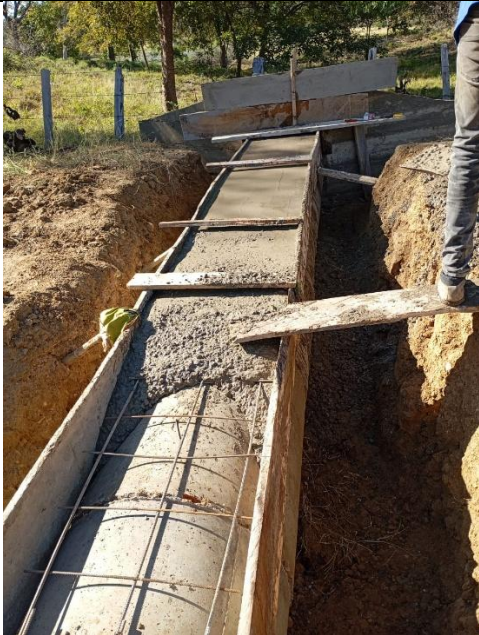
Ilustración 9. Vaciado de placa superior.
