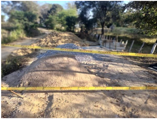
Ilustración 10. Suministro de materiales pétreos y señalización.
