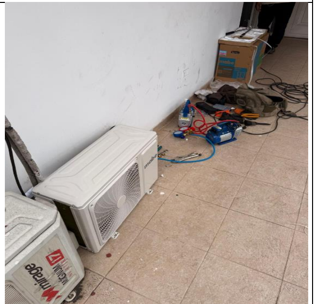
Foto 16 Suministro e instalación de aires acondicionados.
