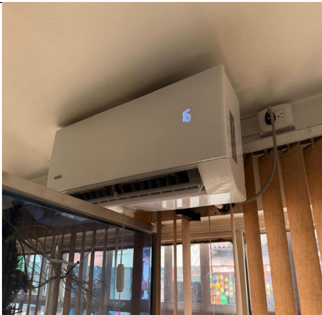
Foto 15 Suministro e instalación de aires acondicionados.
