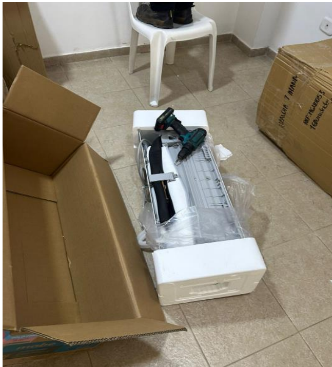
Foto 11 Suministro e instalación de aires acondicionados.
