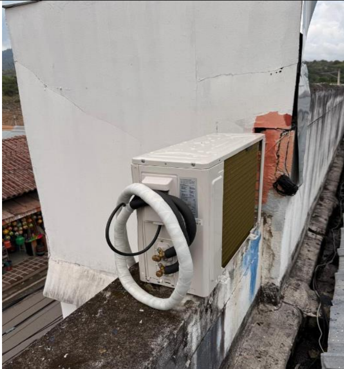
Foto 07 Suministro e instalación de aires acondicionados.
