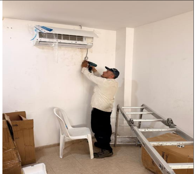
Foto 02 Suministro e instalación de aire acondicionado.
