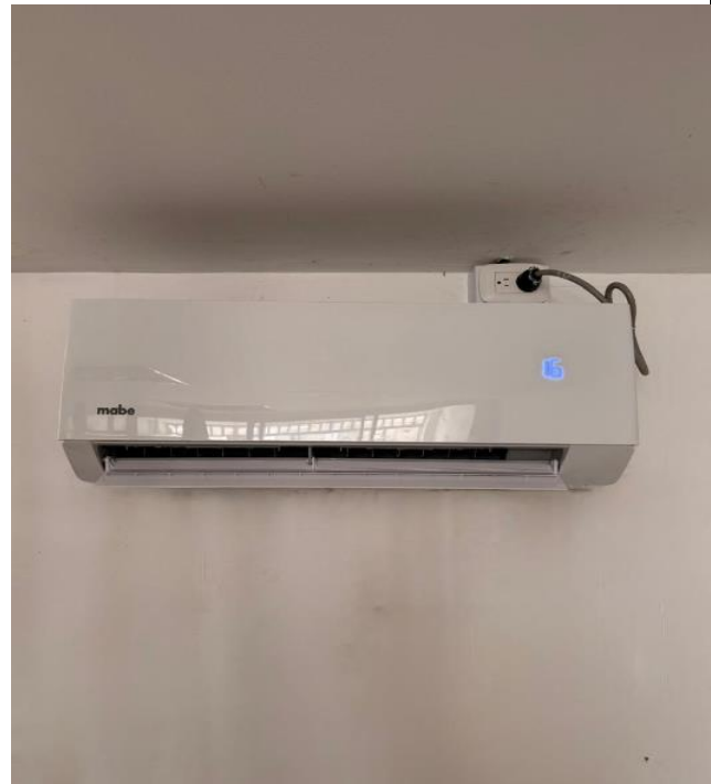
Foto 12 Suministro e instalación de aires acondicionados.
