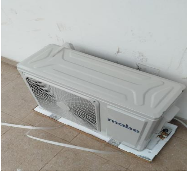
Foto 05 Suministro e instalación de aires acondicionados.
