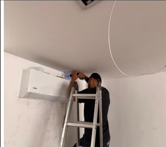
Foto 01 Suministro e instalación de aire acondicionado.
