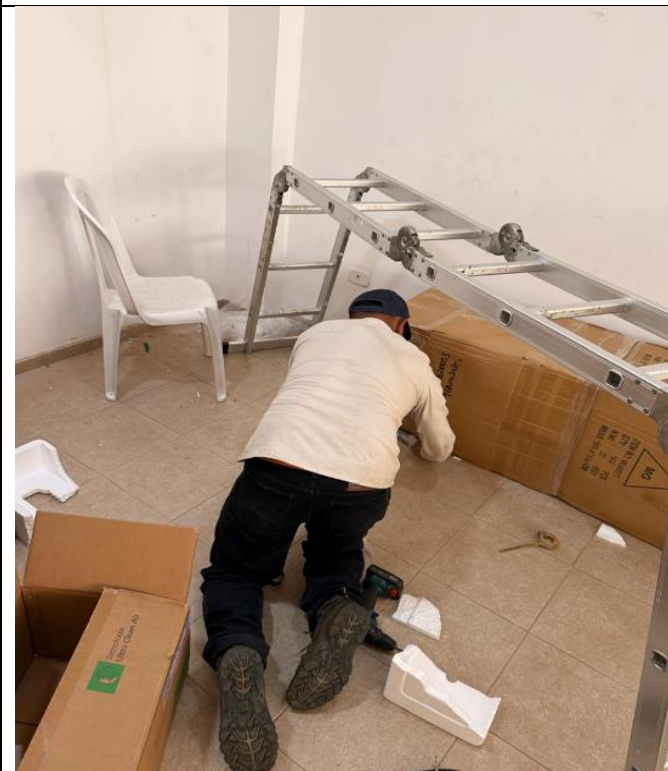
Foto 03 Suministro e instalación de aire acondicionado.
