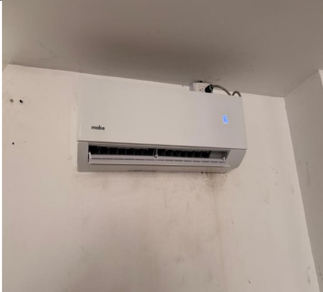
Foto 13 Suministro e instalación de aires acondicionados.
