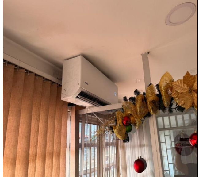
Foto 14 Suministro e instalación de aires acondicionados.
