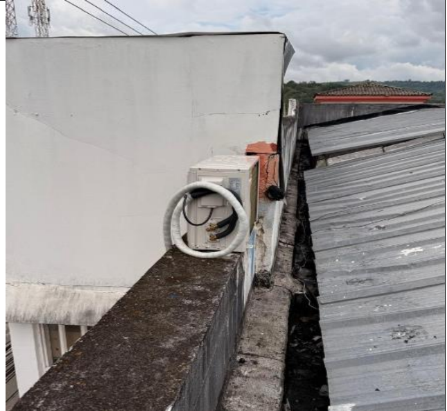
Foto 06 Suministro e instalación de aires acondicionados.
