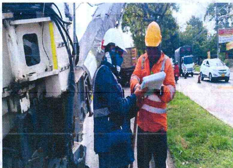
FOTOS. INSPECCIÓN PREOPERACIONALES DE MAQUINARIA
