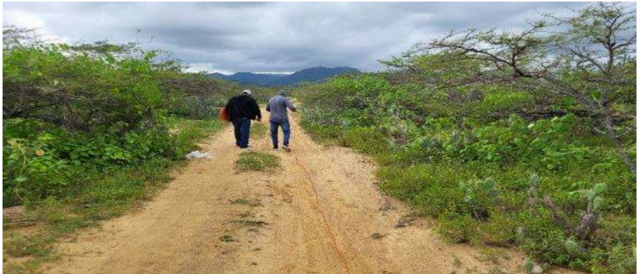
Figura 1 - 06 Regado de cable y electros, tomografía 5.
