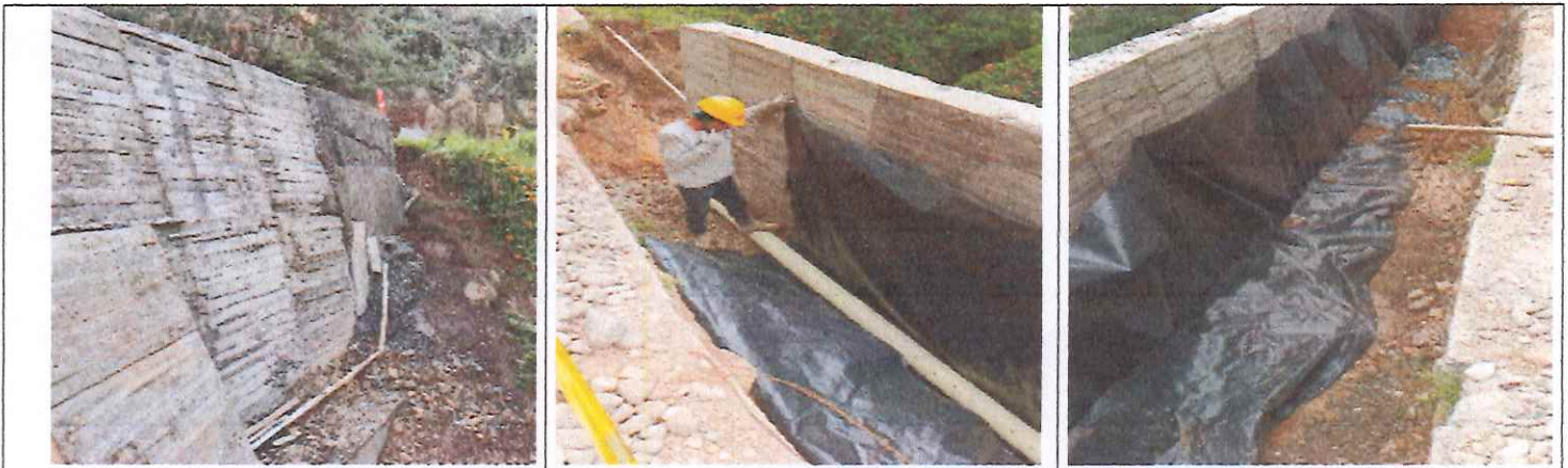
CONCRETO DE MURO Y GEOTEXTIL
