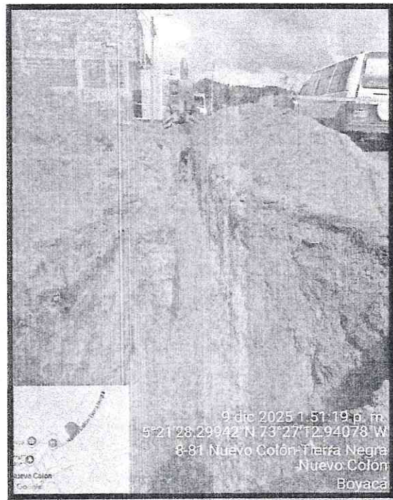
Foto 12: Suministro, instalación y compactación de recebo en red principal.
