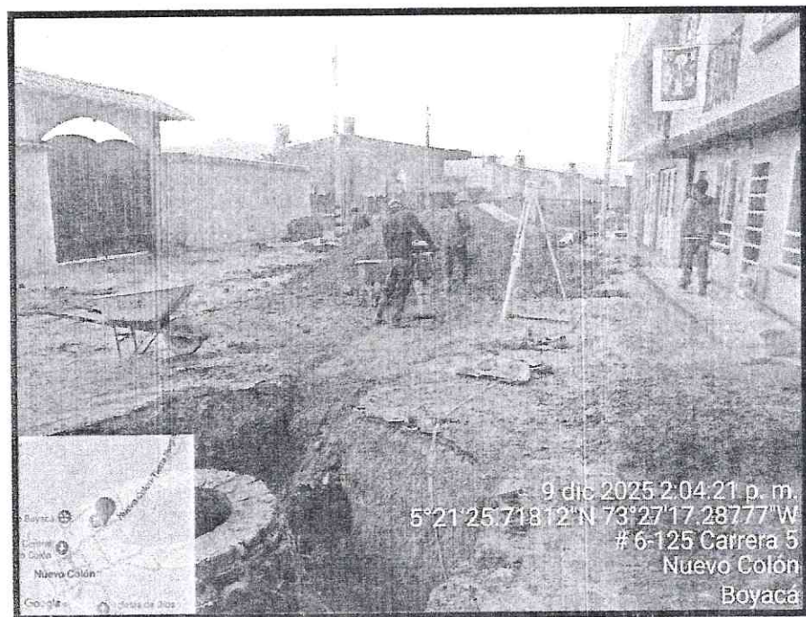
Foto 12: Suministro, instalación y compactación de recebo en red principal.
